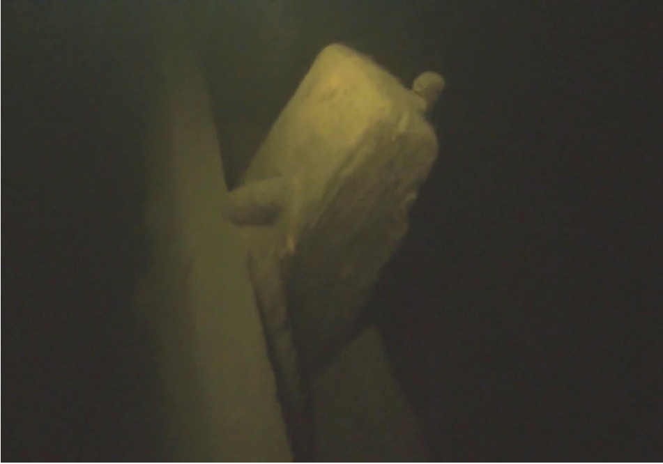
Kuva 10. Kylkikaaritusta ja sisä- ja ulkolaudoitusta sekä mahdollisesti riveystä laudoituksen ja kaaren välissä.
