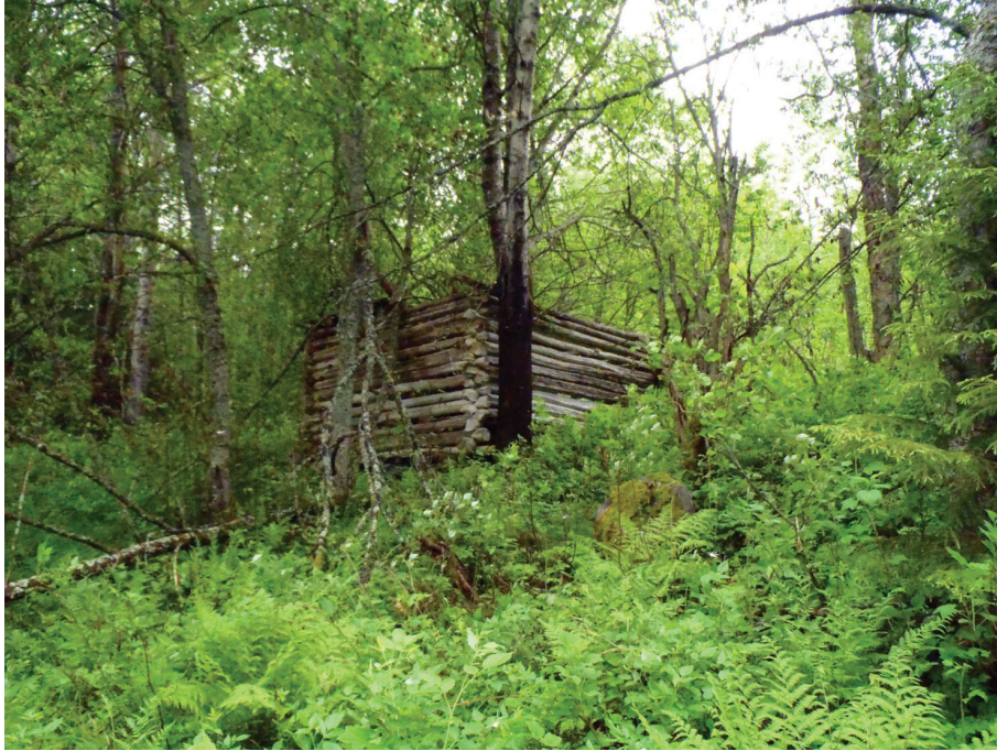
Yllä: P6200205: Pihlajavaaran Toukolan pohjoisempi lato jyrkässä rinteessä.
