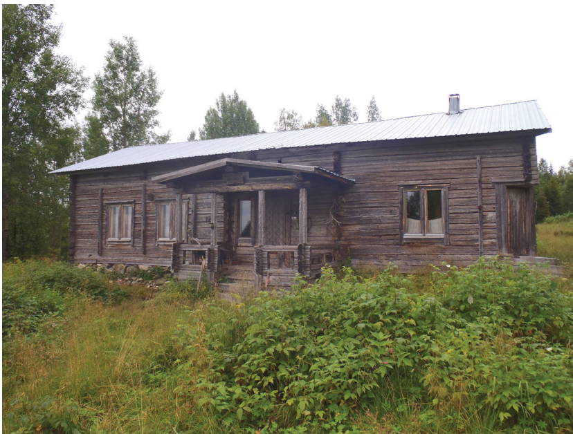
P8090263_edited-1.jpg: Latva-Kouvan päärakennus etelän puolelta. Vattupuskat ovat vallanneet pihamaata.
