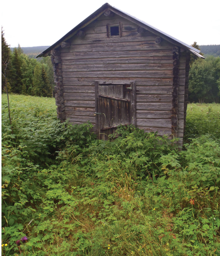
P8090286_edited-1.jpg: Pienempi päärakennuksen länsirinteessä sijaitsevista aitoista oli lukittu. Rakennus on huolellisesti salvottu, ja se seisoo kivijalan ja pienemmän hirsikehikon päällä.
