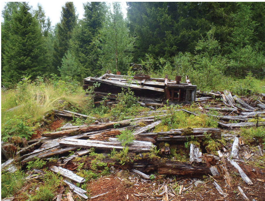
P8090320_edited-1.jpg: Puimakoneen alla ollut puinen rakenne on lahonnut ja levinnyt. Lieneekö käynyt niin, että Latva-Kouvan talonpito on loppunut juuri silloin, kun suomalaisessa maataloudessa siirryttiin muutenkin puimakoneista leikkuupuimureihin?
