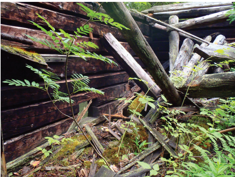
P8090246_edited-1.jpg (alakuva): Saunarakennuksen sisällä oli runsaasti rojua. Kattorakenteet olivat myös valahtaneet sisään. Sisäseinistä läntinen, alarinteen puolinen seinä oli kaikkein mustunein. Kuvassa näkyvä aukko on ikkunan kohta, lasi on hirren ulkosyrjällä.
