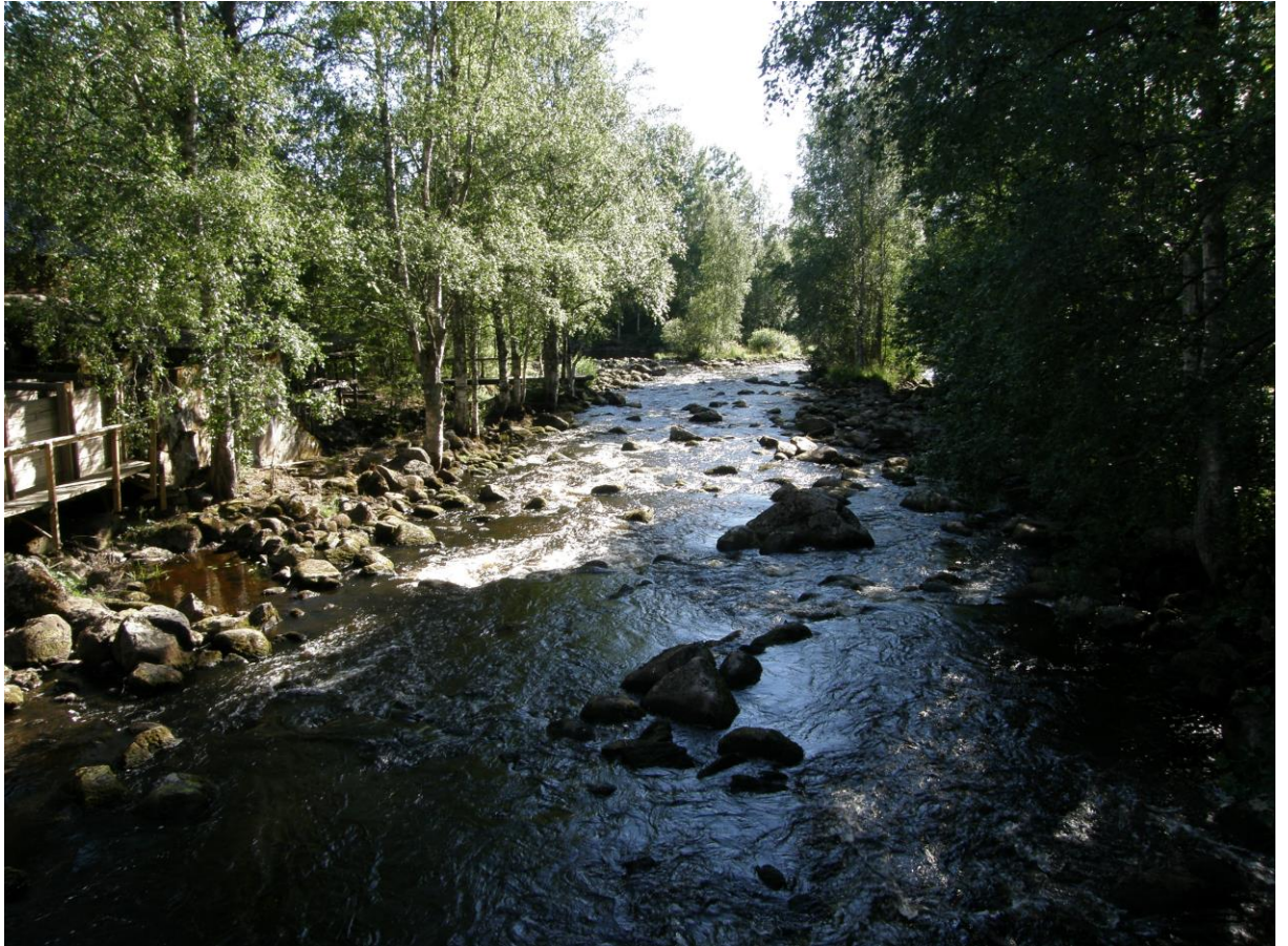
Kuva 3. Kairokosken rakenteita kesällä 2010.
