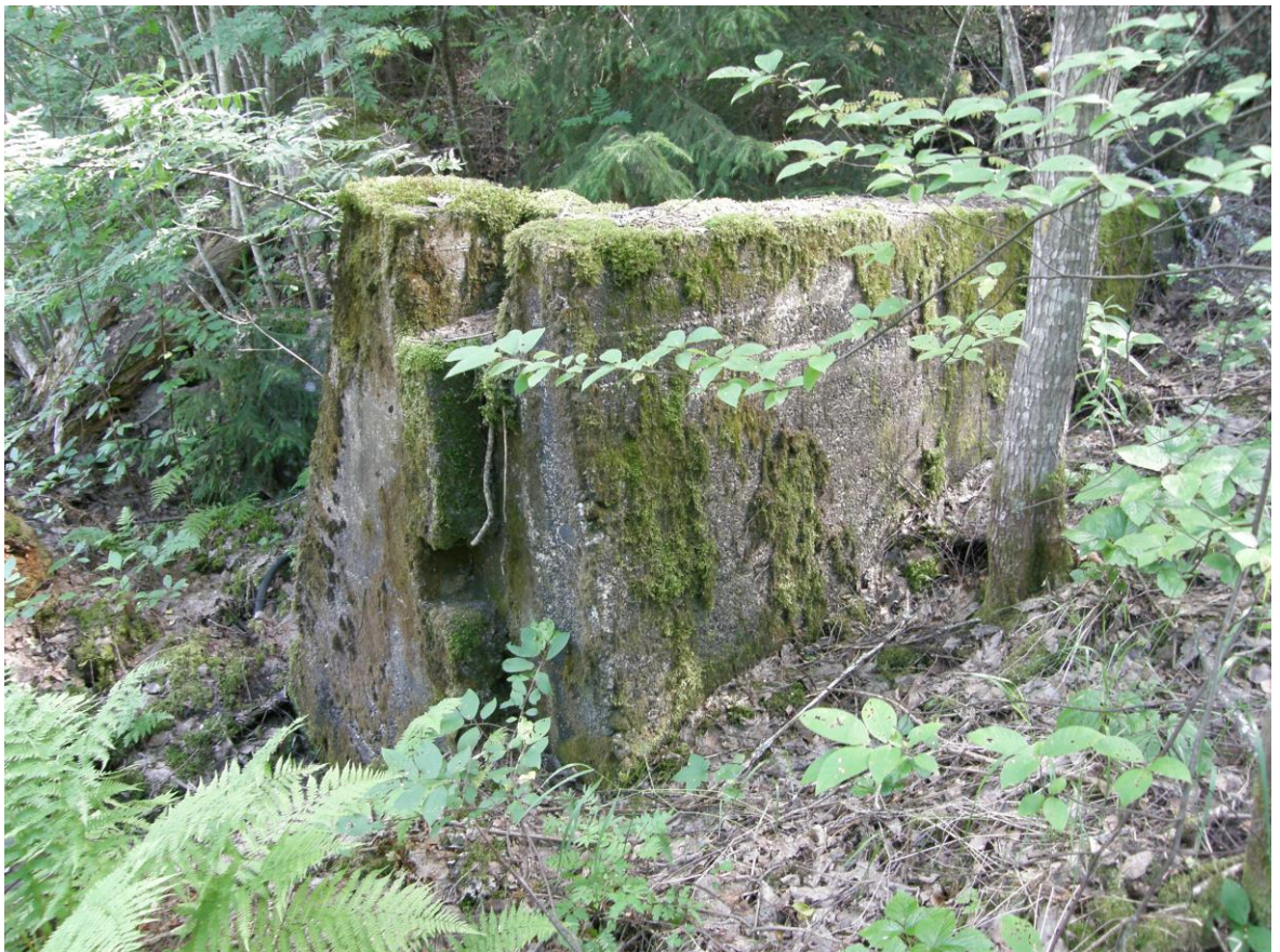
Kuva 13. Pappilankosken nuorempia rakenteita.
