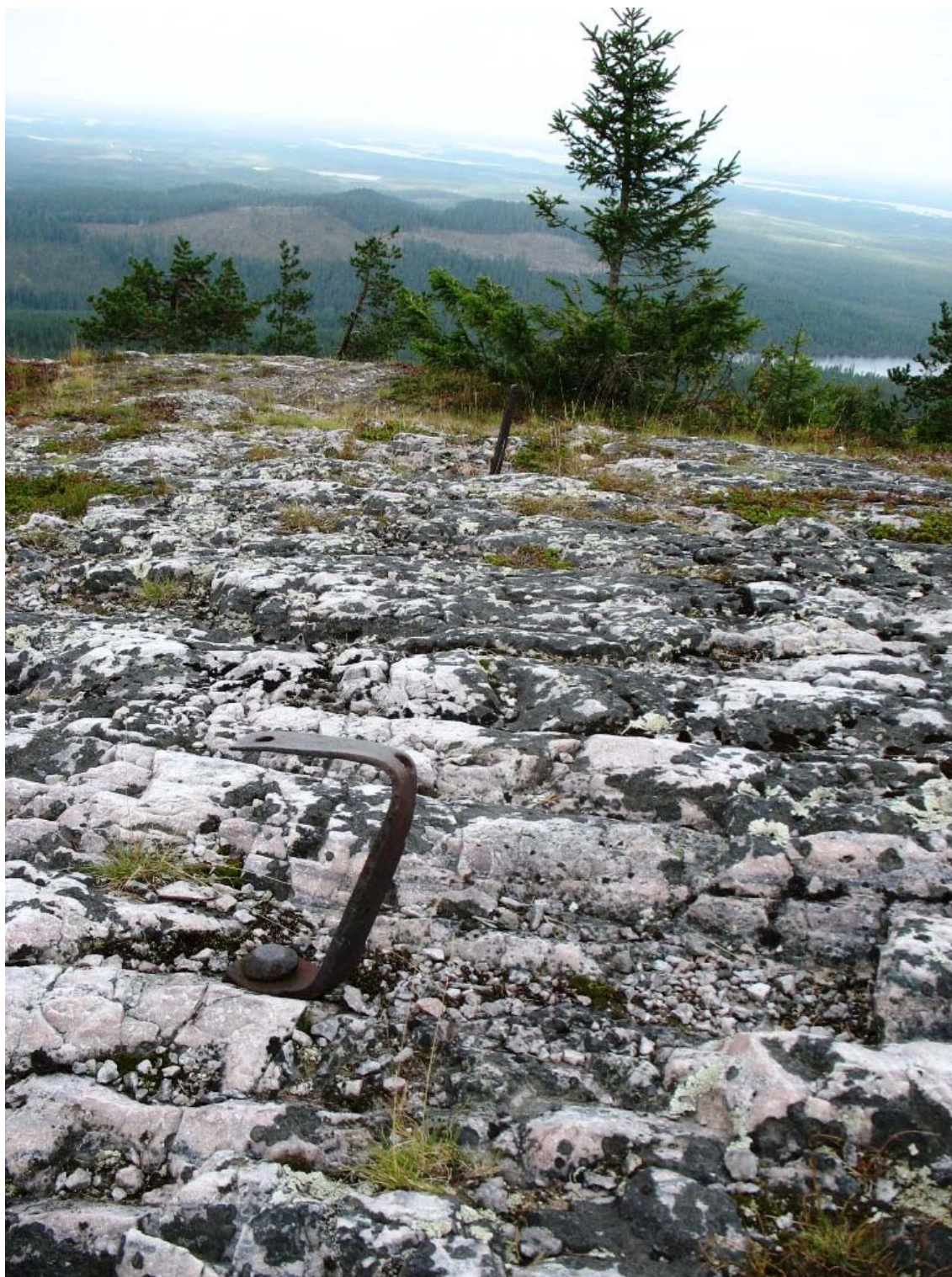
Kuva 3. Valtavaaran palovartiotorin kiinnitystapit (© Metsähallitus 2010).
