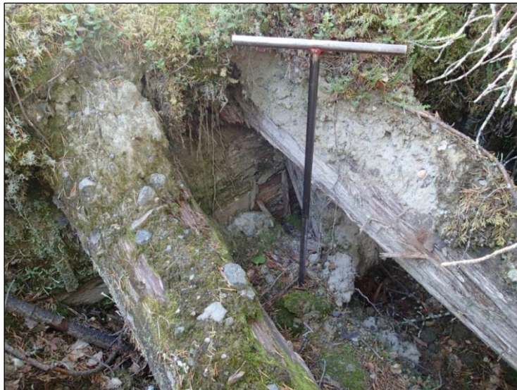
Nuolioja A. Maakellarin puisia rakenteita. Maanäyttekaira kuvassa mittakaavana.
