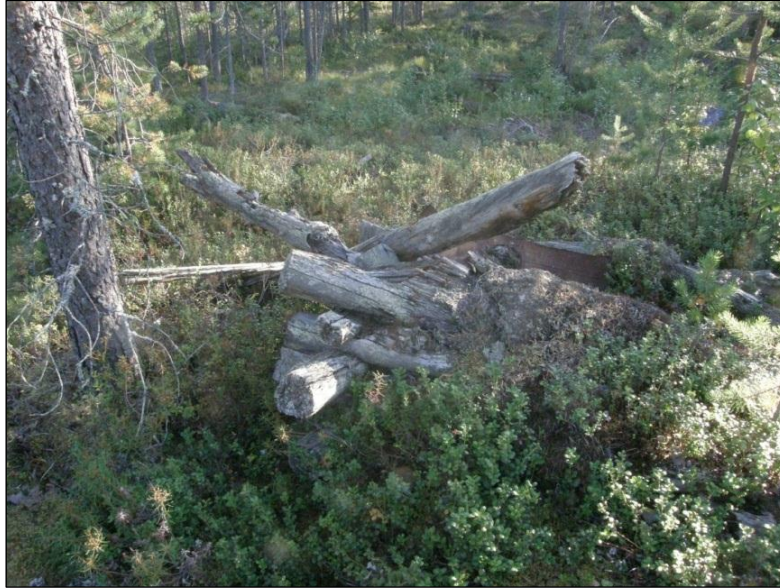
Sammallampi 2. Seinien jäänteitä ja nurkkasalvos perustusten ulkopuolella.
