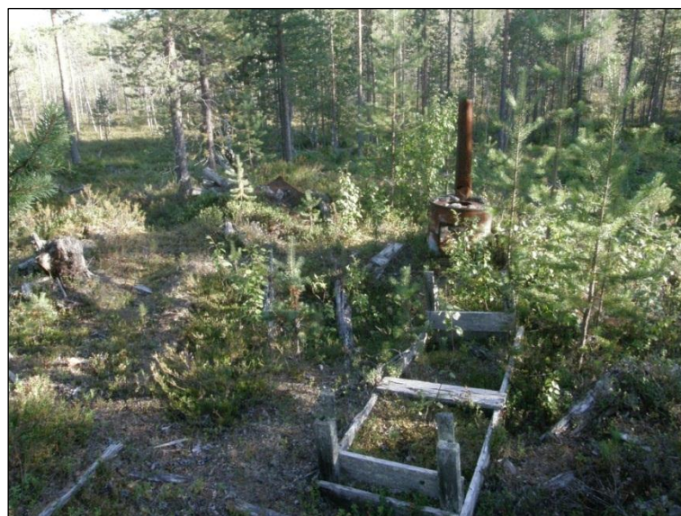
Sammallampi 2. Rakennuksen perustukset kuvattuna kaakkoon. Kaminan vasemmalla puolella näkyy muutamia lattian tukena olleita puuta ja niiden vasemmalla puolella seinän perustuksena ollut hiekkapenkki.
