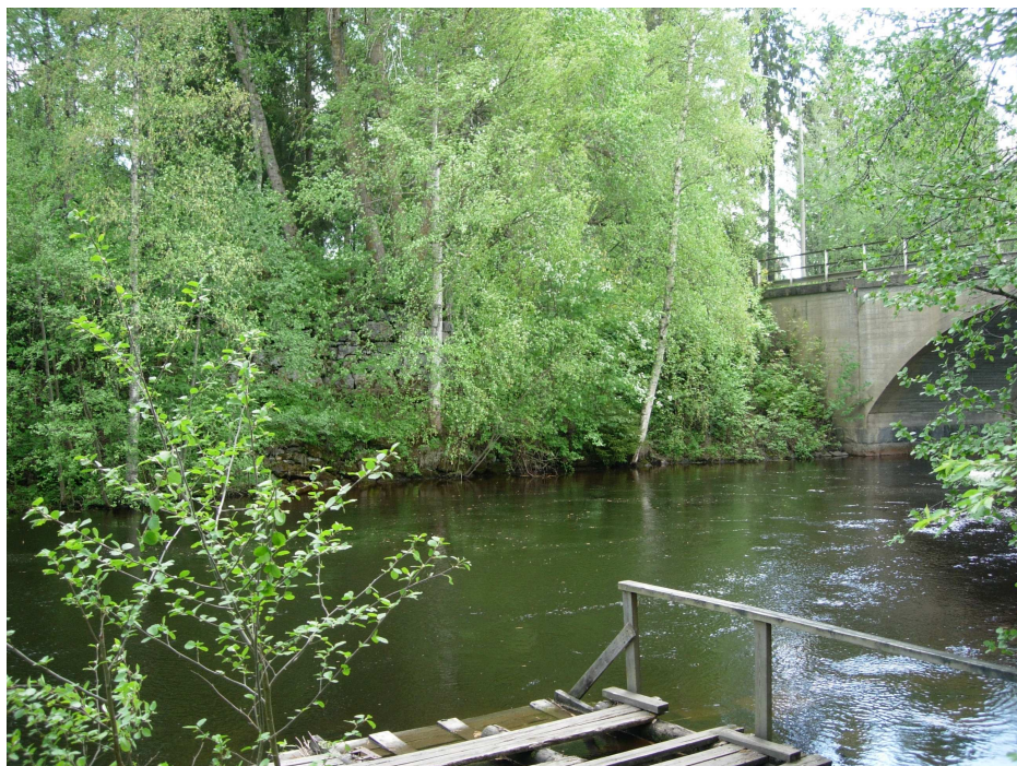
Kuva 9. Kohde Taipaaleenjoki (sillan jännökset) sijaitsee kuvassa näkyvän betonisen kaarisillan pohjoispuolella. Kuvassa erottuvat joen itärannalla olevat kiviset sillanjännökset. Kuvattu luoteesta. (Liperi, Viinijärven asemakaava-alueen arkeologinen inventointi 2012: 5)
