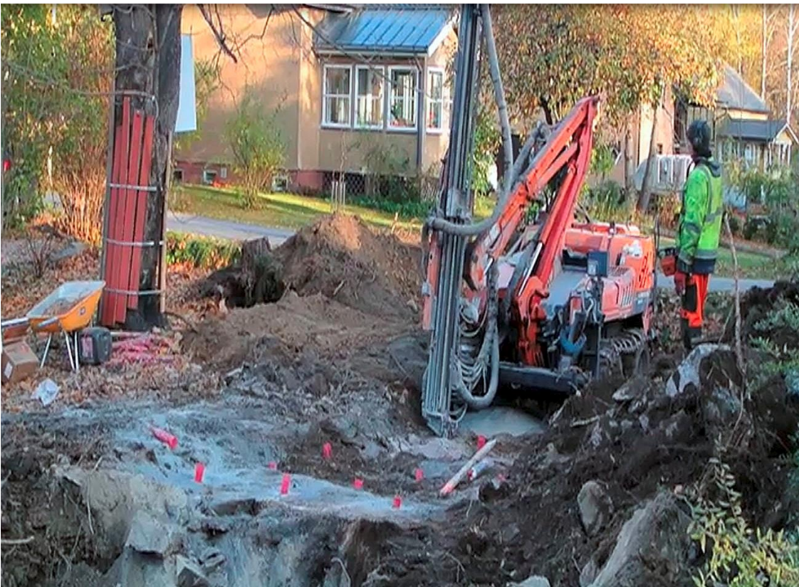
Putkikaivantolinjan louhintaa valmistellaan. Kuvakaappaus Tuomas Heimalan videosta. Kuvaussuunta SE. 21.10.2013.
