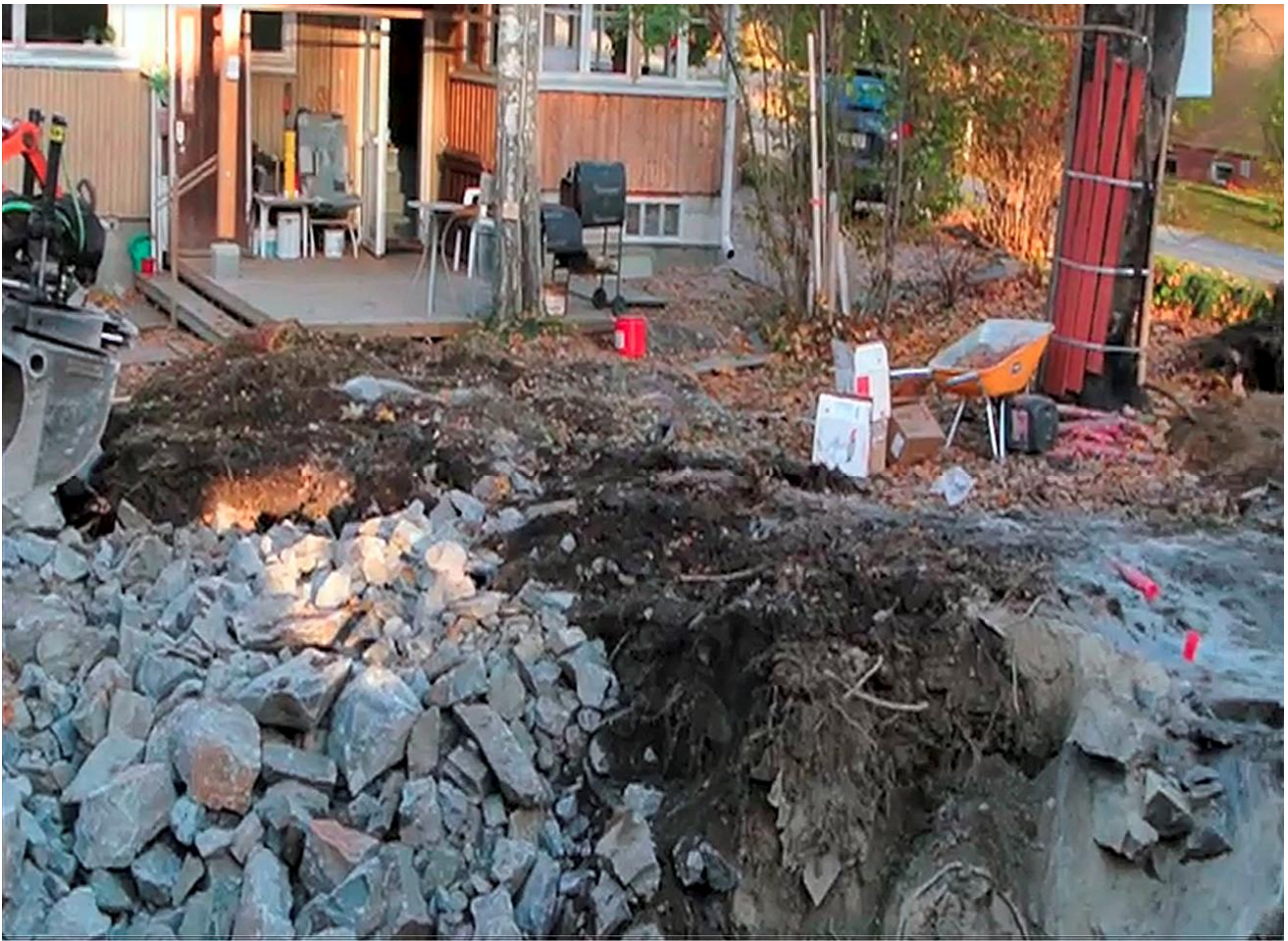
Rintasuojan kohta on louhittu. Taisteluhauta sijaitsee tumman maan kohdalla. Kuvakaappaus Tuomas Heimalan videosta. Kuvaussuunta E. 21.10.2013
