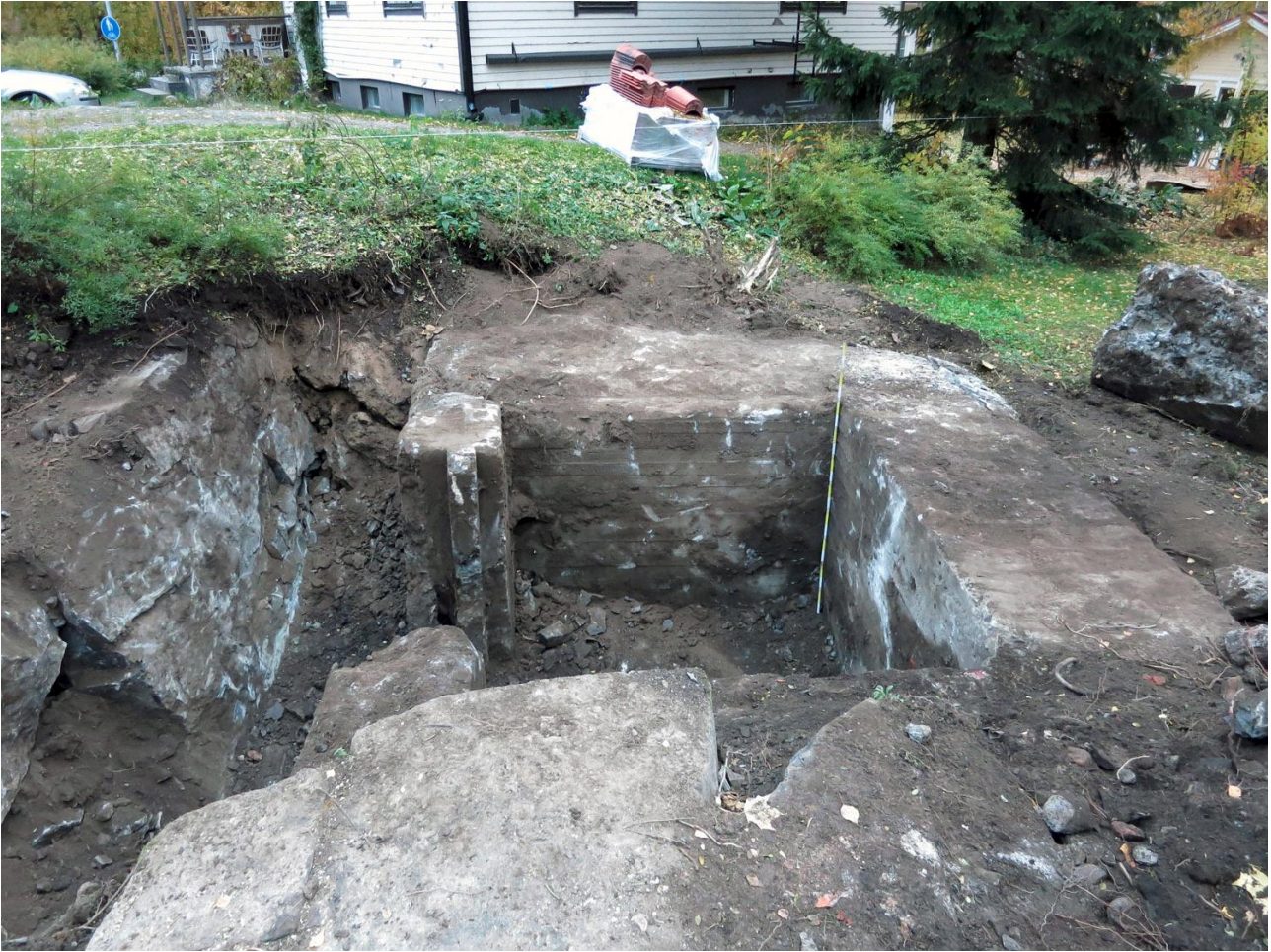
Suojahuone on otettu kokonaan esille. Kuvaussuunta SW. HKM/Helsinki, Kaarela 2013:26.
