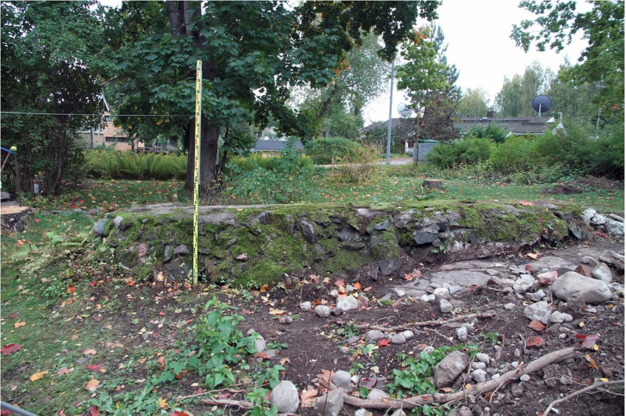
Rintasuojan pitkä suora osuus torjuntasuunnasta kuvattuna. Kuvaussuunta SE. HKM/Helsinki, Kaarela2013:13.
