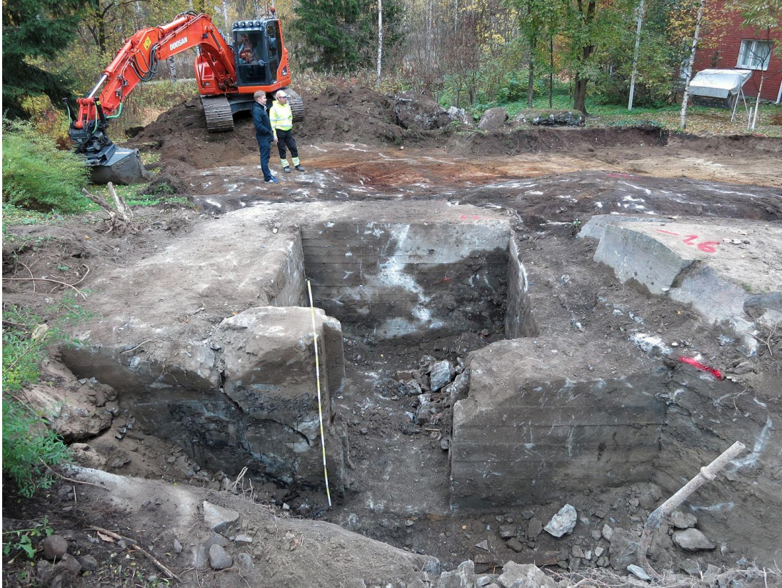
Kuva 53. Suojahuone ja sen pohjoispuolelta paljastetut kalliot ja hiekat uuden talon kohdalla. Kuvasuunta NW. 15.10.2013.
