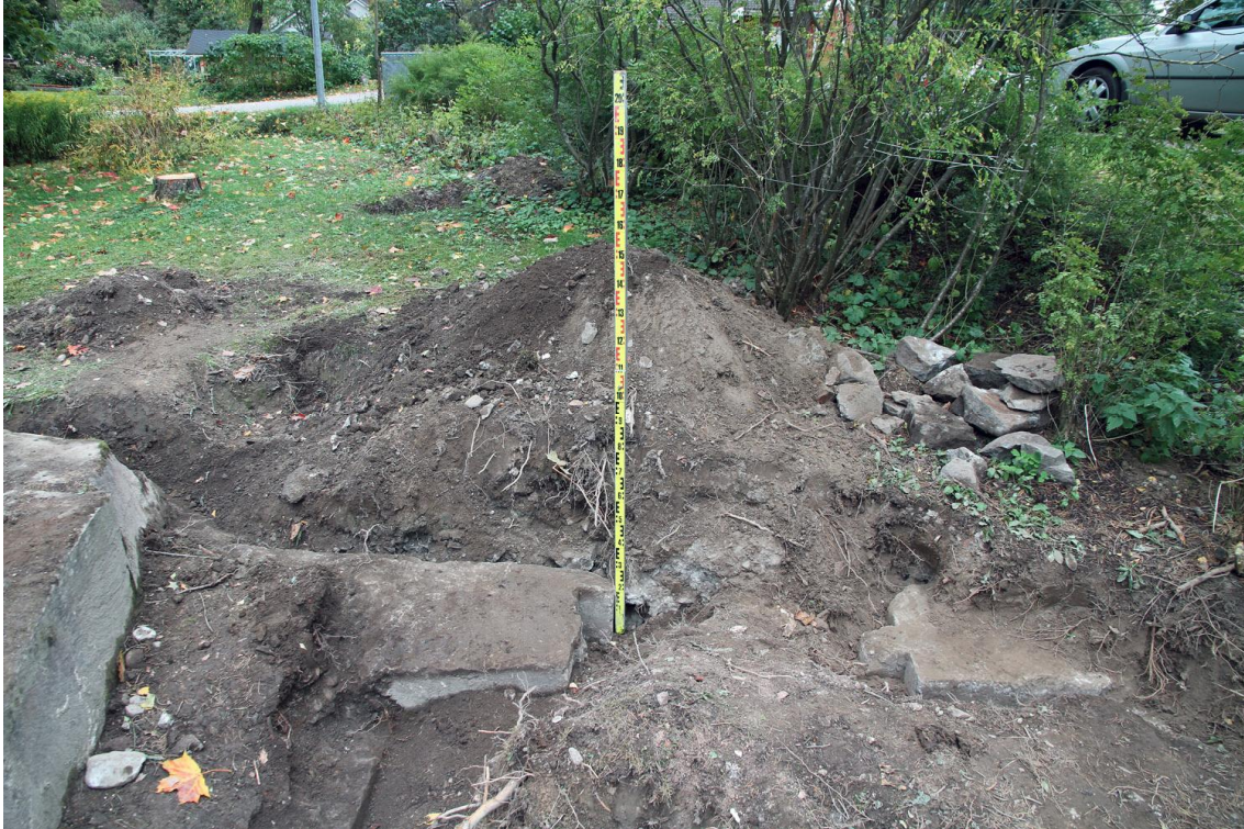
Kuva 19. Suojahuoneen eteläseinä. Kuvaussuunta SE. 27.9.2013.
