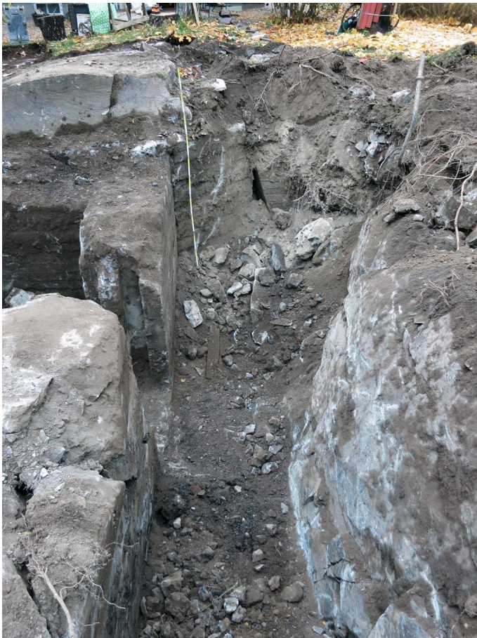
Kuva 42. Suojahuoneen eteläpuoliseen kallioon oli louhittu kapea käytävä. Kuvaussuunta NE. 15.10.2013.
