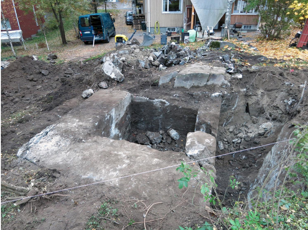
Kuva 35. Etualalla suojahuone ja oikealla kallioon louhittu käytävä. Taisteluhaudan rintavarustus louhimattoman kallion päältä on poistettu taustalla. Kuvaussuunta NE. 15.10.2013.
