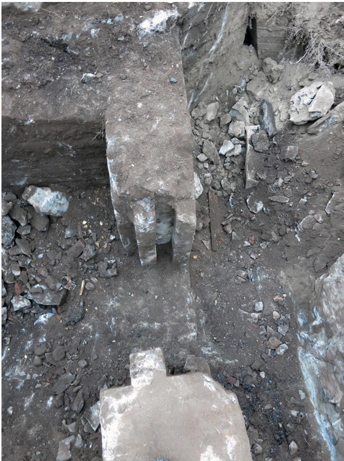
Kuva 34. Eteläseinä ja oviaukko. Kuvaussuunta NE. 15.10.2013.
