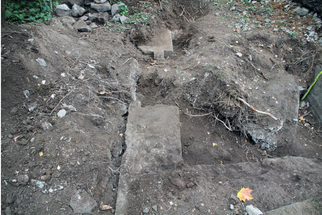
Kuva 15. Suojahuoneen eteläseinä ja oviaukko. Kuvaussuunta SW. 27.9.2013.
