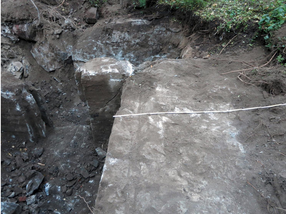
Kuva 31. Suojahuoneen länsiseinä. Seinän yläpinta on sisäreunalla kapealla vyöhykkeellä matalammalla kuin muualla. Kuvaussuunta SE. 15.10.2013.
