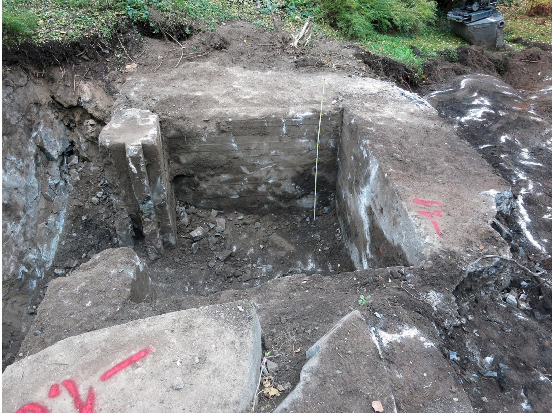
Kuva 51. Suojahuone piti purkaa rakennuksen tieltä. Vain lounaisnurkka säilyi. Kuvasuunta SW. 15.10.2013.
