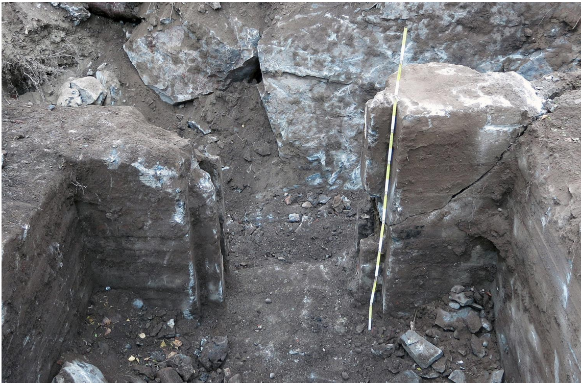
Kuva 30. Lähikuva oviaukosta. Oviaukon vasemman puolen seinän yläpinnasta on lähtenyt osa pois koneellisessa kaivauksessa aikaisempiin kuviin verrattaessa. Samoin oikean puolen seinämä on haljennut. Kuvaussuunta SE. 15.10.2013.
