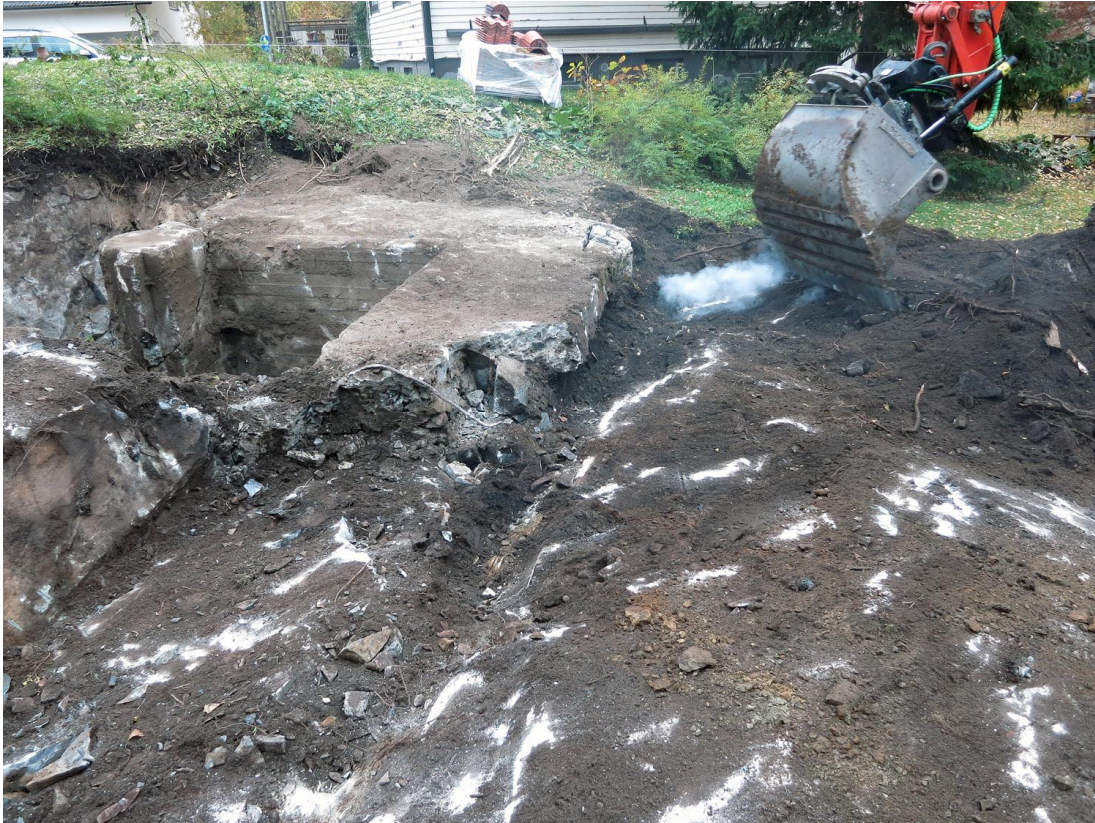
Kuva 49. Suojahuoneen pohjoispuolella poistetaan maata. kallio on melko pinnassa. Kuvasuunta SW. 15.10.2013.
