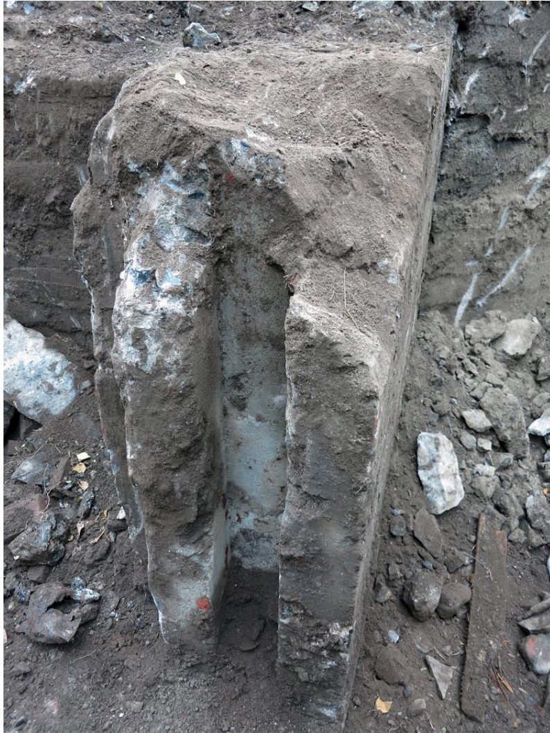
Kuva 39. Oviaukon itäpuoli. Kuvaussuunta NE. 15.10.2013.
