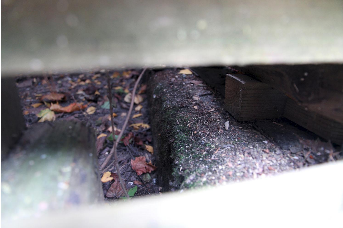
Kuva 7. Betonirakennetta terassin alla. Kuvaussuunta SE. 27.9.2013.
