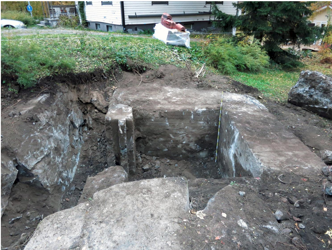
Kuva 26. Suojahuone koneellisen kaivamisen ja käsin tehdyn puhdistuksen jälkeen. Kuvaussuunta SW. 15.10.2013.
