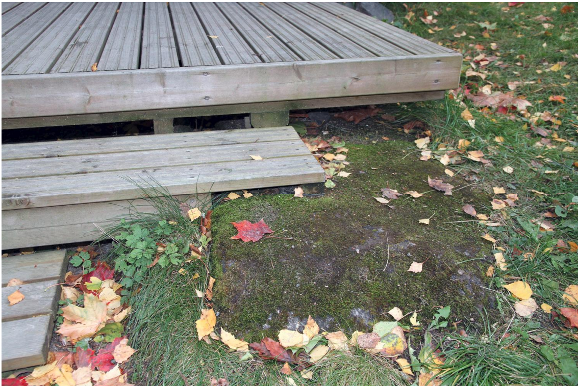
Kuva 6. Lähikuva edellisestä. Kuvaussuunta SE. 27.9.2013.
