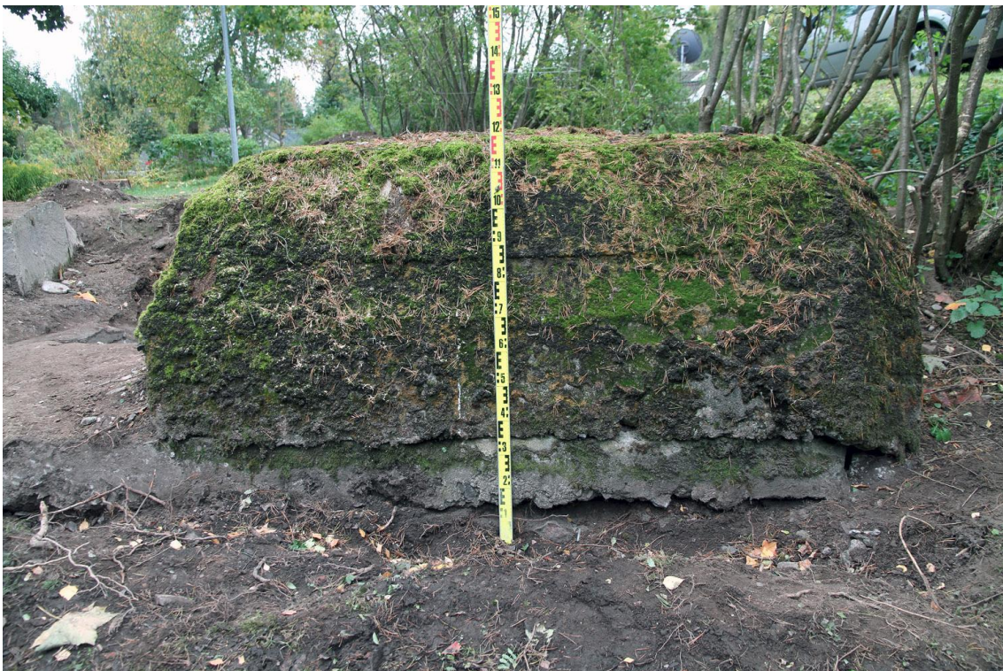
Kuva 24. Lähikuva edellisestä. Suojahuoneen maan alla olleet osat näkyvät sammaloitumattomina. Kuvaussuunta SE. 27.9.2013.
