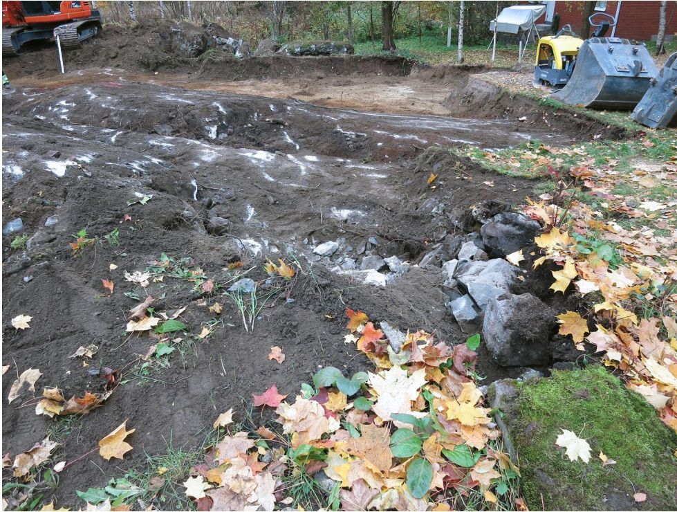
Kuva 55. Taisteluhaudan NW-SE – suuntaisen seinän purettu pohjoispää. Kuvasuunta NW. 15.10.2013.
