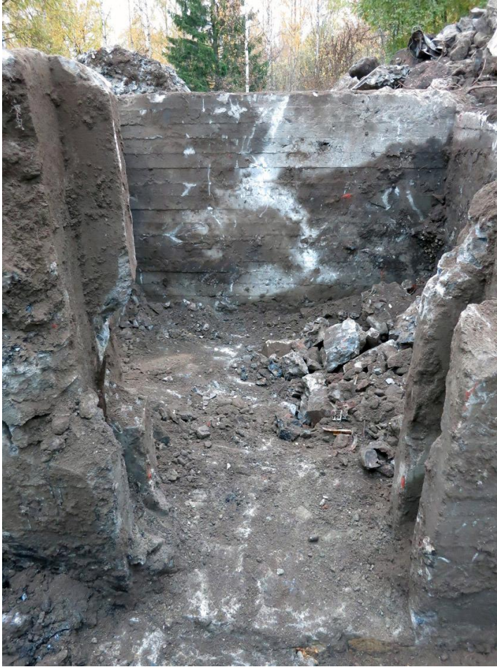
Kuva 37. Lähikuva suojahuoneesta oviaukon kautta kuvattuna. Kuvaussuunta NW.15.10.2013.
