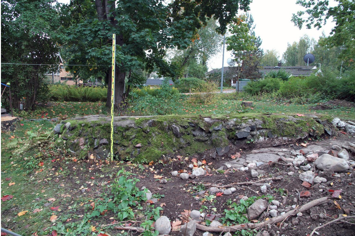
Kuva 13. Lähikuva edellisestä. Viisto ulkoreuna muodostui betonista ja kivistä. Sen edustalta on todennäköisesti poistettu maa jo ennen kuvassa näkyvää rakenteen alaosan ja kallion esille ottoa. Kuvaussuunta SE. 27.9.2013.
