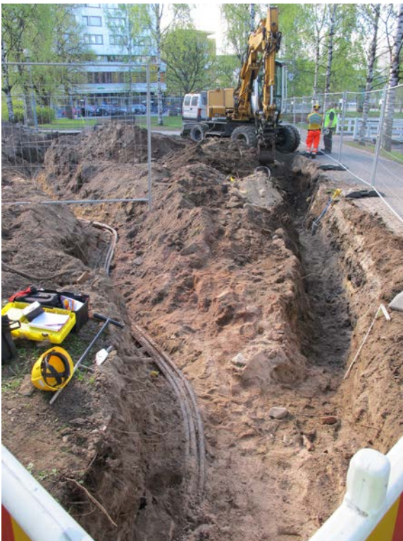
Kuva 21. Kaapelikaivanto (AKDG3270:4). Vanha kaapelipaikka kuvassa vasemmalla, uusi oikealla.
