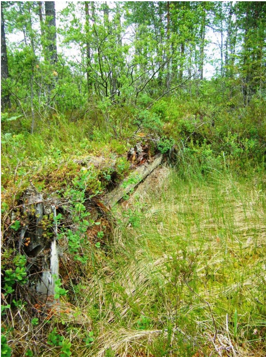
Rosvohodun padon rakenteita suolla.
