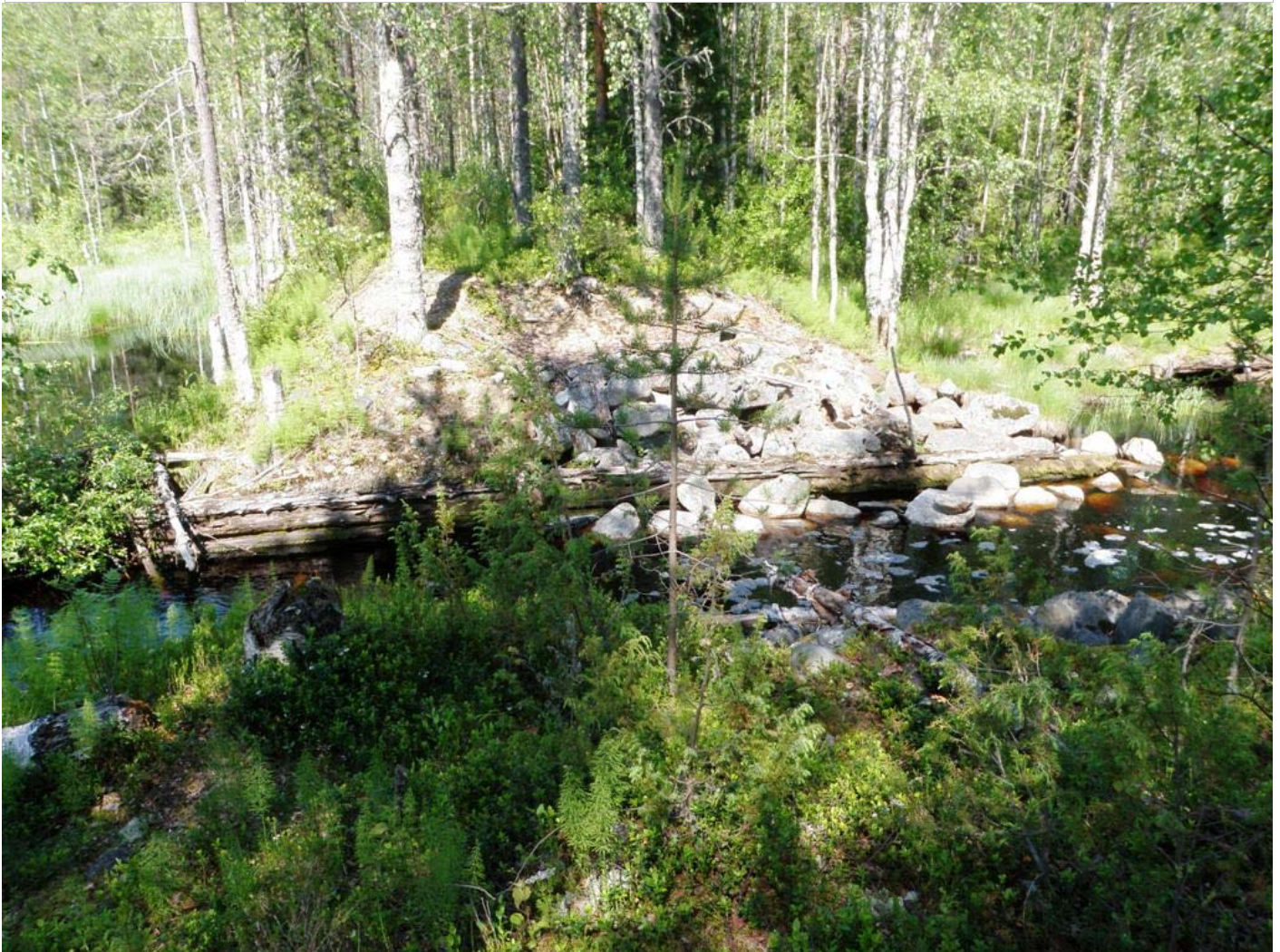
Uittopadon portin rakenteita.
