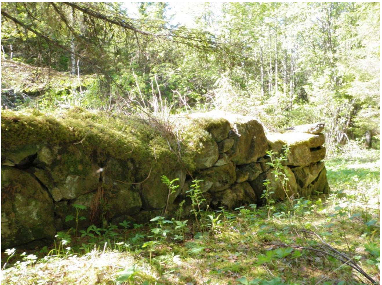
Lantalan ladottua kiviseinää.
