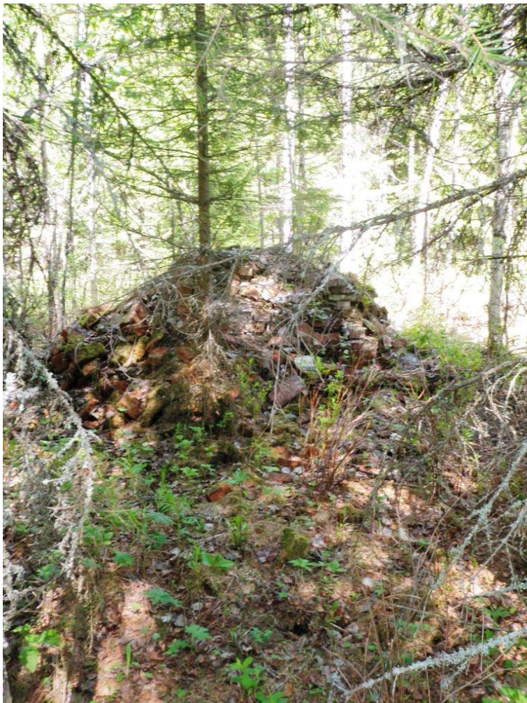
Kuva 1: Päärakennuksen purettu jäännös. Etualalla kivijalan nurkka jonka sisällä uuninjäännös.
