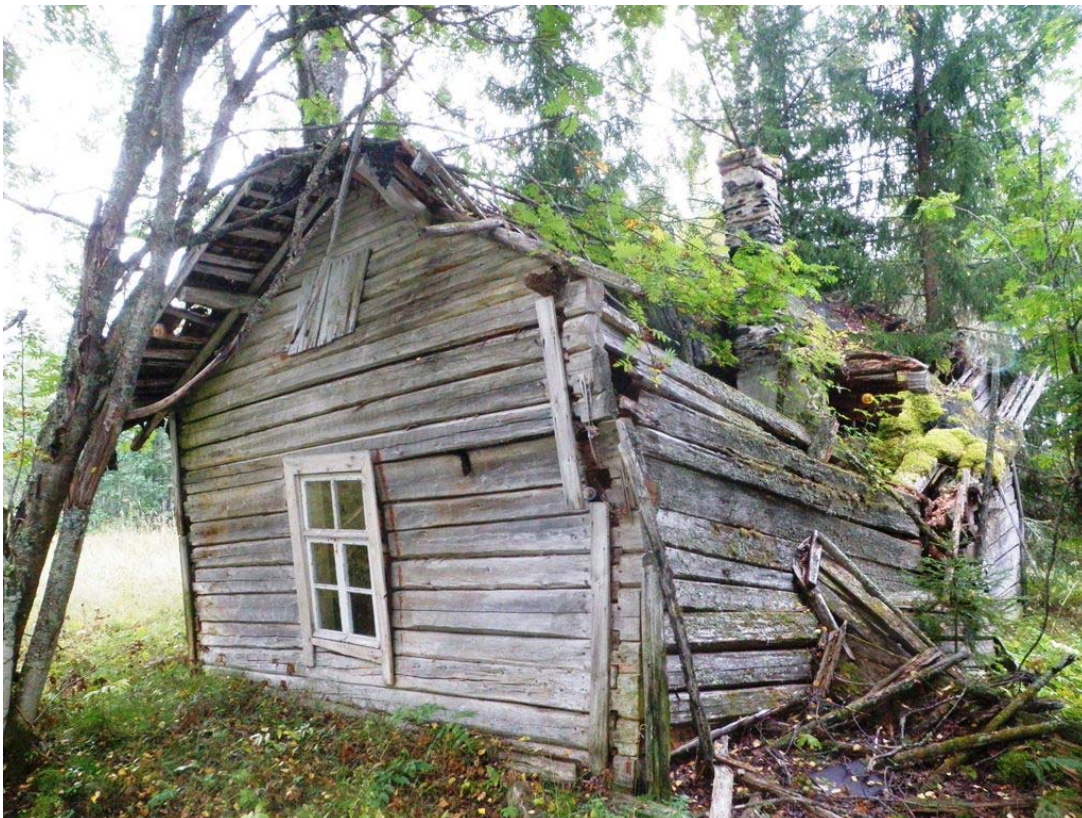
Kujanginlehdon päärakennus kuvattuna pohjoisesta.
