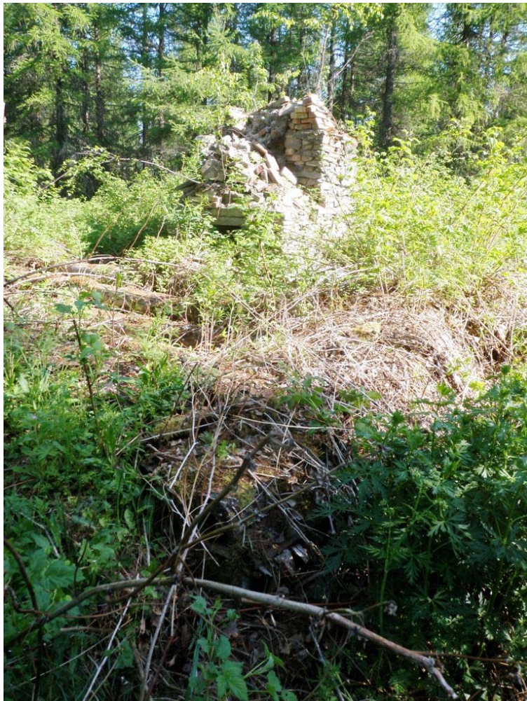
Päärakennuksen purettu jäännös. Etualalla kivijalkaa, taustalla uunin jäännös.
