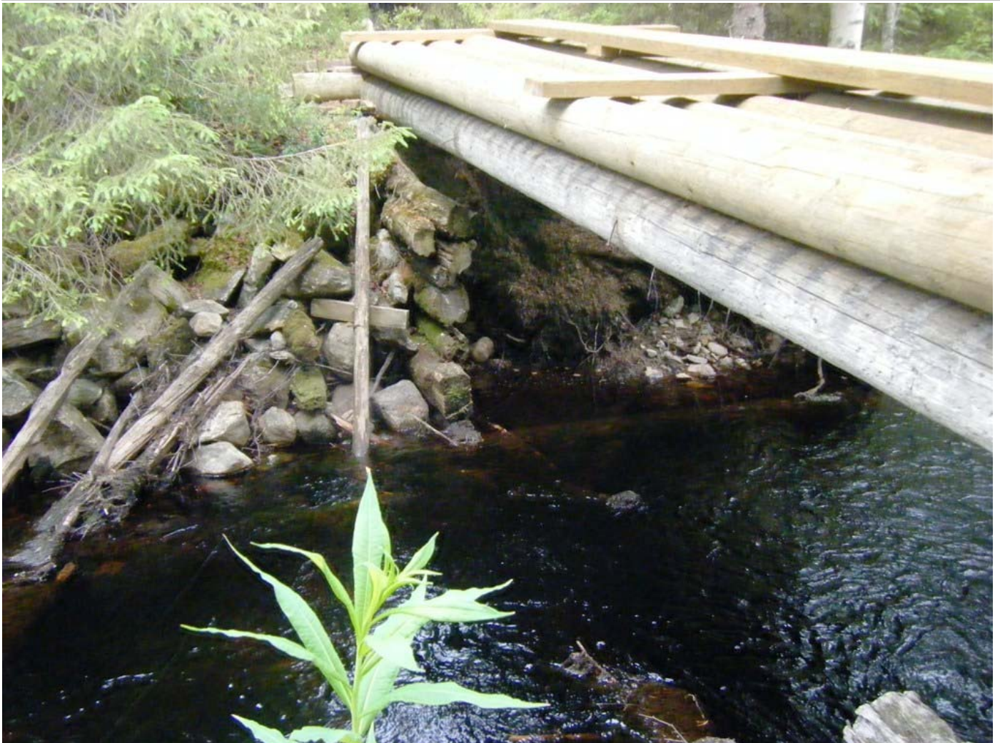
Uittopadon rakenteita polkusillan alla. Kuvaussuunta luode.
