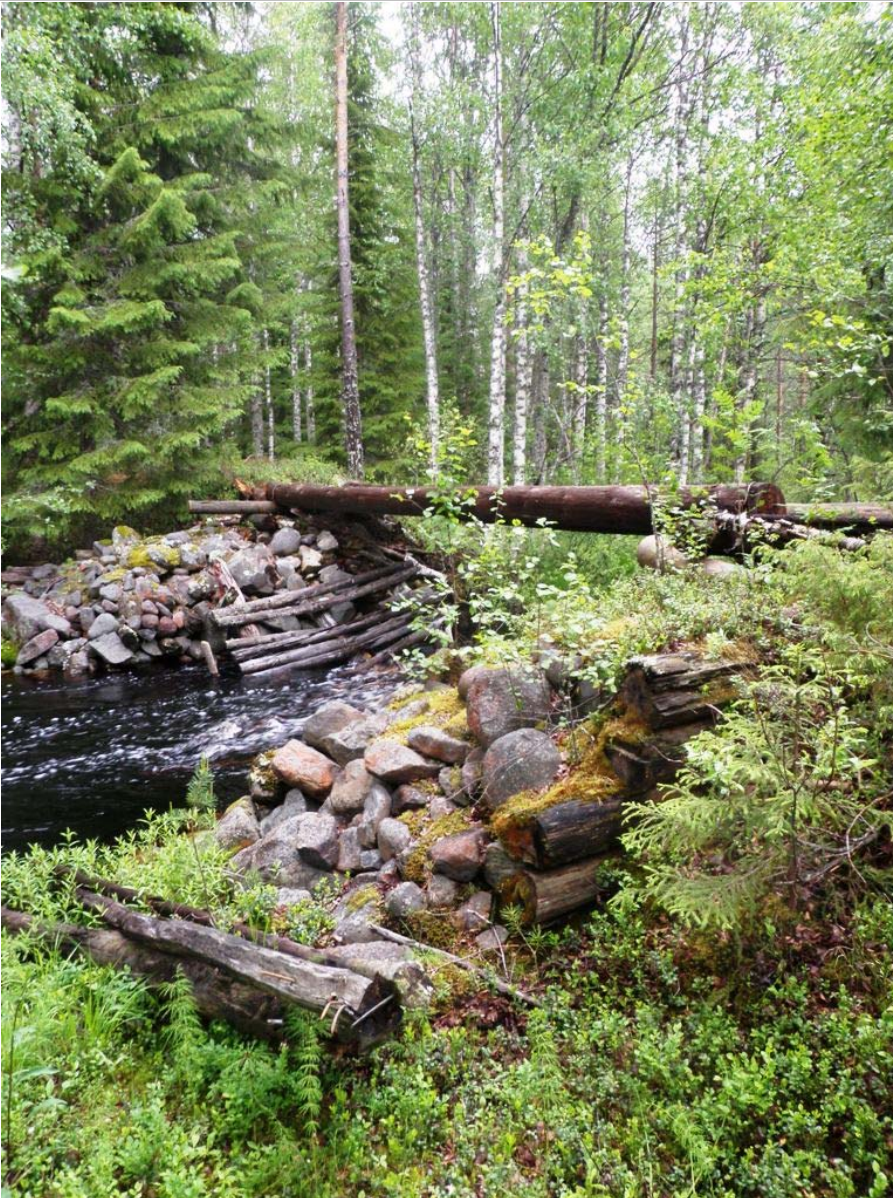
Uittopadon portin rakenteita ja yli kulkevat hirret.
