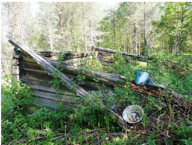
Kuva 2: Osittain pystyssä olevan pelkkahirsisen ulkorakennuksen, mahdollisesti navetan jäännös.
