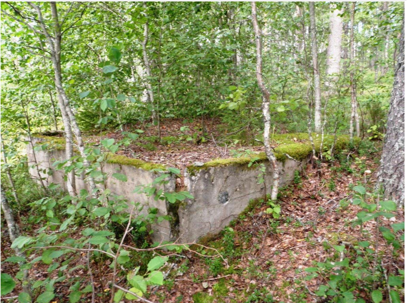
Betonista valettu saunan pohja.
