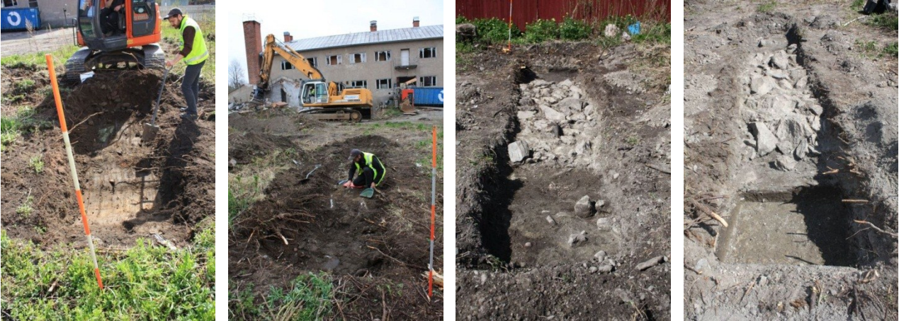
AKDG3158:18, 21, 25 ja 35. Vasemmalta oikealle: Ville Rohiola valvoo koeojan 4 avaamista, kuvattu lännestä. Ville Rohiola puhdistaa koeojasta 4 löytynyttä kiveystä, kuvattu lännestä. Koeoja 4 kiveys kuvattuna lännestä. Koeojan 4 kiveyksen länsipuolelle tehty koekuoppa (KK 8) kuvattuna lännestä. Kuvat Esa Mikkola, Arkeologiset kenttäpalvelut
