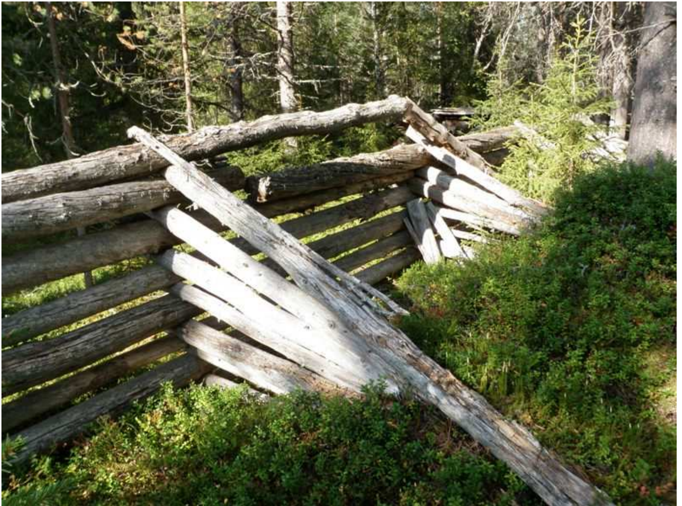
Räkkäsuojan aita on tukevasti tuettu ulkopuolelta.
