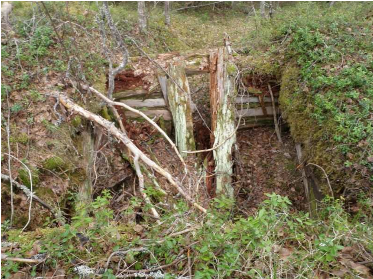
Kämpän kellarin maavallin sisällä on hirsikehikko. Ovi on kuvan takareunan keskellä.
