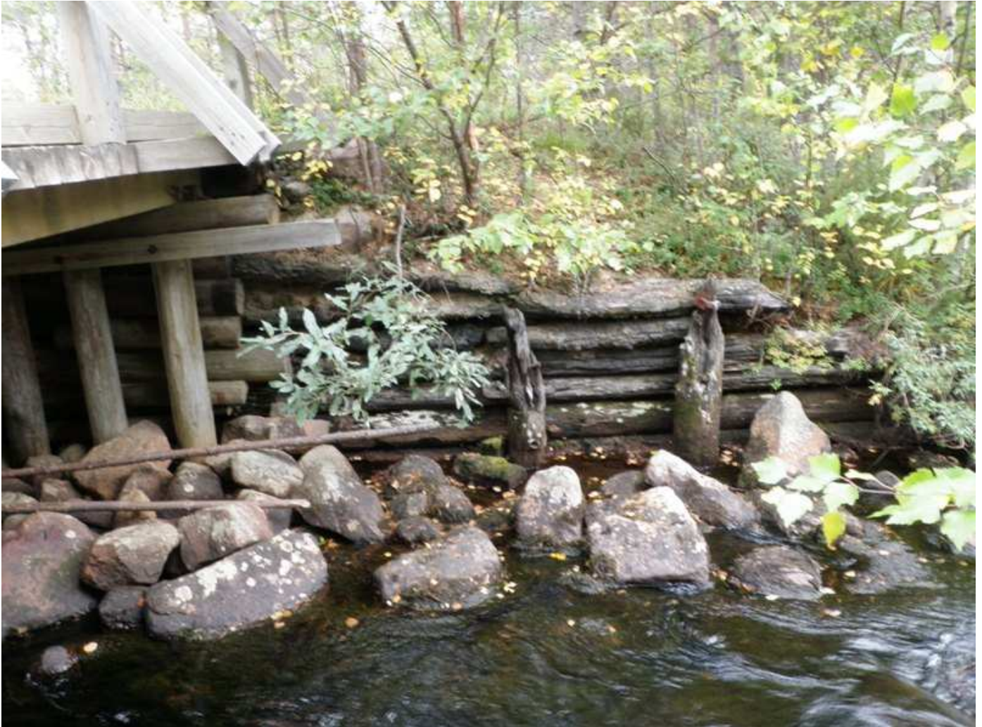
Vanhan sillan rakenteita uuden sillan alla.
