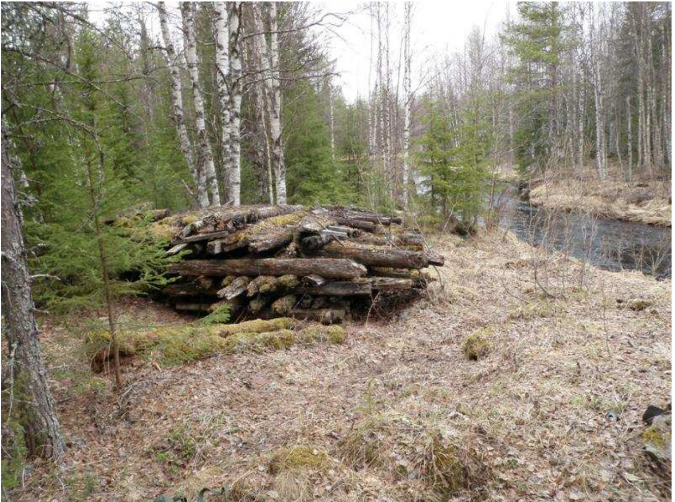
Puretun sillan rakenteet on kasattu joen rannalle.
