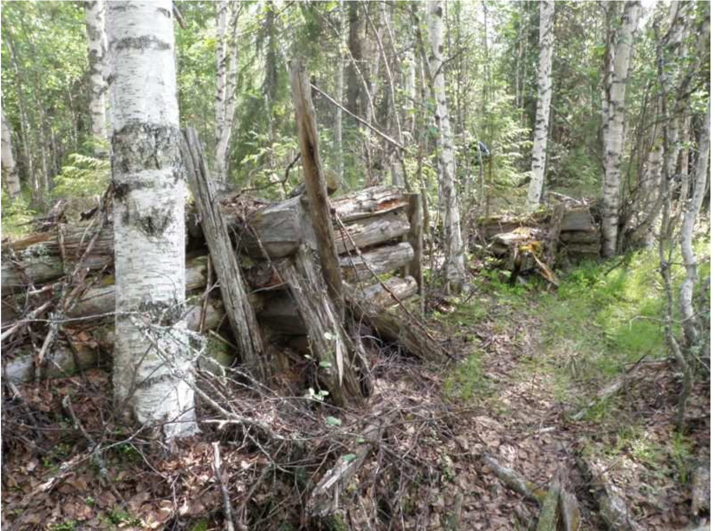
Tiskijoen metsätyökämpän lahonneita seinärakenteita.
