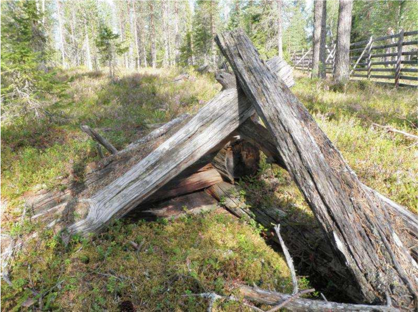
Vanhan aidan tukirakenteen salvoksia. Taustalla on yhä käytössä oleva uusi poroaita.
