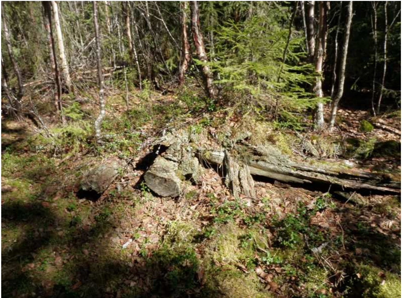
Kämpä on kasvillisuuden peitossa. Kuvassa nurkan salvoksia.
