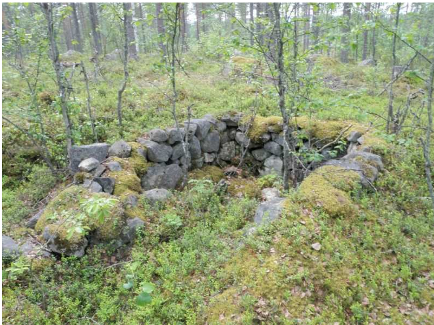
Kämpän kellarin kylmämuurattua perustusta.
