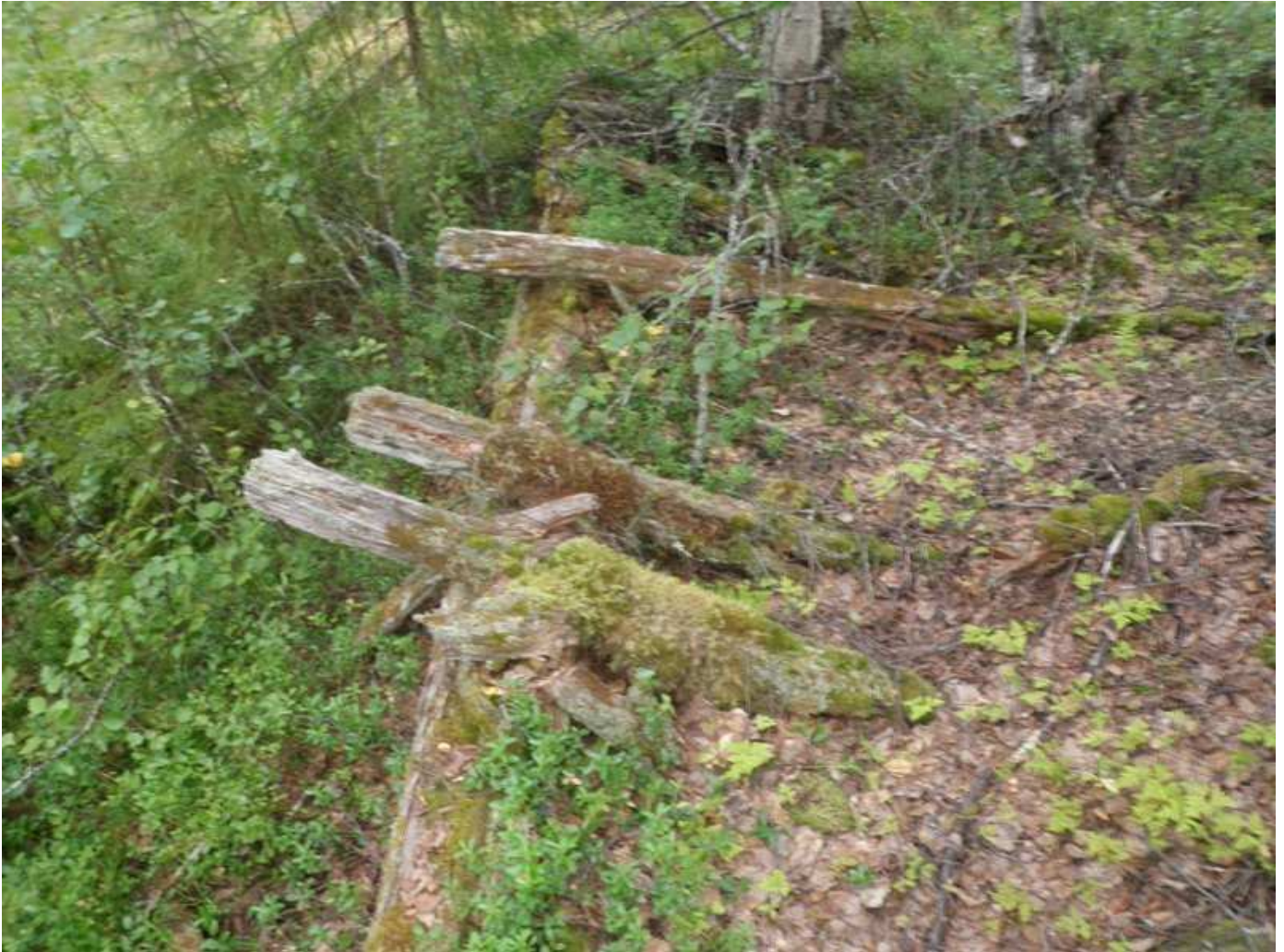
Kämpän seinähirsi, jonka päällä on katon niskapuut. Kämpä on ilmeisesti ollut viereisen tammen uitonmiesten tukikohta.
