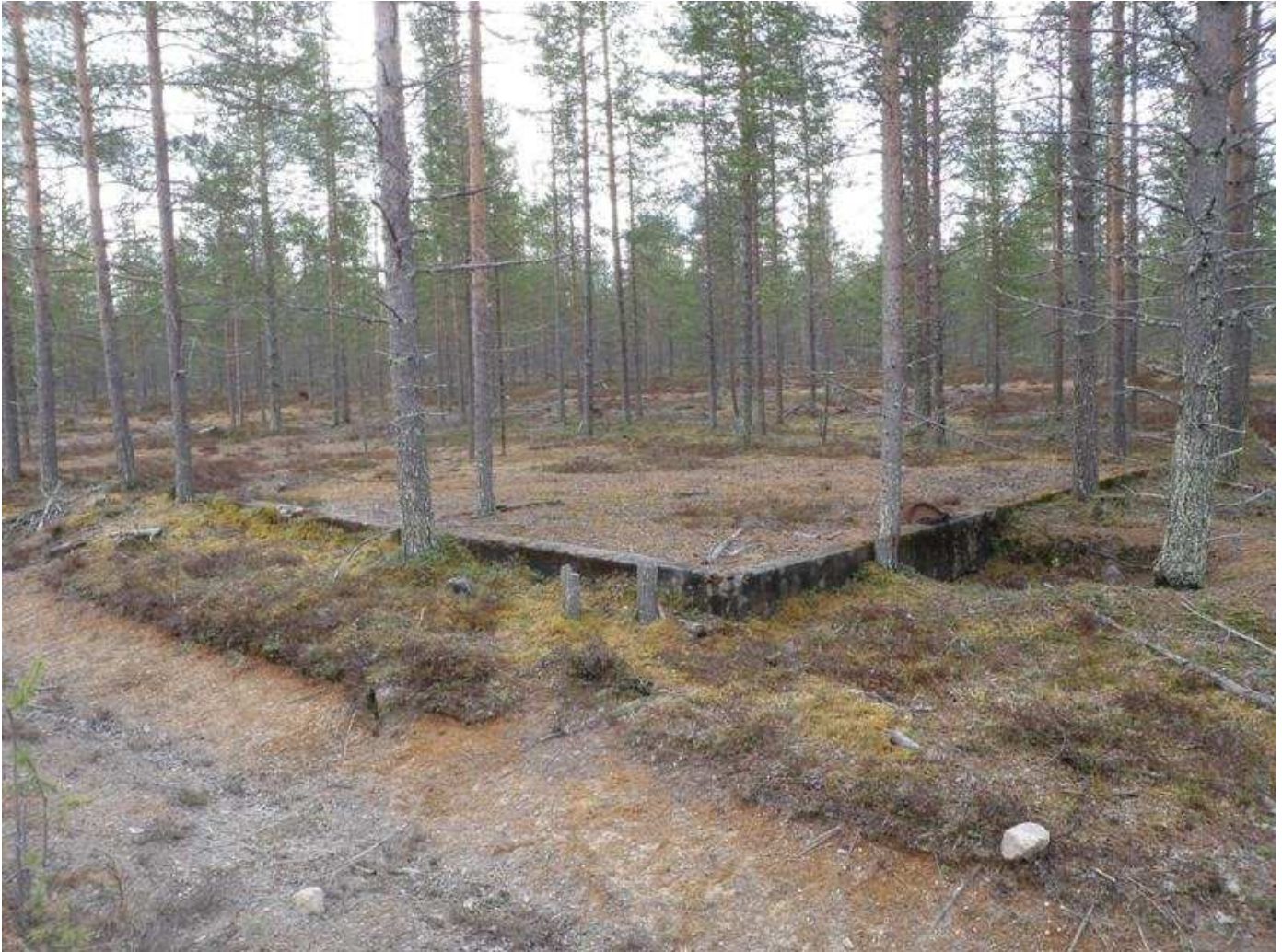
Saksalaisen parakin betoninen sokkeli sijaitsee aivan nykyisen hiekkatien vieressä.
