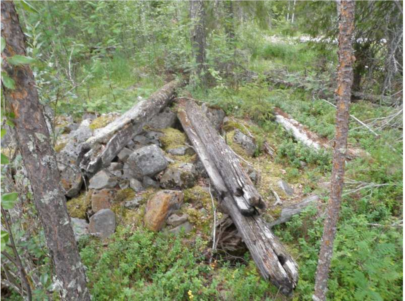
Uittopadon kivivallin päällä on vielä jäljellä hirsii puisesta padon yläosasta.
