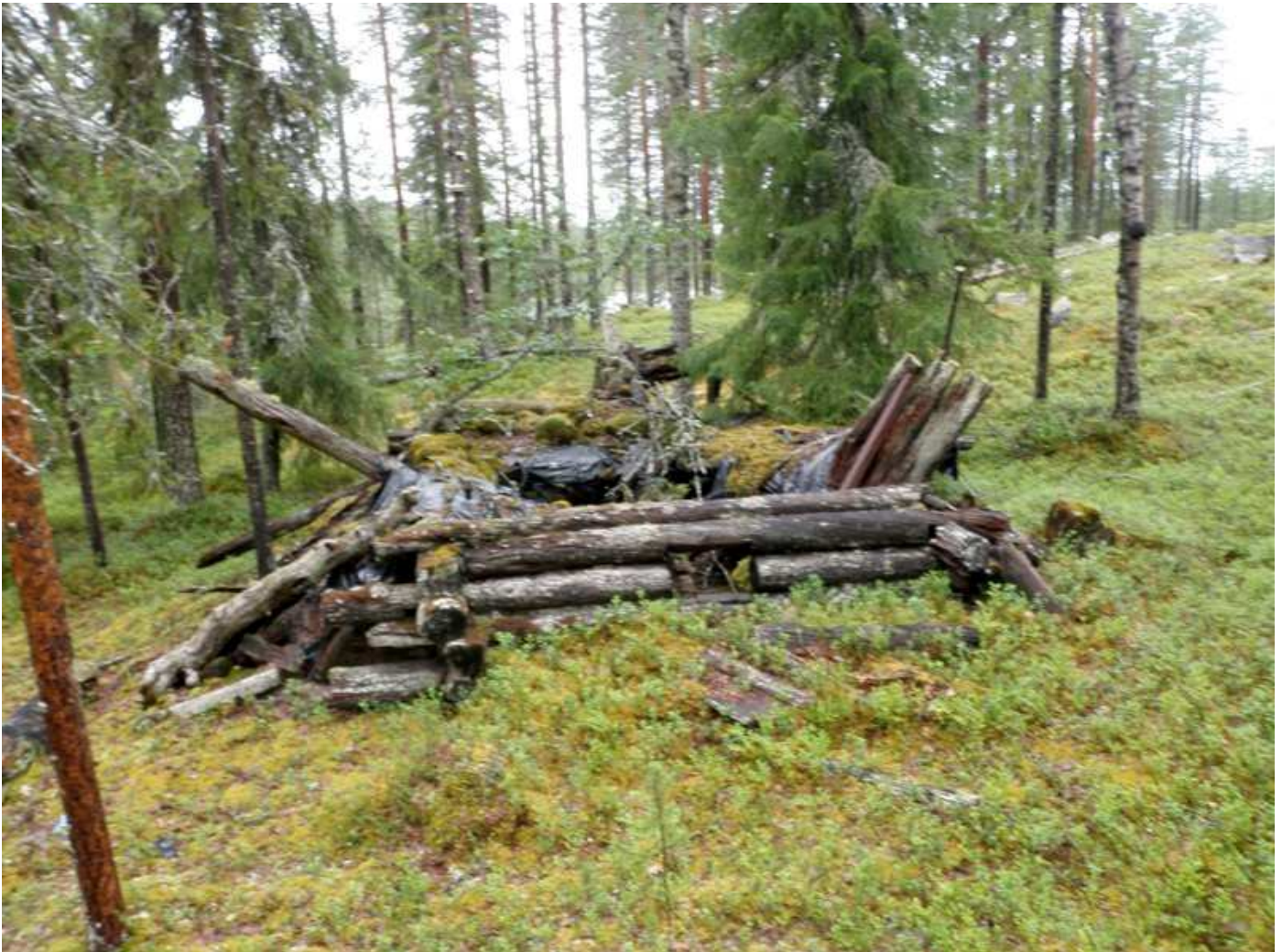
Piilopirtin katto on romahtanut sisään. Rakennuksen sisällä on kamiina.
