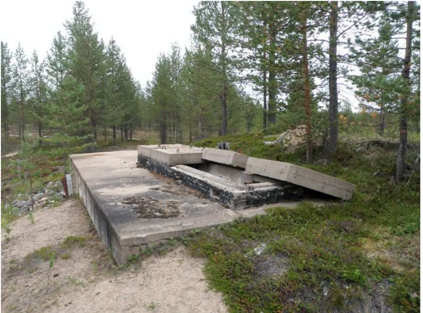
Bunkkerin betoninen kansi.
