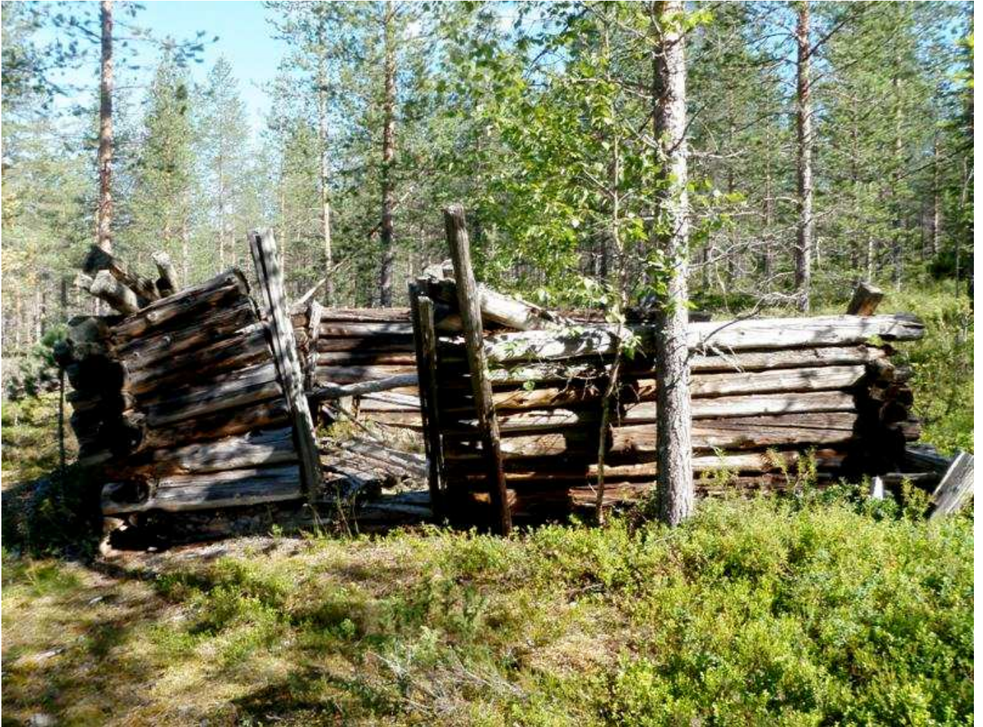
Kämpän hirret ovat hyvin säilyneet vaikka katto on romahtanut rakennelman sisään.
