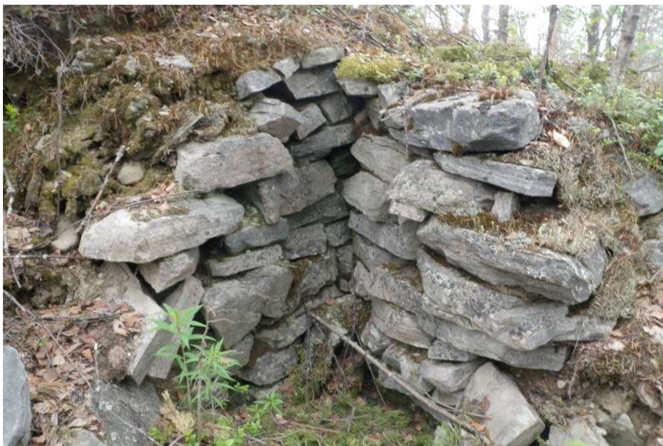
Kämpän kellarin kylmämuurattu nurkkarakennelma.
