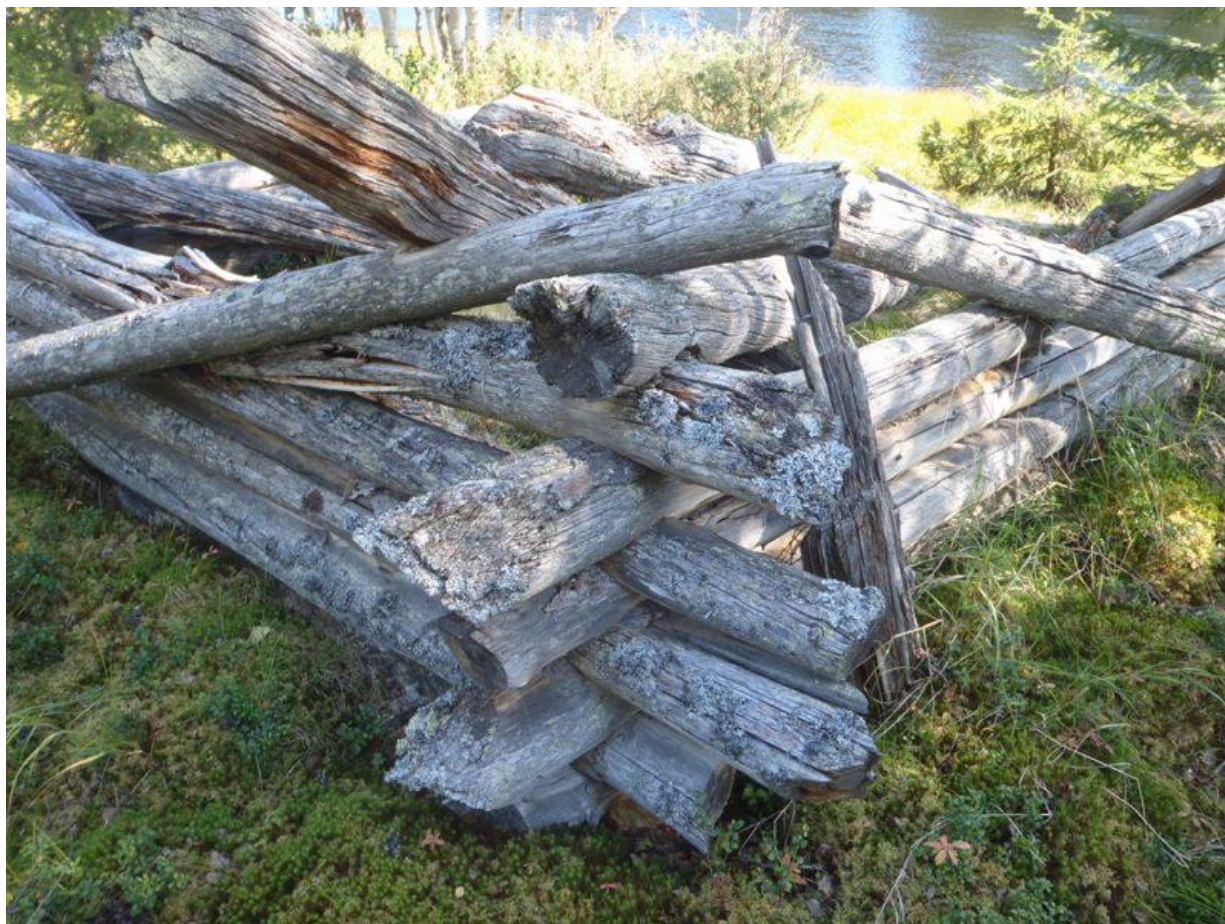
Rakennuksen lounaisnurkan salvoksia.
