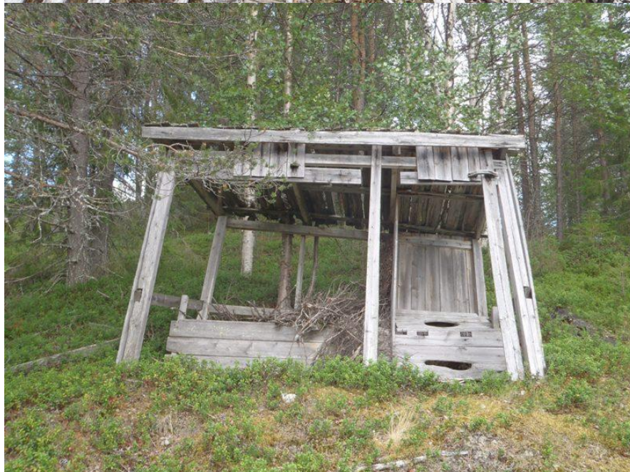
Yleiskuvia rakennelmien jäännöksistä.
