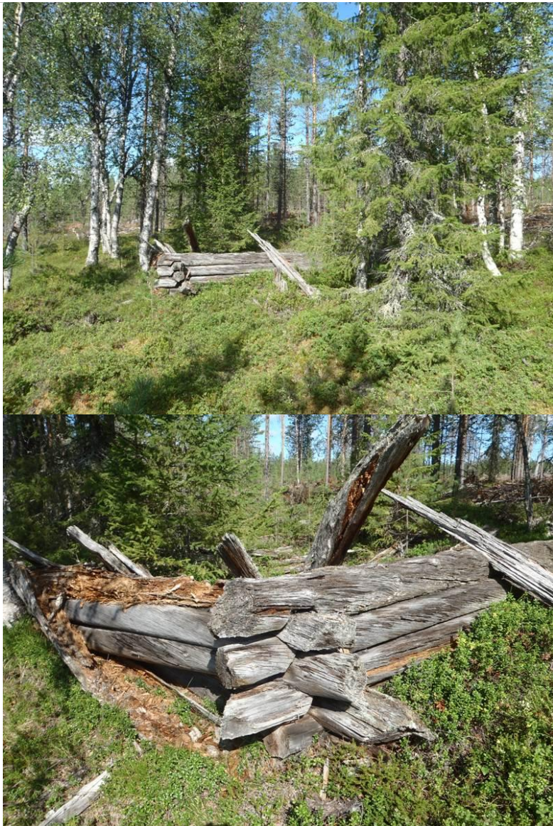
Yleiskuva rakennuksen jäännöksestä ja koillisnurkan salvoksia.
