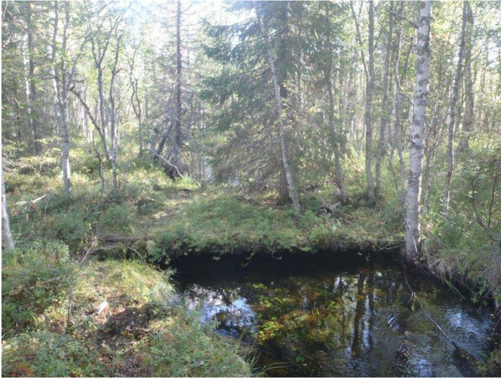
Yleiskuva sillasta kaakkoon.
