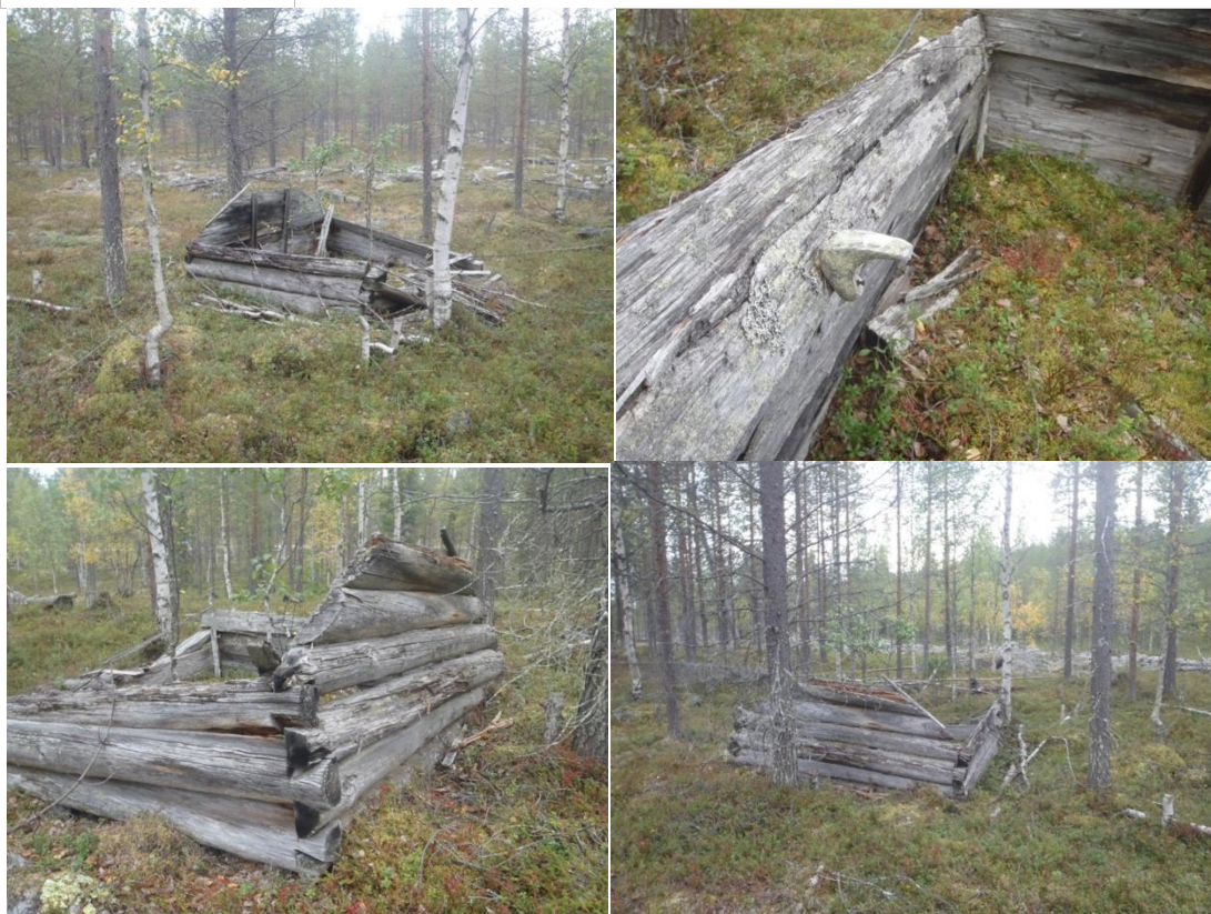
Kuvia vasotuskodasta ja sen rakenteista.
