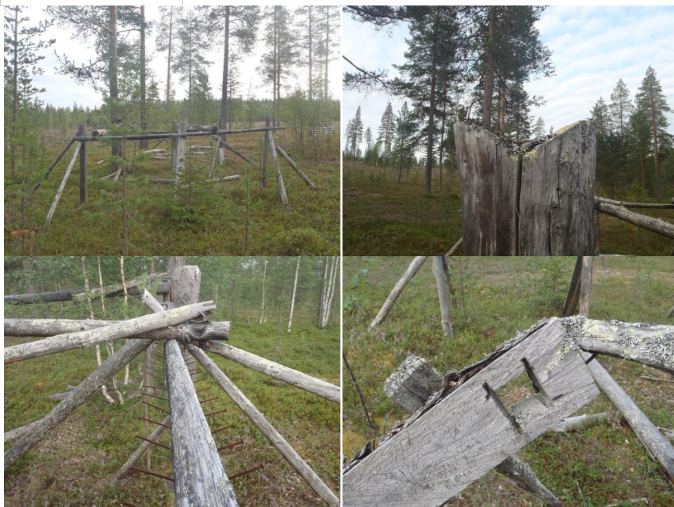
Yleiskuva ja yksityiskohtia ripustustelineestä.
