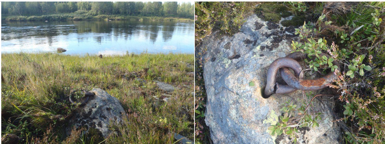
Uiton puomien kiinnitykseen käytettyjä rautarenkaita, jotka on pultattu kiviin.
