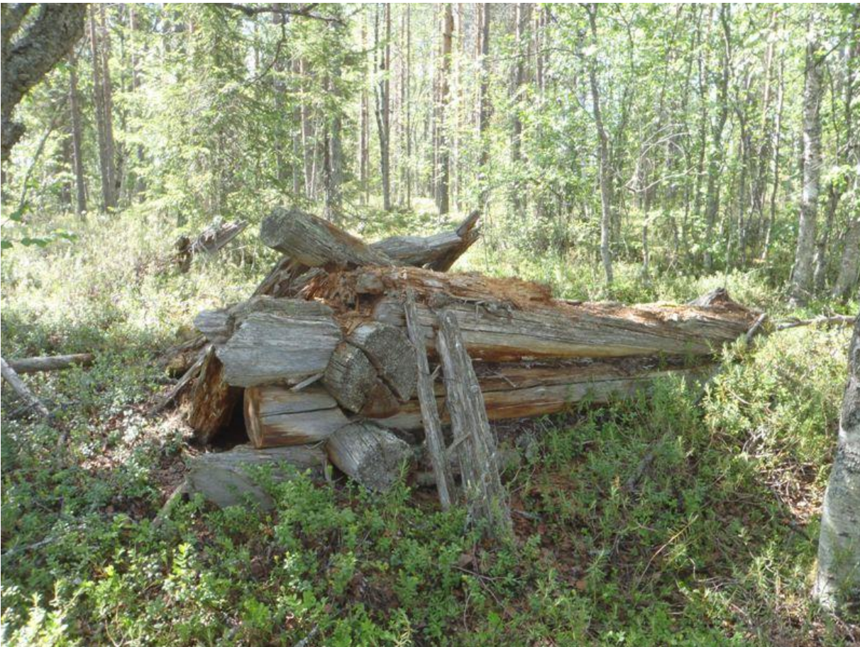
Rakennuksen kaakkoisnurkan salvoksia.
