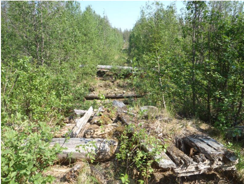
Tammen länsipuolisen vallin itäpääty.
