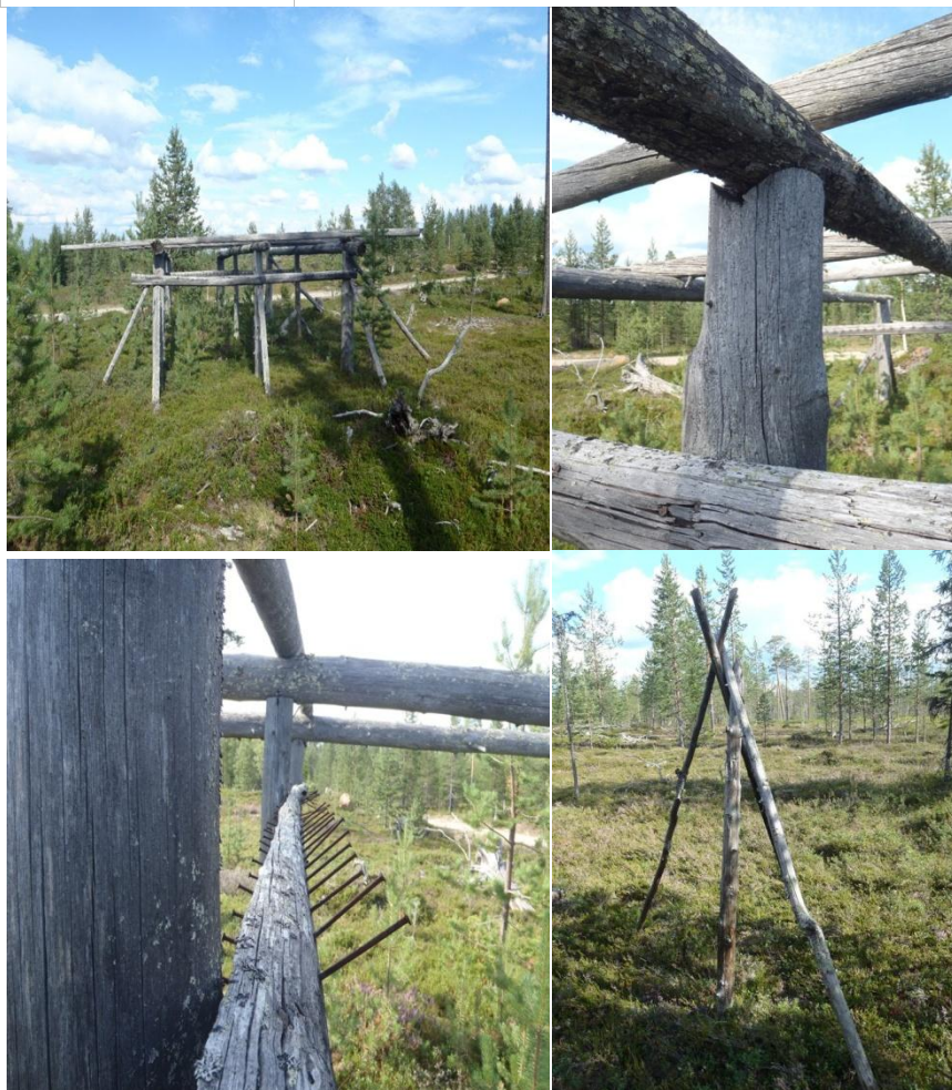
Yleiskuva ja yksityiskohtia ripustustelineestä.
