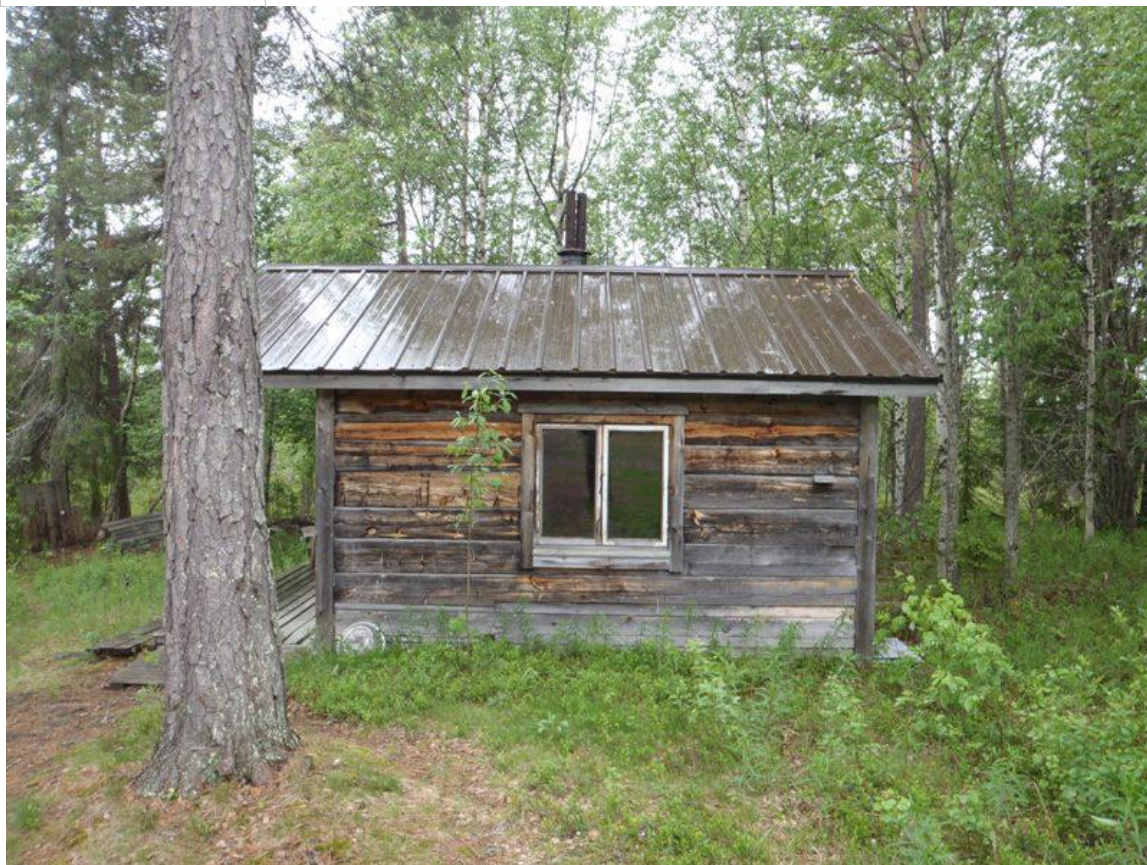
Tenniön pirtin sauna.
