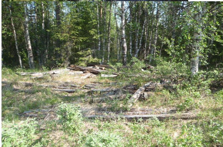
Yläkuvassa Iso Akanjoki tammen kohdalla ja alakuvassa tammen purettu puurakenne.
