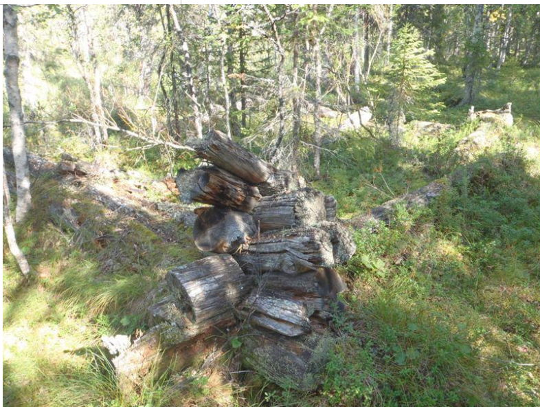
Rakennuksen kaakkoisnurkan salvoksia.
