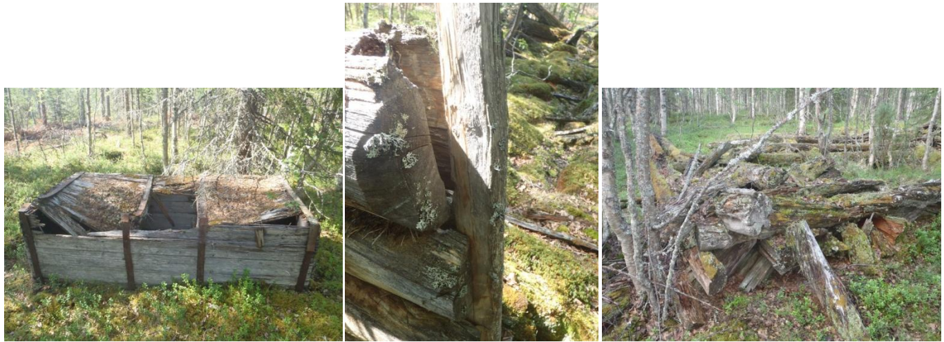
Rakennuksen vesipasa, ovenkarmi ja nurkkasalvos.
