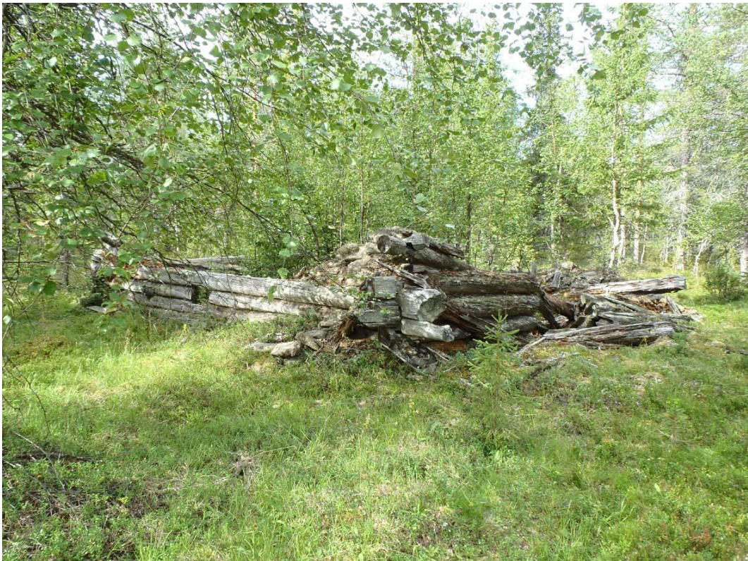
Siyliön Kaitavaara 3, sauna länsilounaaseen. Kuva: N. Latvakoski.
