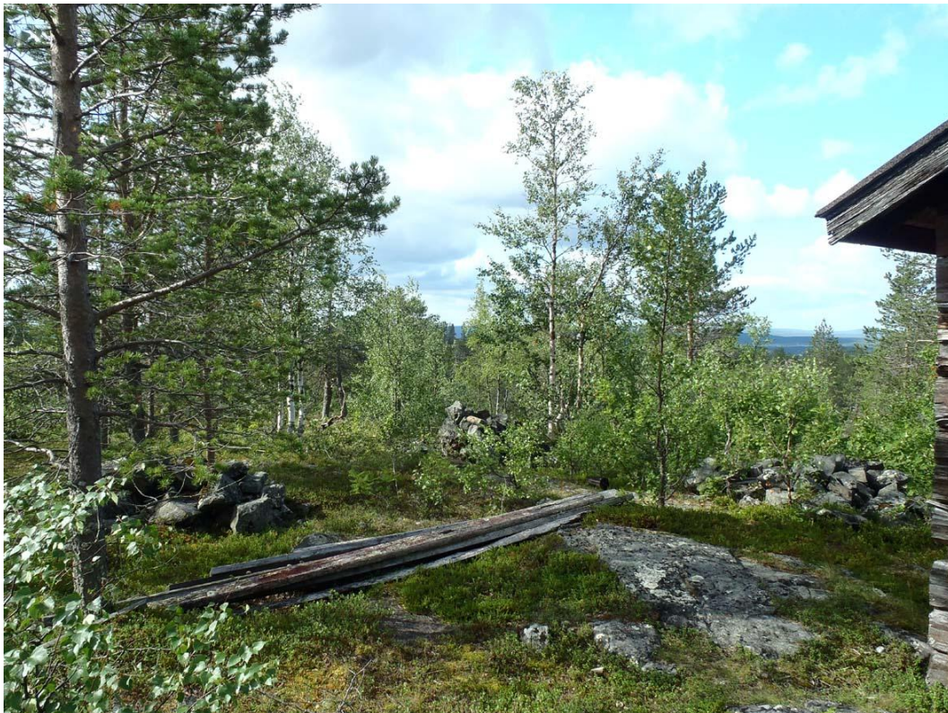
Alimmainen Angelvaara, kolmiomittaustornin tukiröykkiöt etelälounaaseen. Kuva N. Latvakoski.
