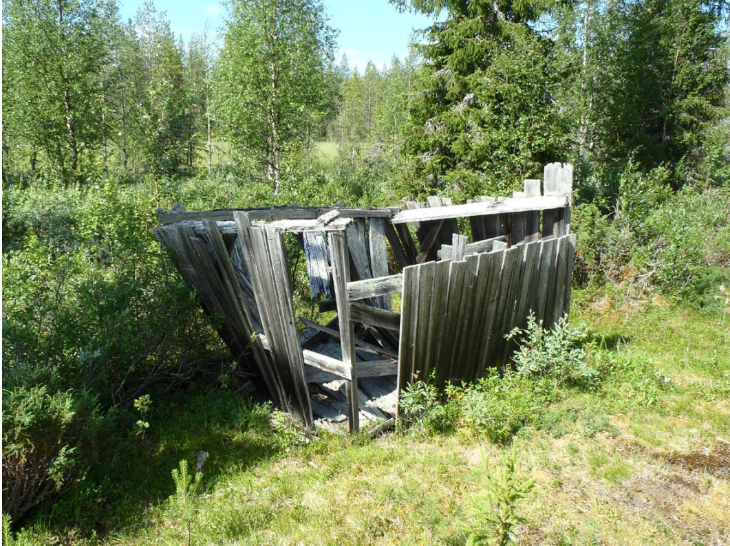
Kolmenkylänlehto1, kämpän varasto-käymälä länteen. Kuvattu N. Latvakoski.
