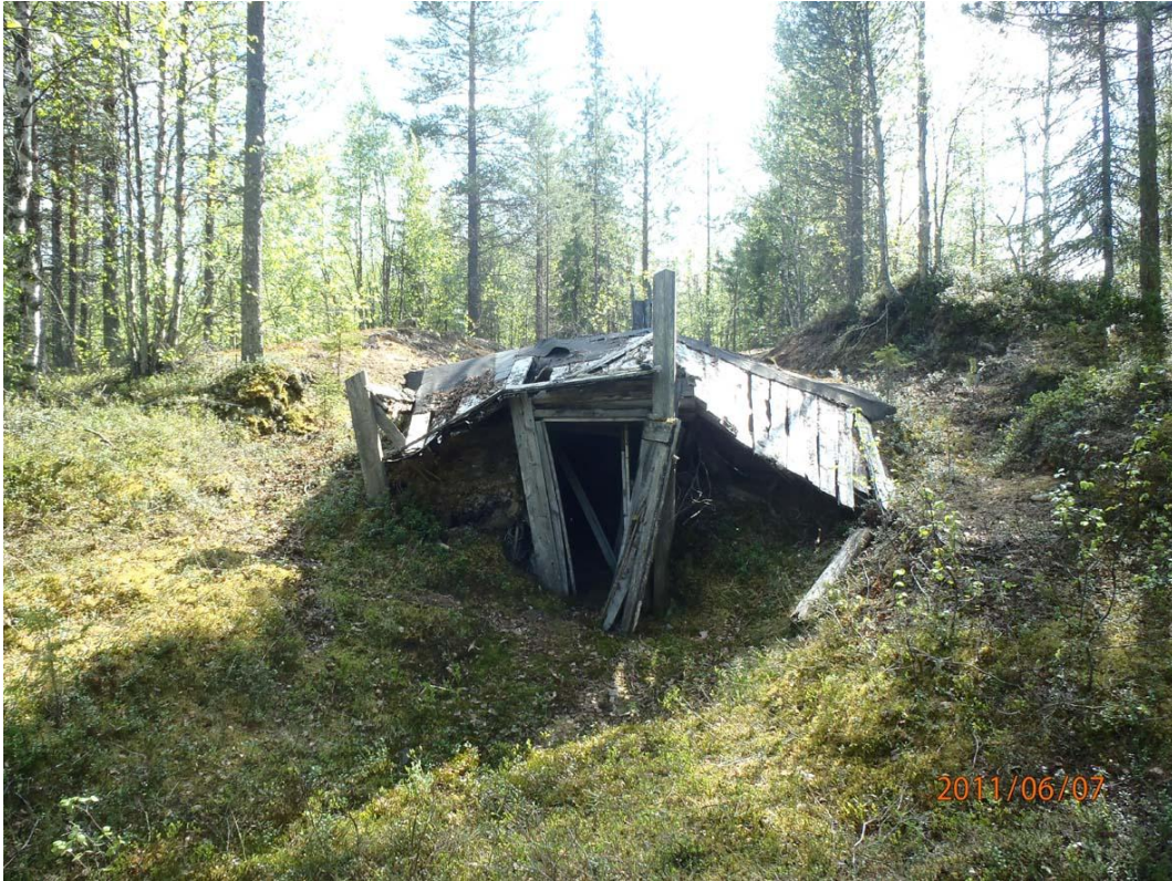
Kaitamaa 1, kellari etelälounaaseen. Kuva: S. Tolonen.
