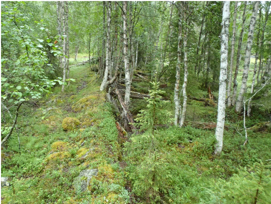
Kieroselkä 5, uittotammen valli ja tukirakenteita pohjoiskoilliseen. Kuva: N. Latvakoski.
