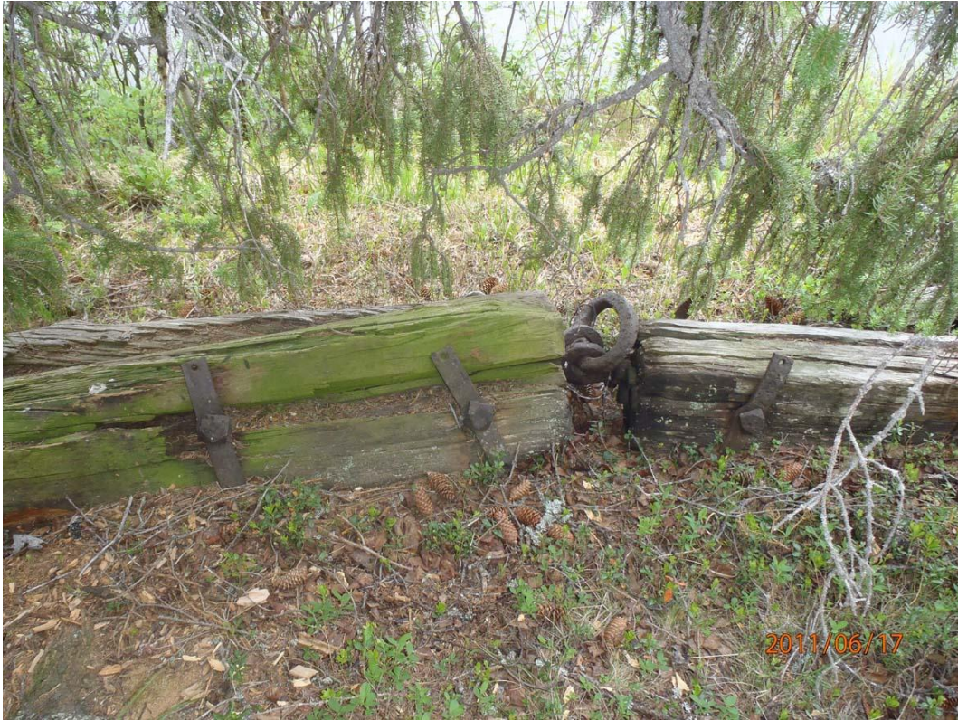
Kalliosaari 1; ohjepuomiketjun kiinnityskohdat. Kuva: N. Latvakoski.
