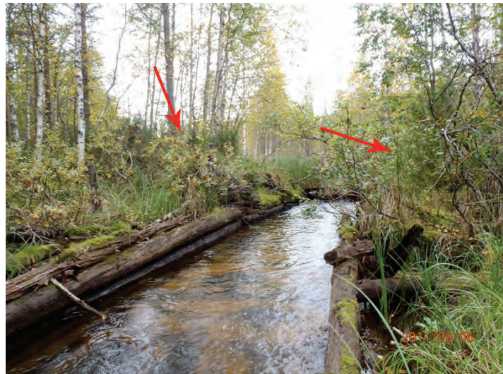
Väljjoen tammen molemmin puolin on kymmeniä metrejä pitkät penkat, joiden sisällä on puisia tukirakenteita. P9060021.
