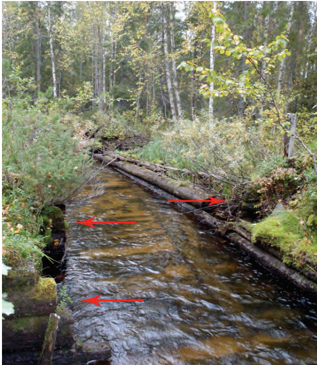
Väljjoen tammen alapuolinen uittoränni. Nuolet osoittavat sulkujen kohdalla olevia puisia rakenteita, jotka ovat edelleen hyväkuntoiset. P9060010.
