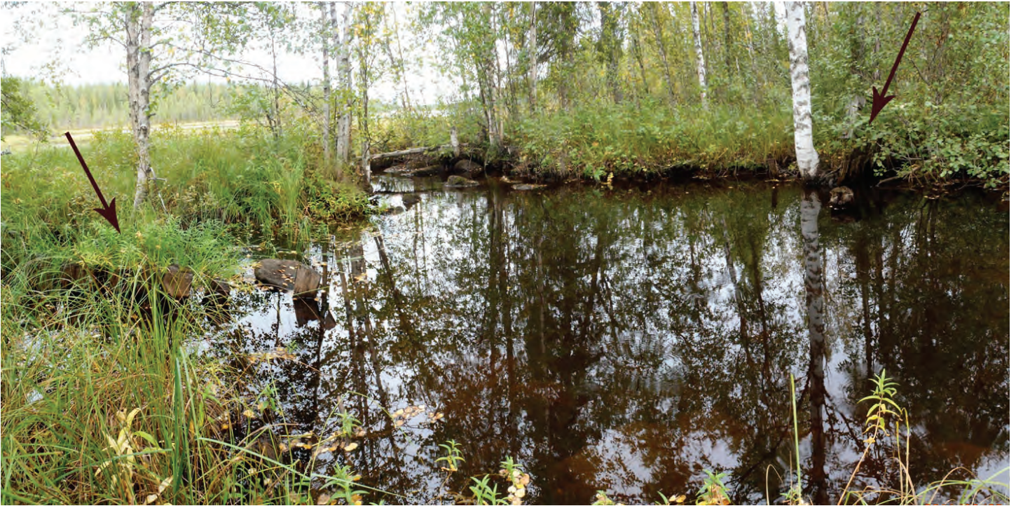
Yllä: Tammen jäänteet Vuoskujoen niskalla. Nuolet osoittavat puurakenteita molemmilla rannoilla. Rakenteet jatkuvat kymmenien metrien matkalla joen molemmilla rannoilla. Puurakenteiden lisäksi erottuvat selvät maavallit. P9020137, P9020138, P9020139.
