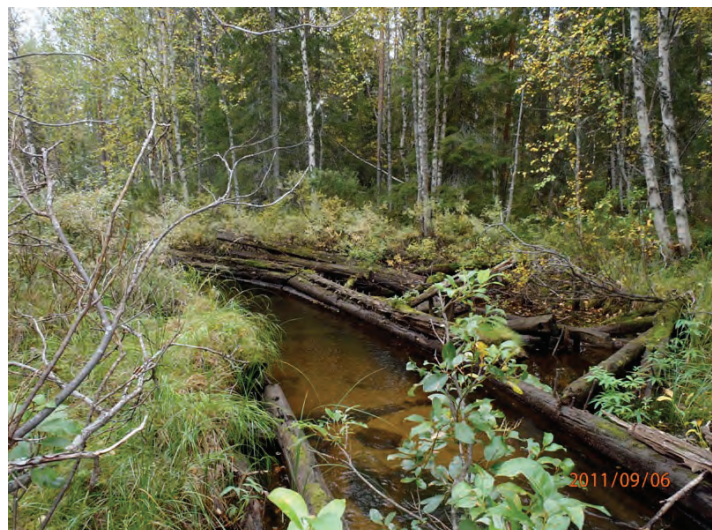
Uittorännin sivut on tuettu oikeaoppisilla kolmion muotoisilla tukirakenteilla. P9060014.
