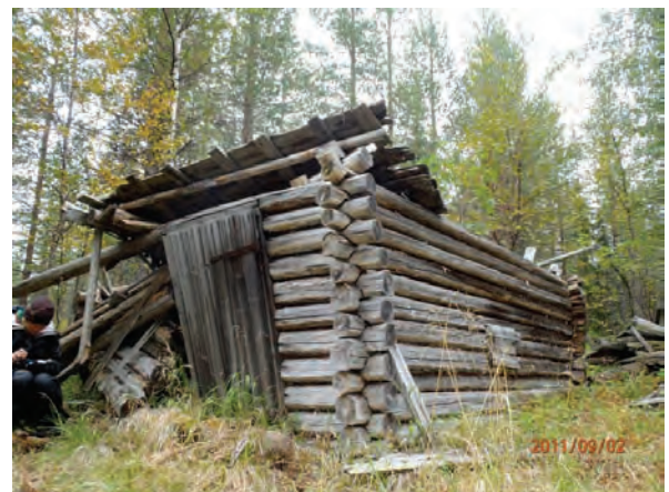
Oik. Saunarakennuksessa oli vielä rippeitä katosta. P9020168.
