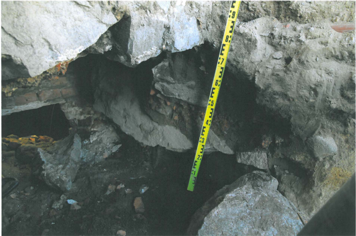
Kuva 185. Kiseleffin putkikaivanto. Aukon länsiprofili. Oikealla on puhdas hiekka, keskellä kiviperustus ja taaempana kellarin tiiliholvi. Kuvaussuunta SW. 7.9.2010.
