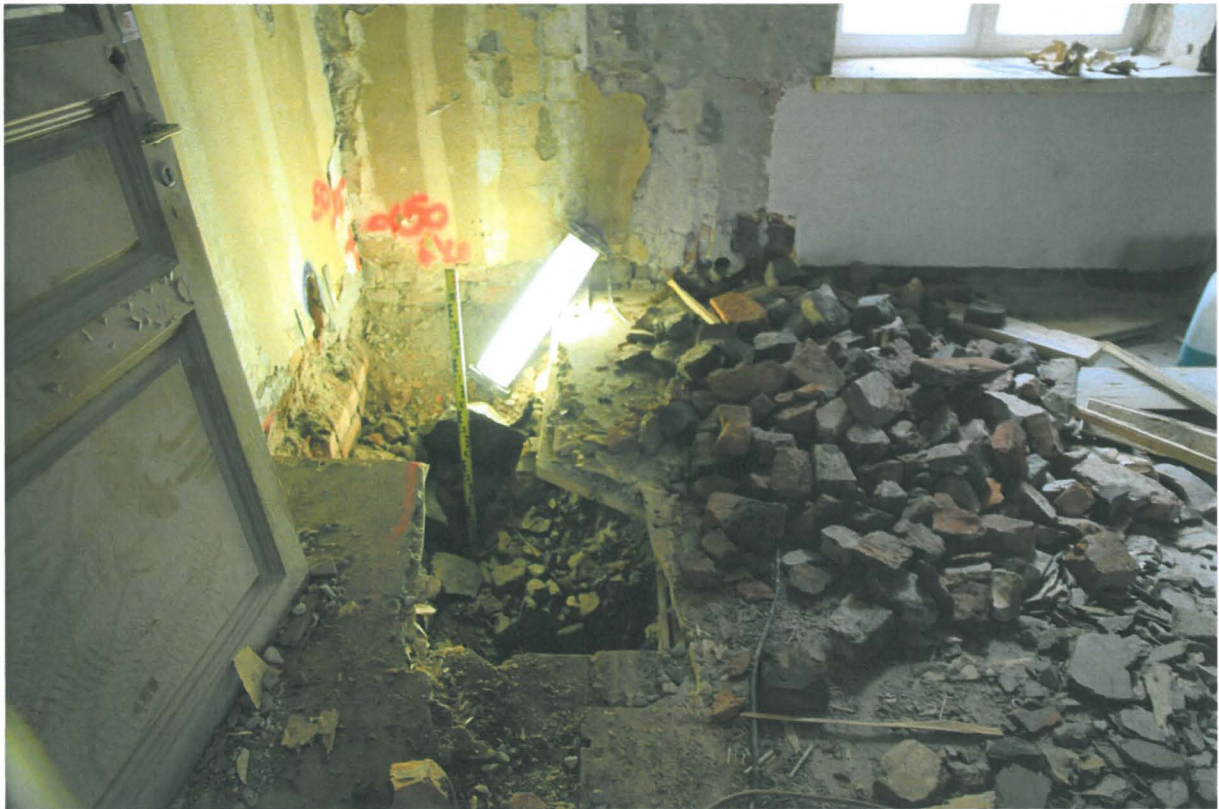
Kuva 148. Sunn S133. Koekuoppa 10 huoneen koillisnurkassa. Kuvaussuunta S. 15.9.2010.
