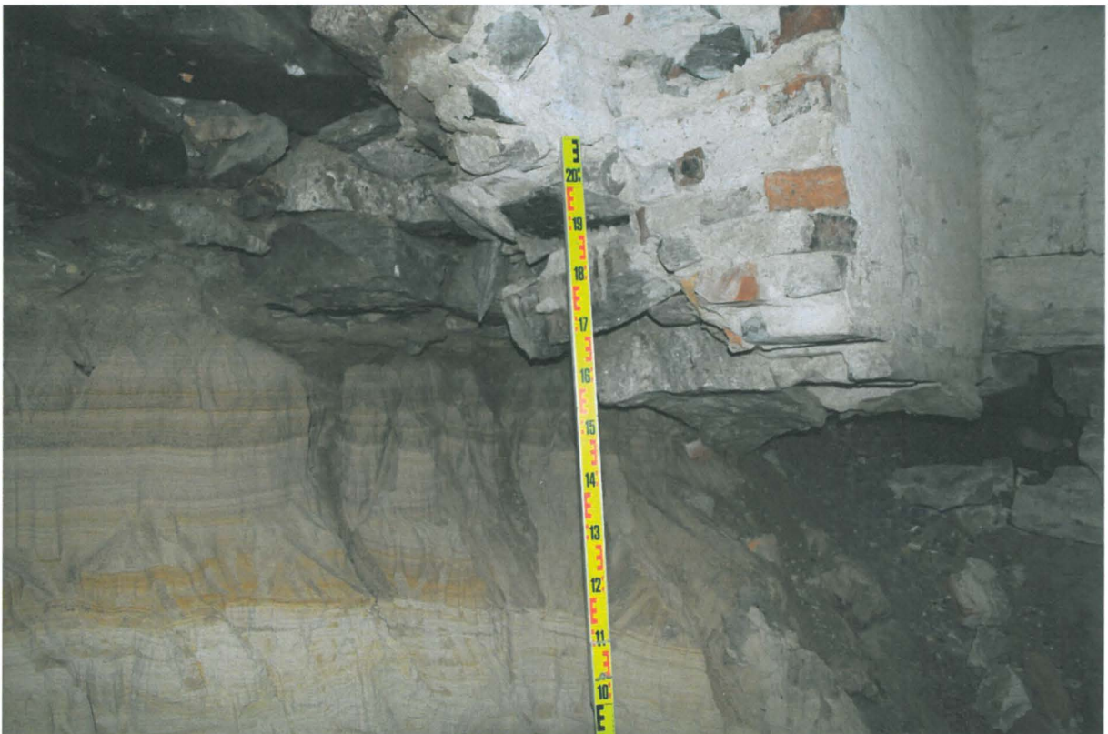
Kuva 109. Kiseleff K057. Hissikuilun koilliskulman alaosa. Kuvaussuunta NE. 25.5.2010.
