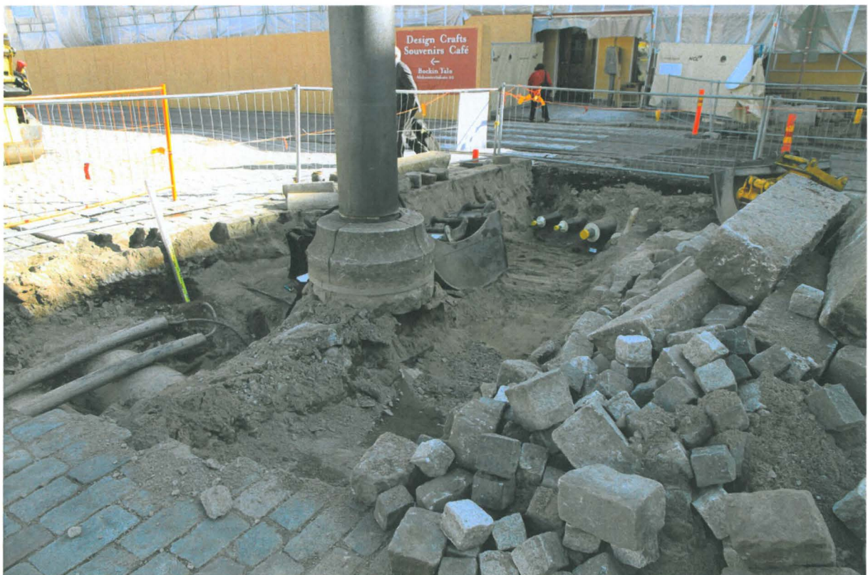
Kuva 170. Kiseleffin putkikaivanto. Kaivannon pohjoisosa. Kuvaussuunta SE. 31.8.2010.
