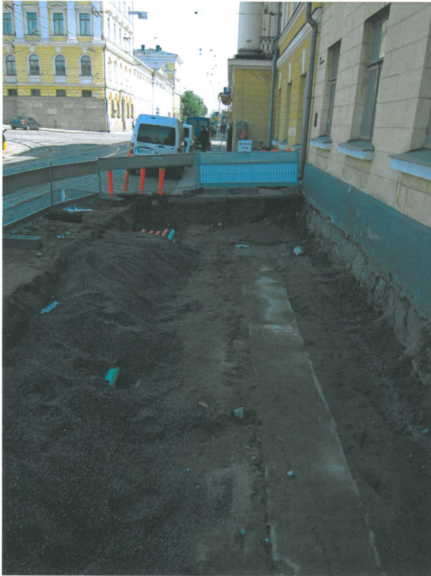
Kuva 232. Aleksanterinkadun jalkakäytävä. Burtzin talon itäosa. Seinän vieressä oli edelleen betoninen suojakansi. Kuvaussuunta E. 20.6.2011.
