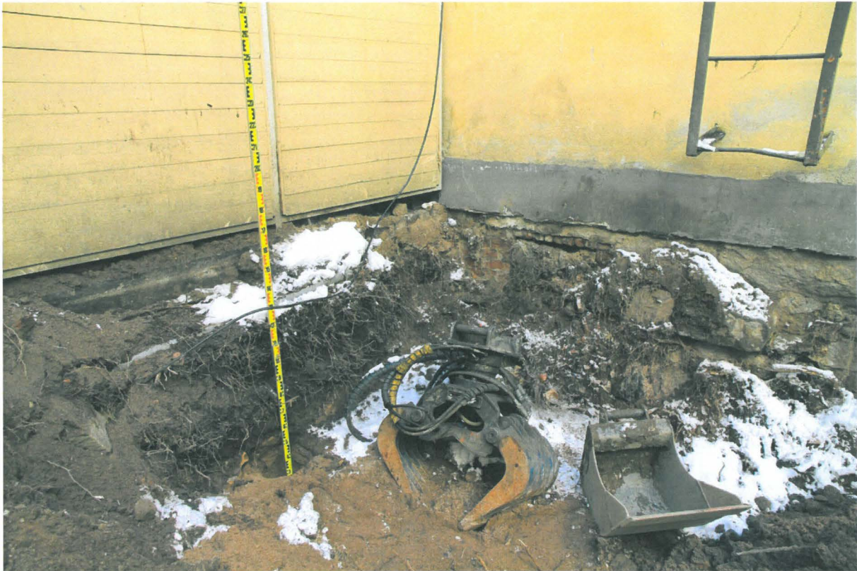
Kuva 160. Sunnin piha. Pihan lounaisnurkka huoltotasanteen edessä. Profilissa näkyy paikalla olleen puun juuria. Latan kohdalla puhdas pohjahiekka on jo esillä. Kuvaussuunta SW. 22.3.2010.
