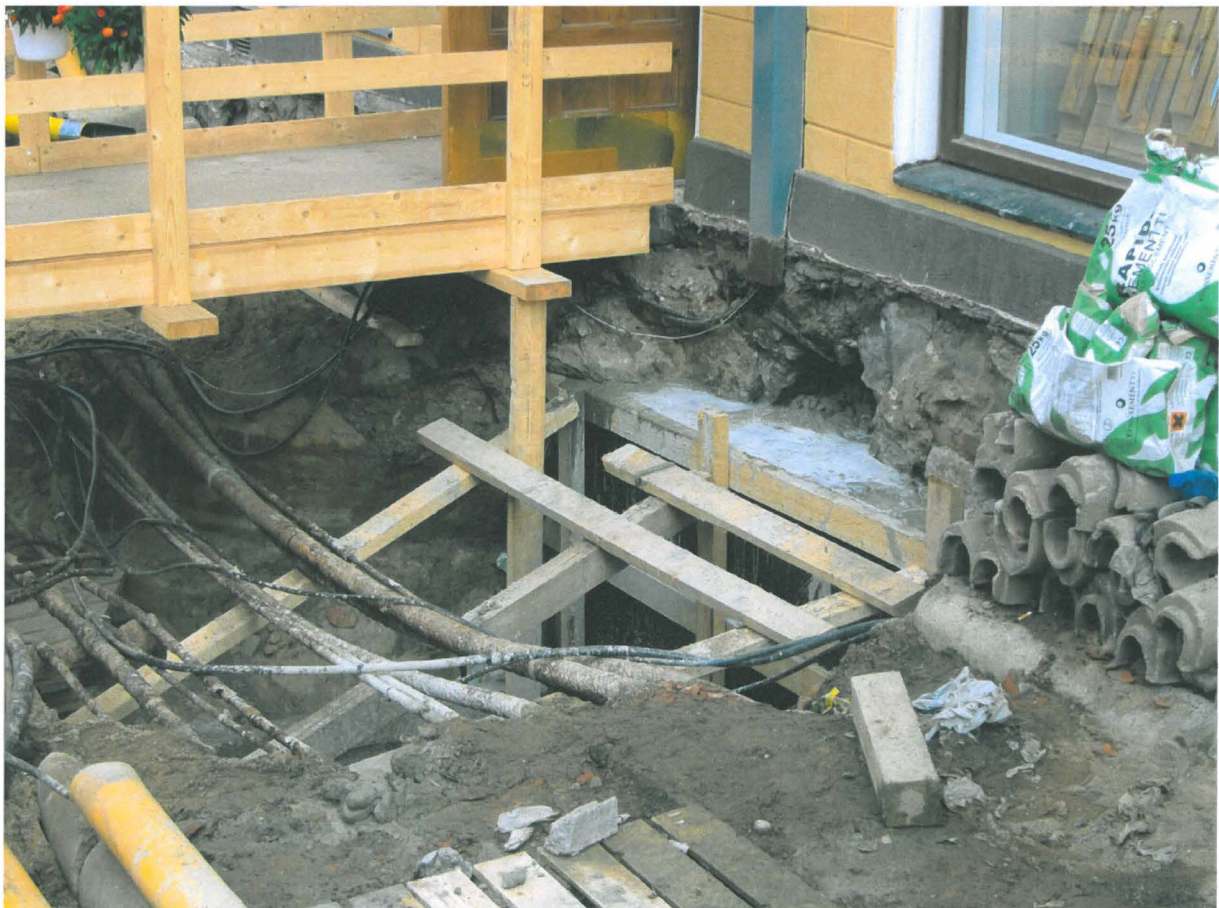
Kuva 188. Kiseleffin kaivanto. Putkia varten tehty aukko on betonoitu. Kuvaussuunta SE. 31.5.2010.
