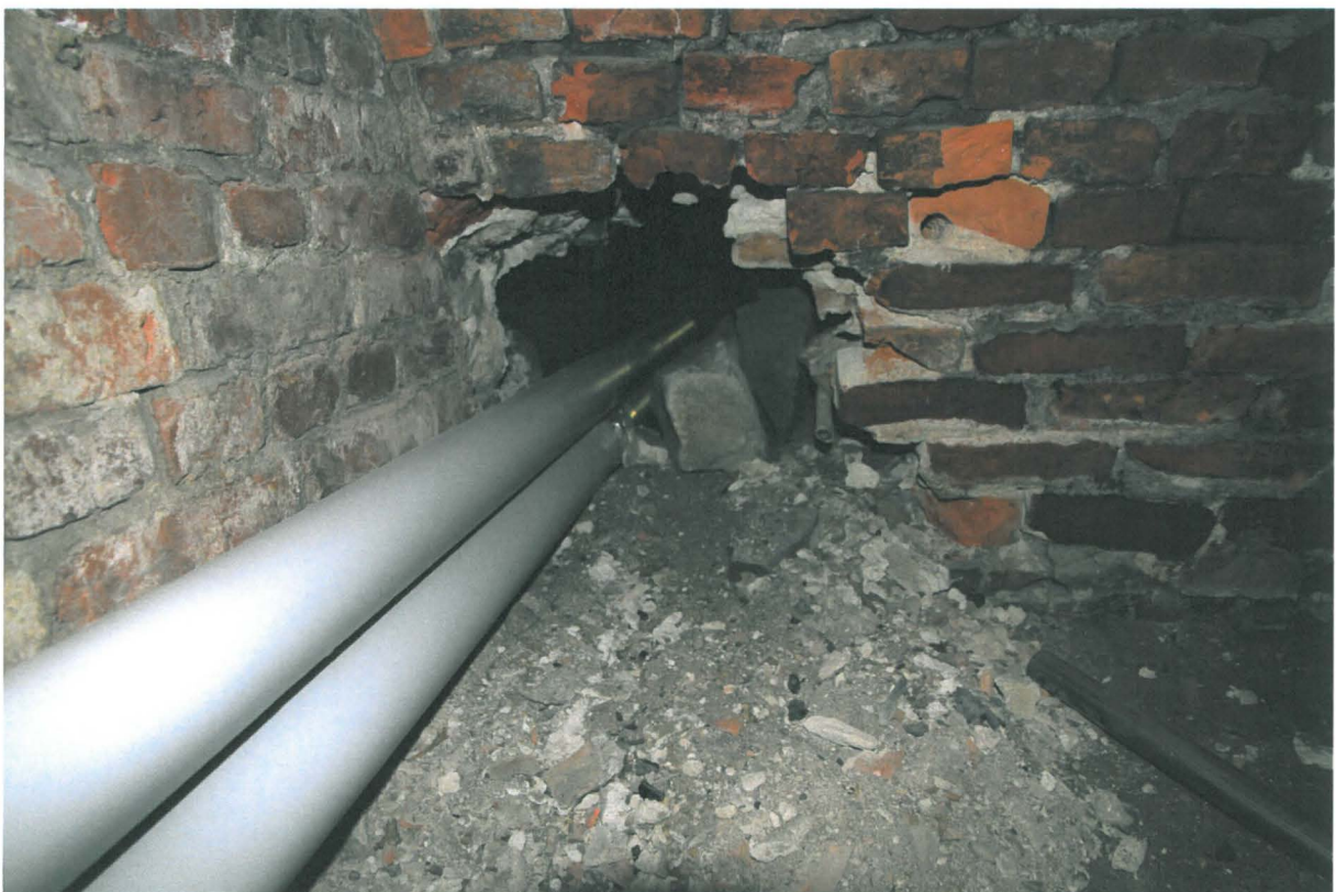
Kuva 56. Sunn 013-014. Lähikuva seinän läpi tehdystä aukosta. Kuvaussuunta S. 8.11.2010.
