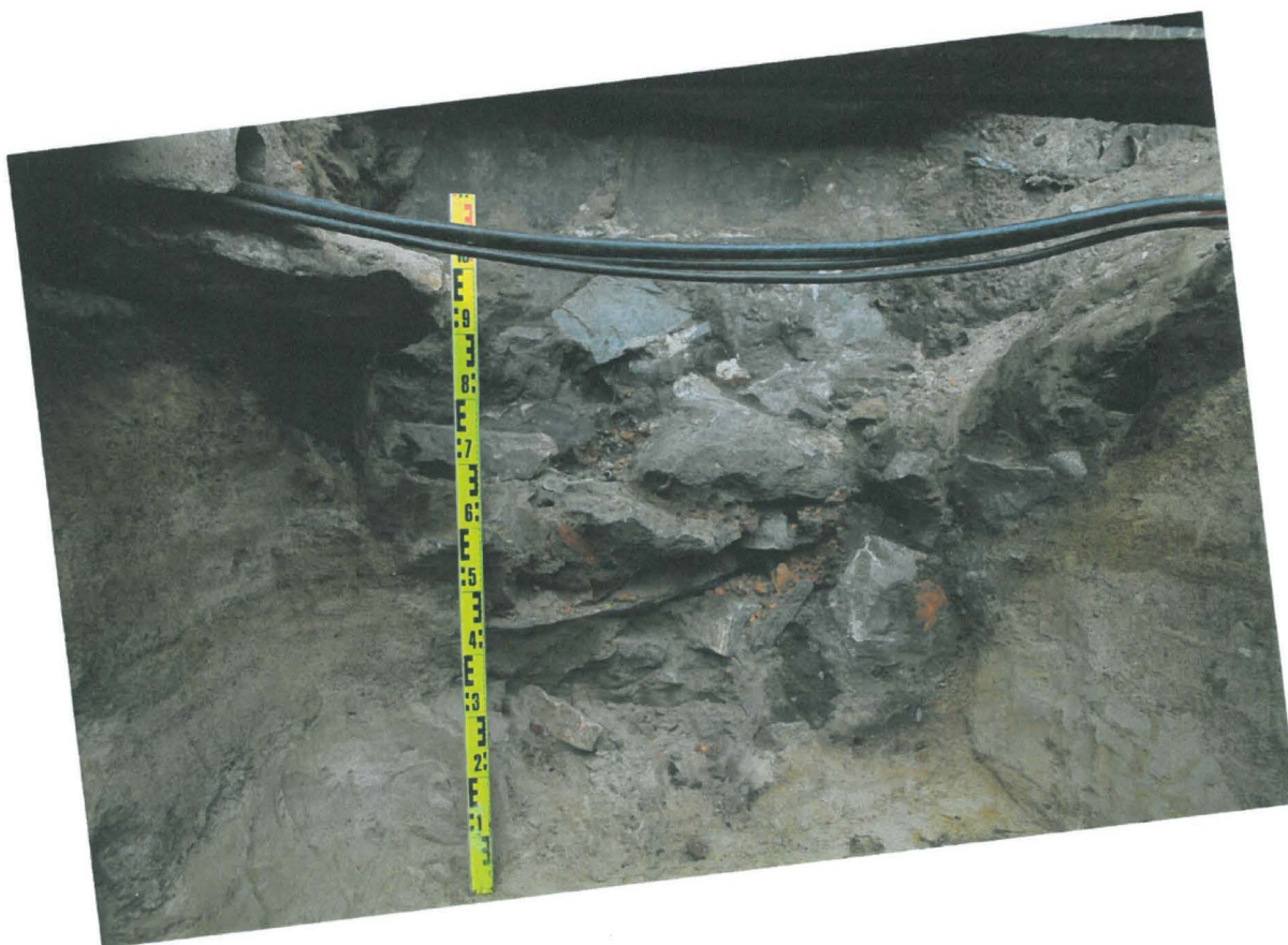
Kuva 178. Kiseleffin putkikaivanto. Kiseleffin pohjoisseinän perustus kuvattuna alhaalta kaivannosta. Kuvaussuunta S. 3.9.2010.
