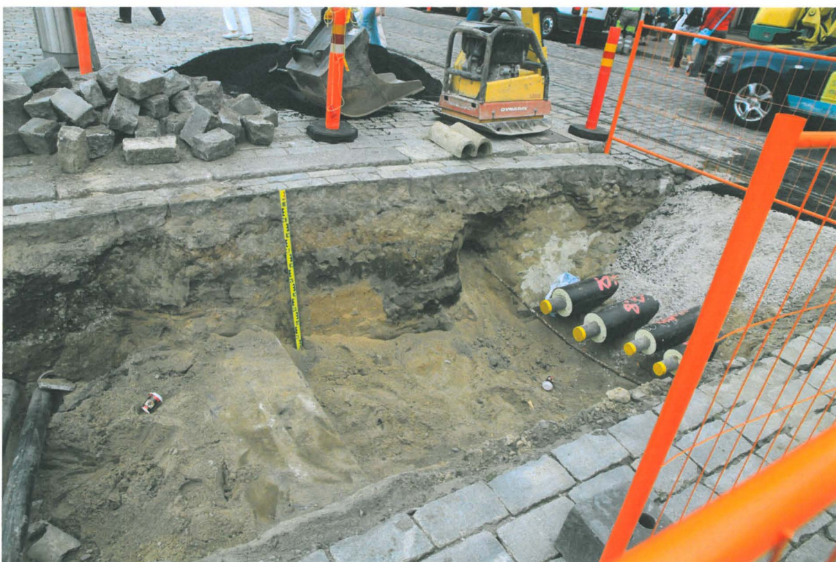
Kuva 192. Sunnin putkikaivanto. Lähikuva edellisestä. Vanhempi tumma maannos latan oikealla puolella. Kuvaussuunta SE. 17.8.2010.
