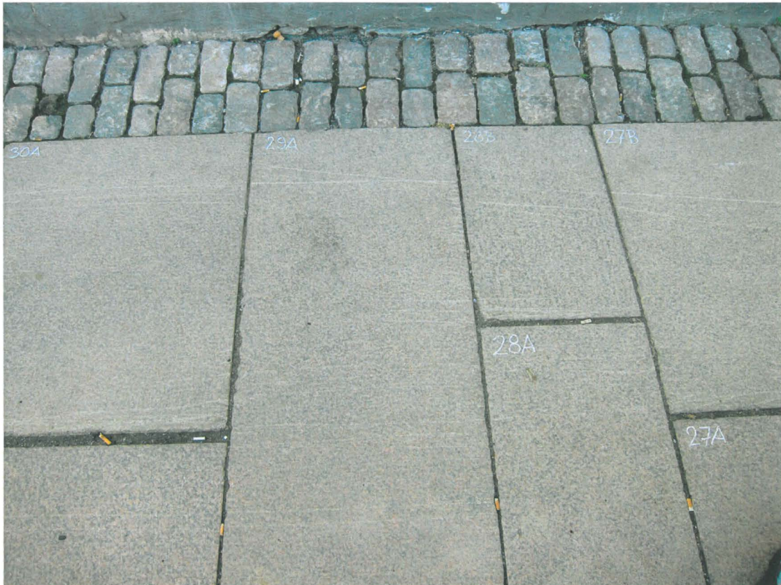
Kuva 209. Aleksanterinkadun jalkakäytävä. Jalkakäytävän kivet on numeroitu poissiirtämistä varten Leijona korttelin alueella. Kuvaussuunta S. 20.5.2011.
