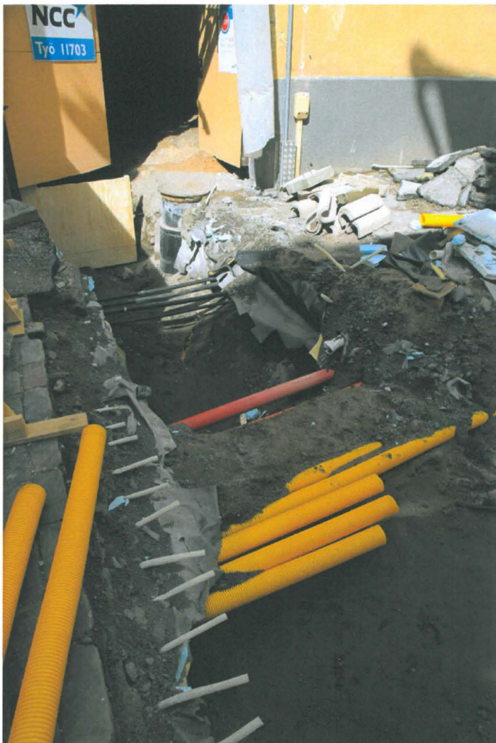
Kuva 206. Sunnin putkikaivanto. Pääkaivannosta erkaneva poikittainen kaivanto Sunnin porttikäytävään. Kuvaussuunta W. 9.7.2010.
