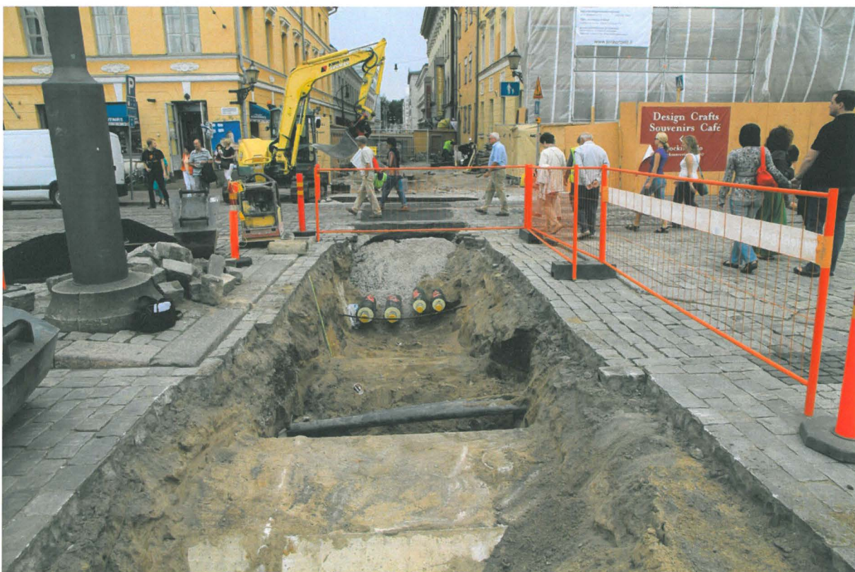
Kuva 190. Sunnin putkikaivanto. Lähikuva edellisestä. Etualalla näkyy vanhan itä-länsi-suuntaisen kaukolämpöputkikanavan betonisuojat. Kuvaussuunta S. 17.8.2010.
