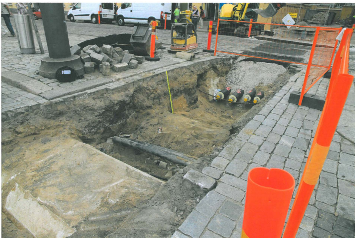
Kuva 191. Sunnin putkikaivanto. Kaivannon pohjoispään itäprofiilia. Kuvaussuunta SE. 17.8.2010.
