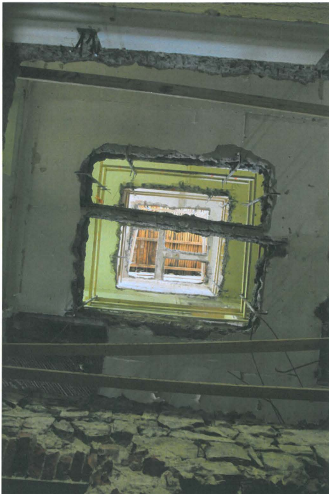
Kuva 115. Kiseleff K057. Hissikuilun tieltä purettiin kaikki lattiat kattoon saakka. Kuvaussuunta N. 25.5.2010.
