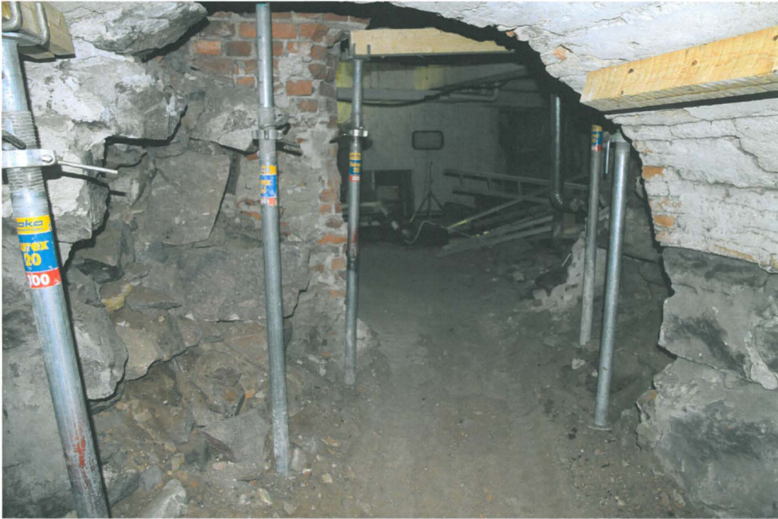
Kuva 98. Sunn S020. Kellaritilan länsipää. Sunnin ja Kiseleffin väliseen seinään on tehty iso aukko. Kuvaussuunta W. 31.3.2010.
