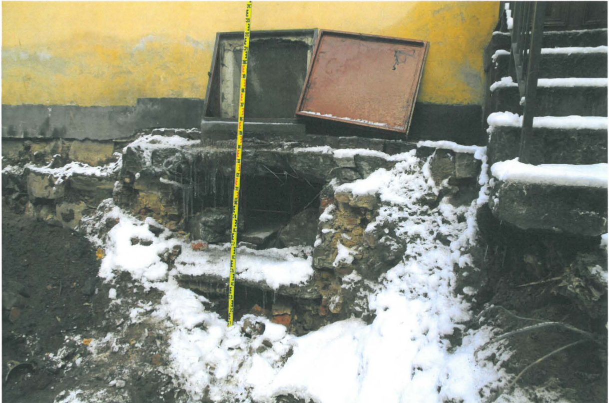
Kuva 94. Sunn S020. Kannella suljettu aukko seinän läpi kellaritilaan, joka oli muista erillinen tila (uusi numero S020). Kuvaussuunta W. 22.3.2010.
