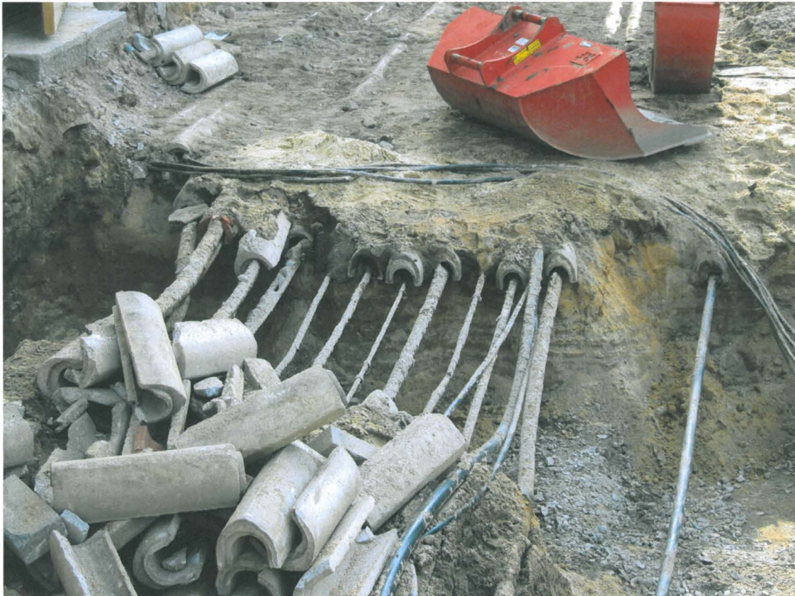
Kuva 221. Aleksanterinkadun jalkakäytävä. Edellinen kohta. Kaapeleiden alla on koko jalkakäytävän leveydellä puhdas pohjahiekka. Kuvaussuunta W. 24.5.2011.
