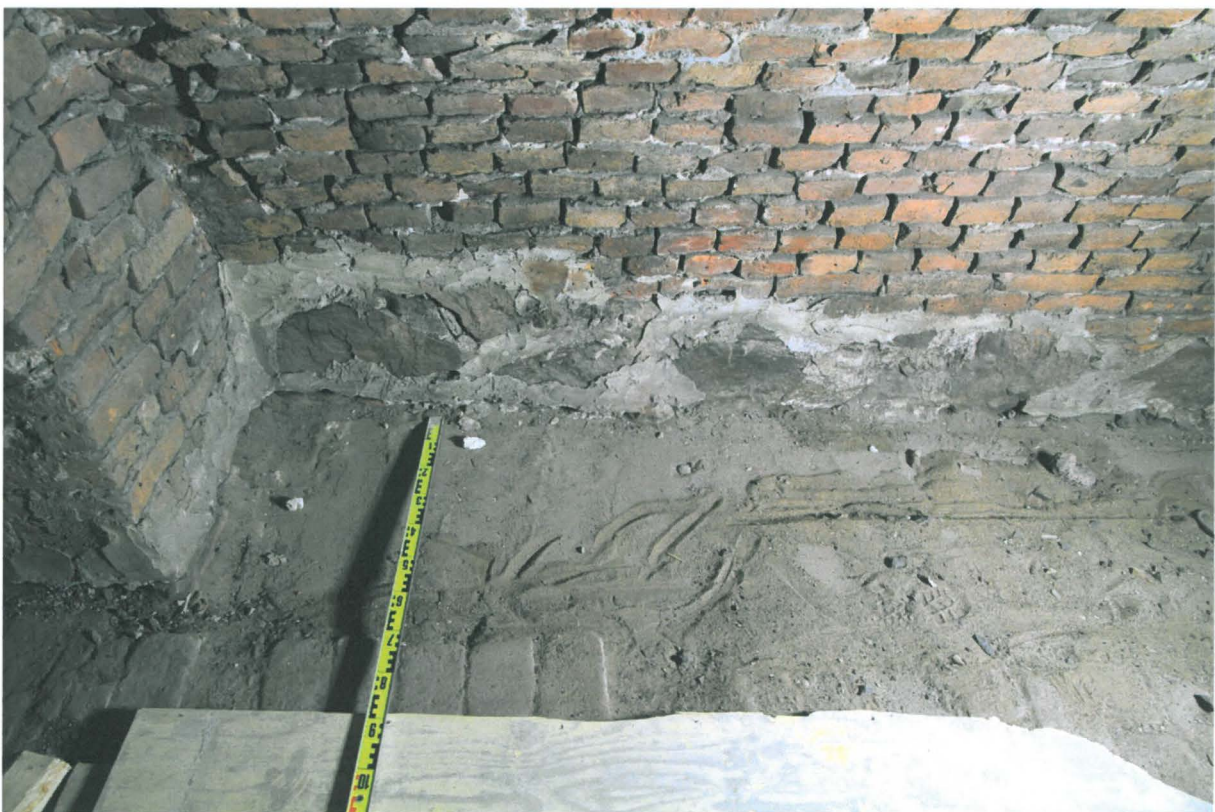
Kuva 46. Sunn S013-014. Koekuoppa 4:n sijaintikohta S013:n eteläseinän juurella. Kuvaussuunta S. 8.11.2010.
