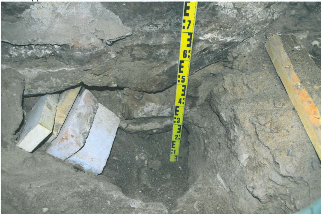
Kuva 50. Sunn S013-014. Koekuoppa 4. Lähikuva edellisestä tilanteesta. Tiilet ja laudat on laitettu kuoppaan estämään hiekan valumista kivien alta. Seinän alareuna on latan 45 cm:n kohdalla. Vaaleat läikät alaosassa ovat silttikerroksia. Kuvaussuunta S. 8.11.2010.
