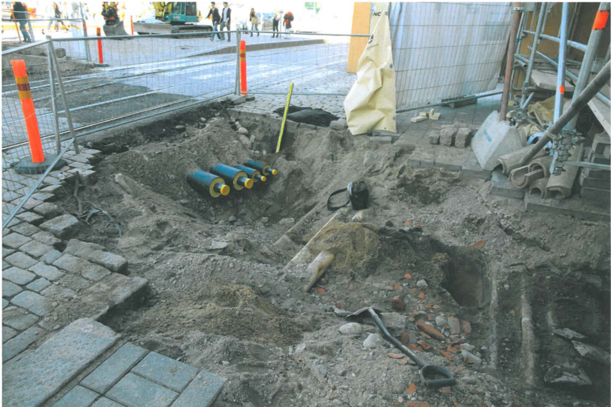
Kuva 175. Kiseleffin putkikaivanto. Kiseleffin jalkakäytävän pohjoisosan kohta. Kuvaussuunta NE. 31.8.2010.
