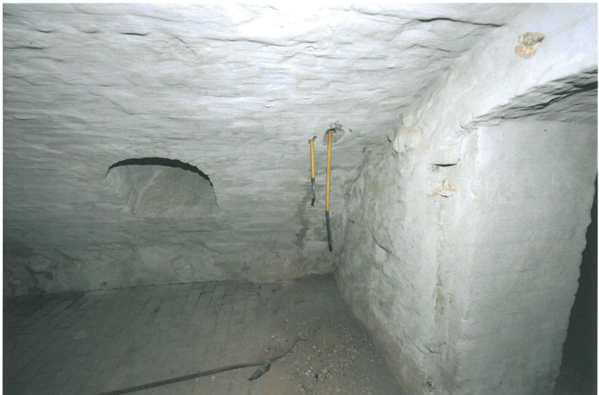
Kuva 16. Sunn S003. Kellaritilan koilliskulman katon läpi oli porattu putkia varten reiät. Yläpuolella 1. kerroksessa oli koekuoppa 7. Kuvaussuunta NNE. 22.9.2010.
