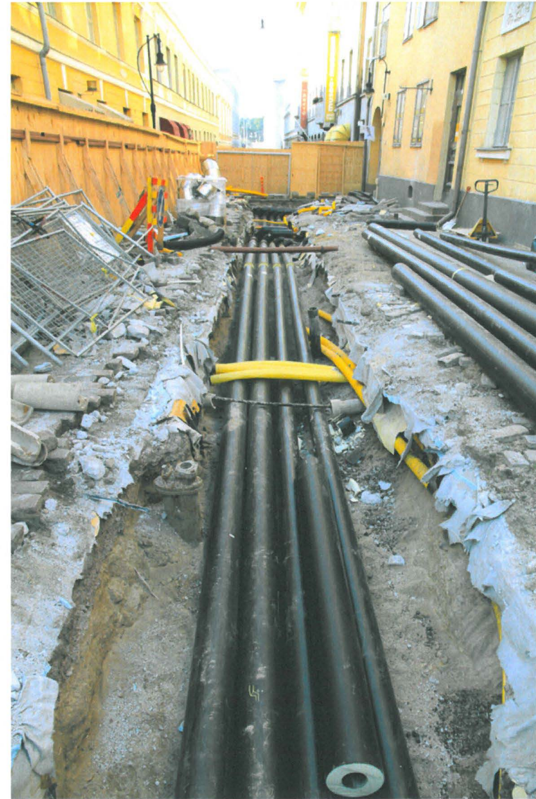
Kuva 208. Sunnin putkikaivanto. Sofiankadun osuudelle on laitettu putket. Kuvaussuunta S. 28.7.2010.
