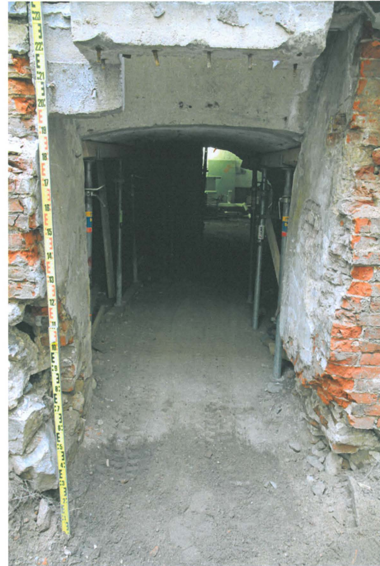
Kuva 97. Sunn S020. Käytävä kellaritilaan. Kuvaussuunta W. 31.3.2010.
