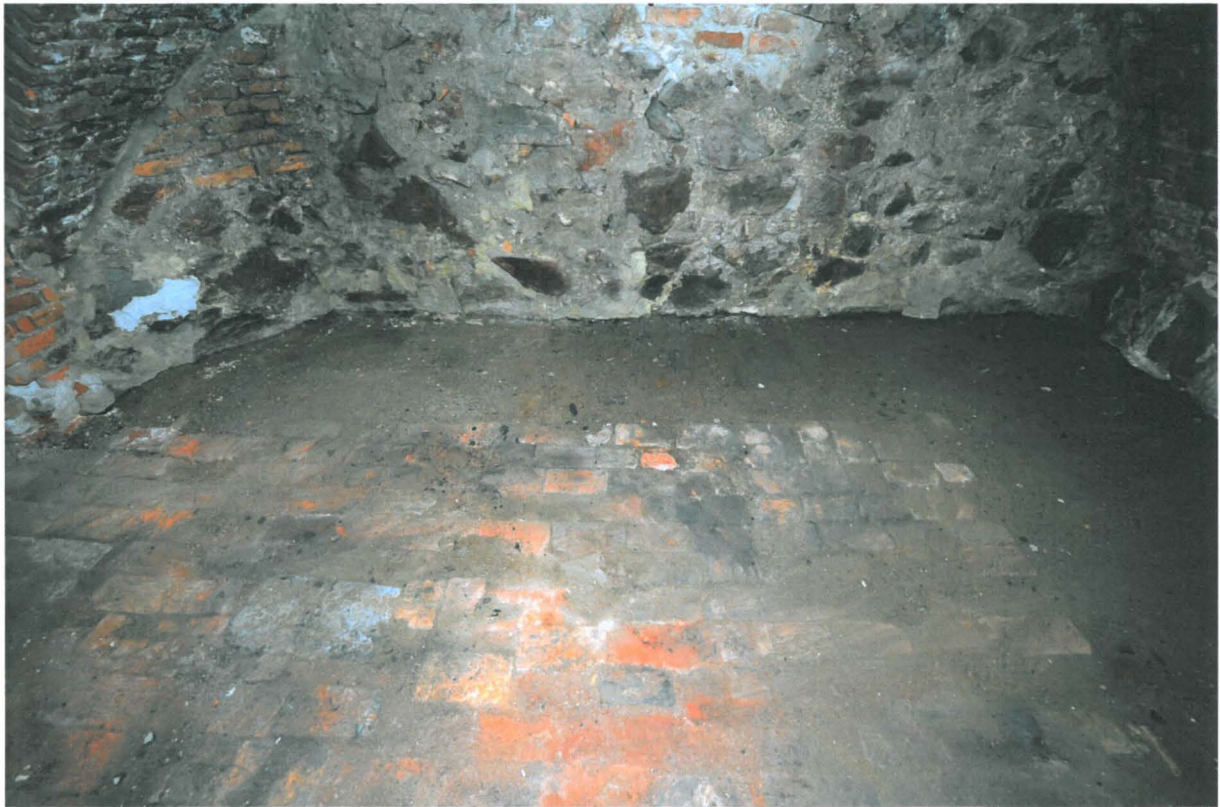
Kuva 31. Sunn S013-014. S013:n länsiseinän ja pohjoisseinän vierestä puuttui tiililattia. Kuvaussuunta W. 22.9.2010.
