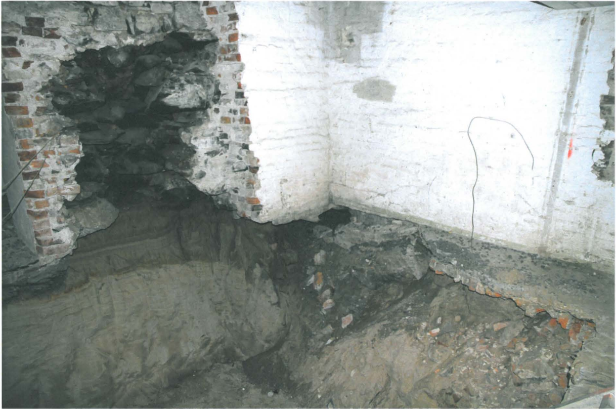
Kuva 108. Kiseleff K057. Hissikuilun koilliskulma. Kuvaussuunta NE. 25.5.2010.
