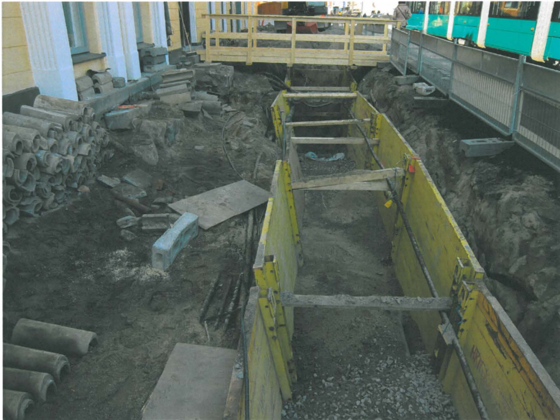
Kuva 217. Aleksanterinkadun jalkakäytävä. Viemäriputkia varten tehty kaivanto tukiseinineen Sunnin länsiosassa. Putket ovat vielä asentamatta. Kuvasuusuunta W. 20.5.2011.
