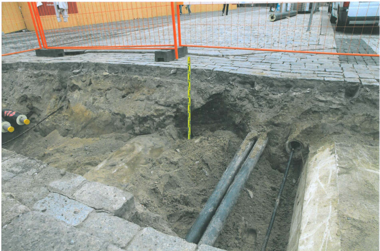
Kuva 196. Sunnin putkikaivanto. Kaivannon pohjoispään länsiprofilia. Kuvaussuunta SW. 17.8.2010.
