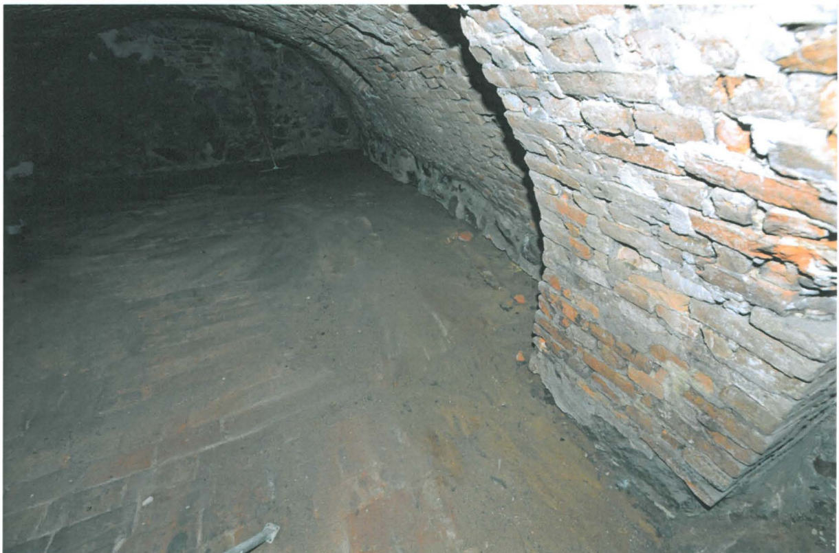
Kuva 32. Sunn S013-014. S013:n pohjoisseinän vierestä puuttui tiililattia. Kuvaussuunta NWW. 22.9.2010.
