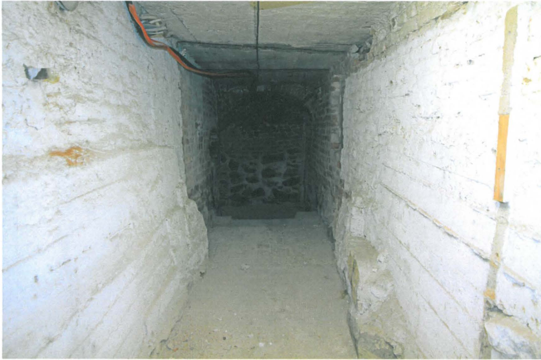
Kuva 62. Sunn S011. Edellinen käytävä kuvattuna aikaisemmin vastakkaisesta suunnasta. Tiiliholvi on vielä ehjä käytävän päässä. Kuvaussuunta N. 25.5.2010.
