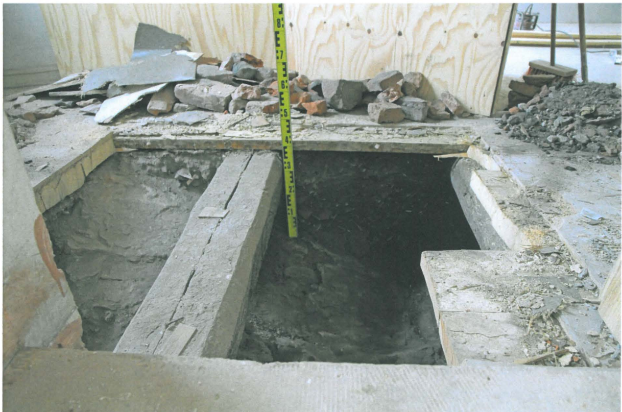
Kuva 139. Sunn S109. Koekuoppa 9:n itäprofiili. Lattian alla näkyy täytehiekkä, jonka paksuus kasvaa oikealle kellariaukon holvin painuessa syvemmälle. Kuvaussuunta E. 15.9.2010.
