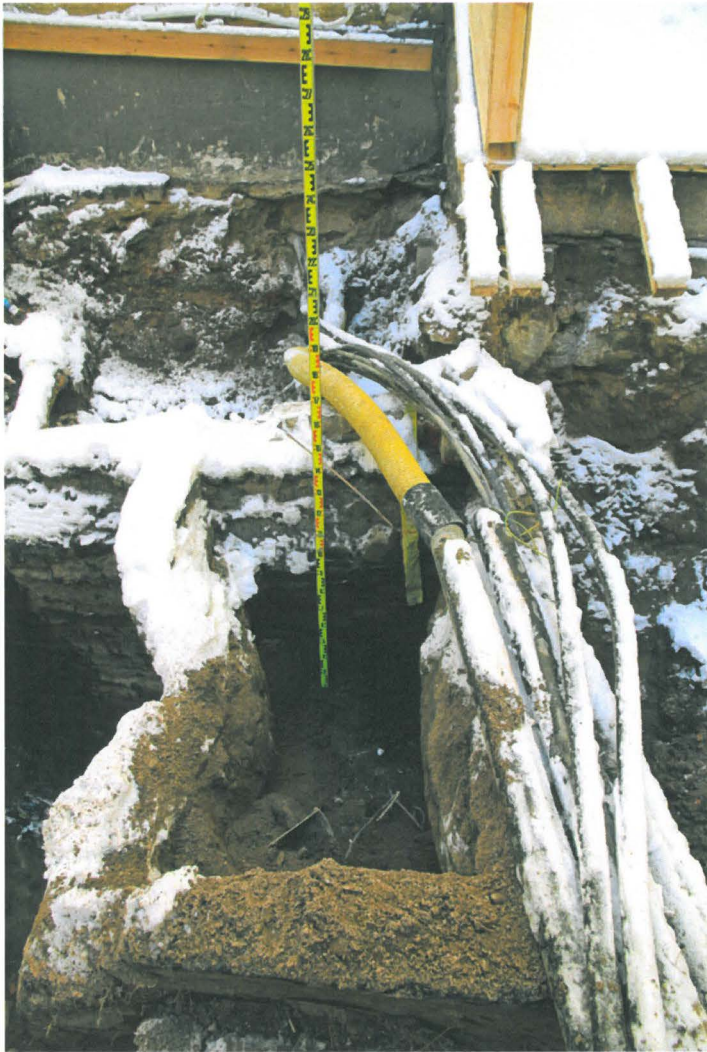
Kuva 156. Sunnin piha. Lähikuva itäisestä tiili-betonirakenteesta, jonka seinät ovat sisäänpäin pullistuneita. Kuvaussuunta N. 22.3.2010.
