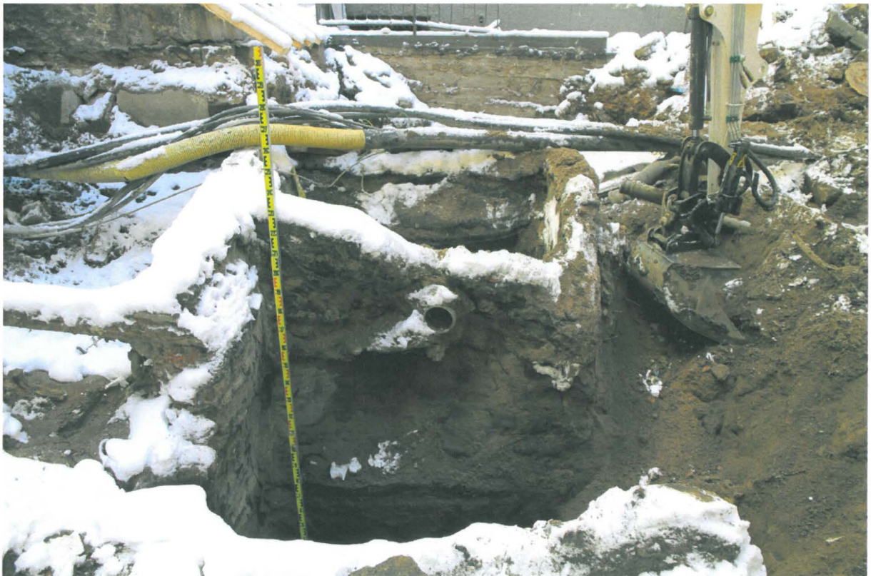
Kuva 155. Sunnin piha. Lähikuva edellisistä rakenteista. Kuvaussuunta E. 22.3.2010.
