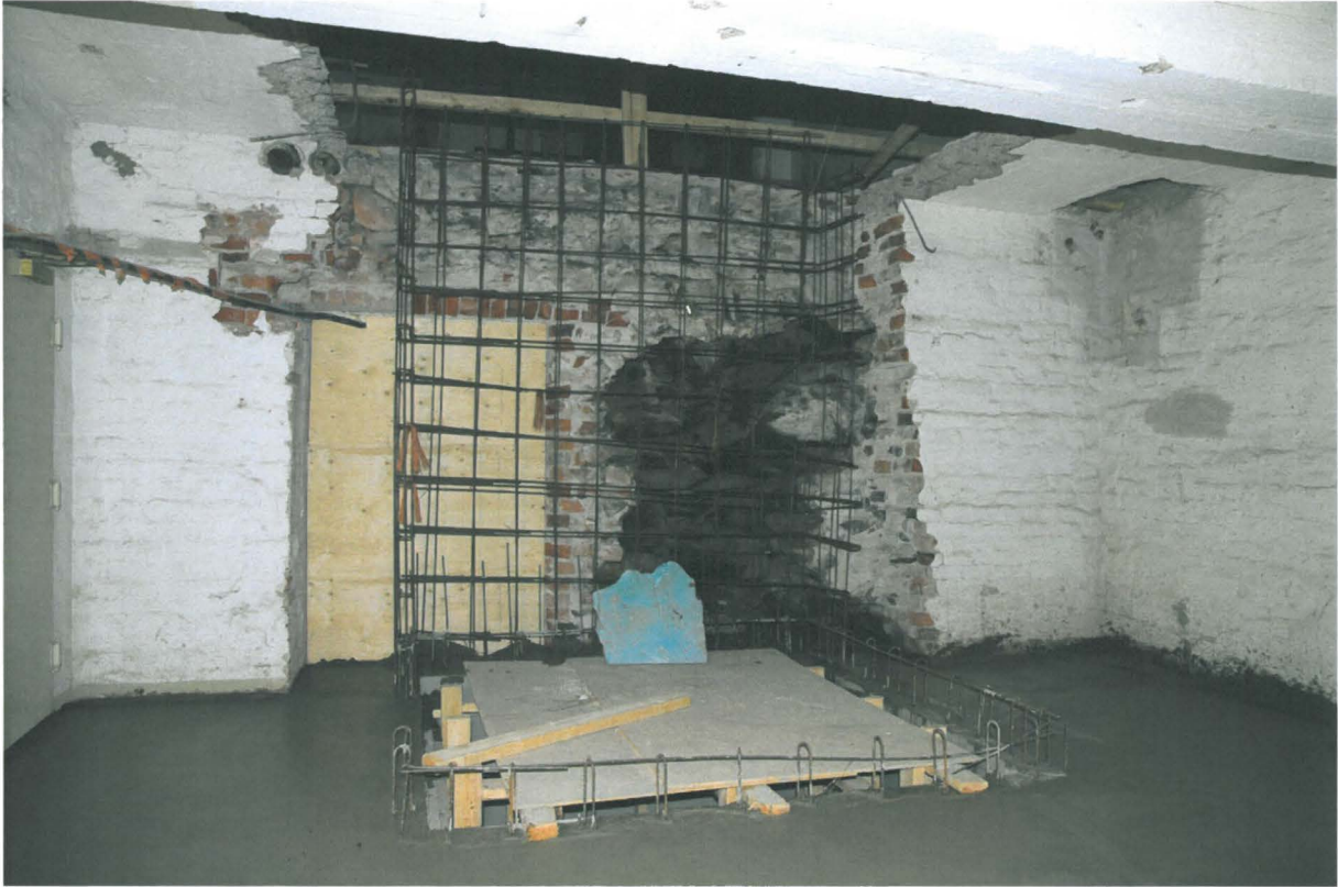
Kuva 116. Kiseleff K057. Hissitilan lattia on valettu ja pohjoisseinän kohta on raudoitettu. Kuvaussuunta NNE. 11.6.2010.
