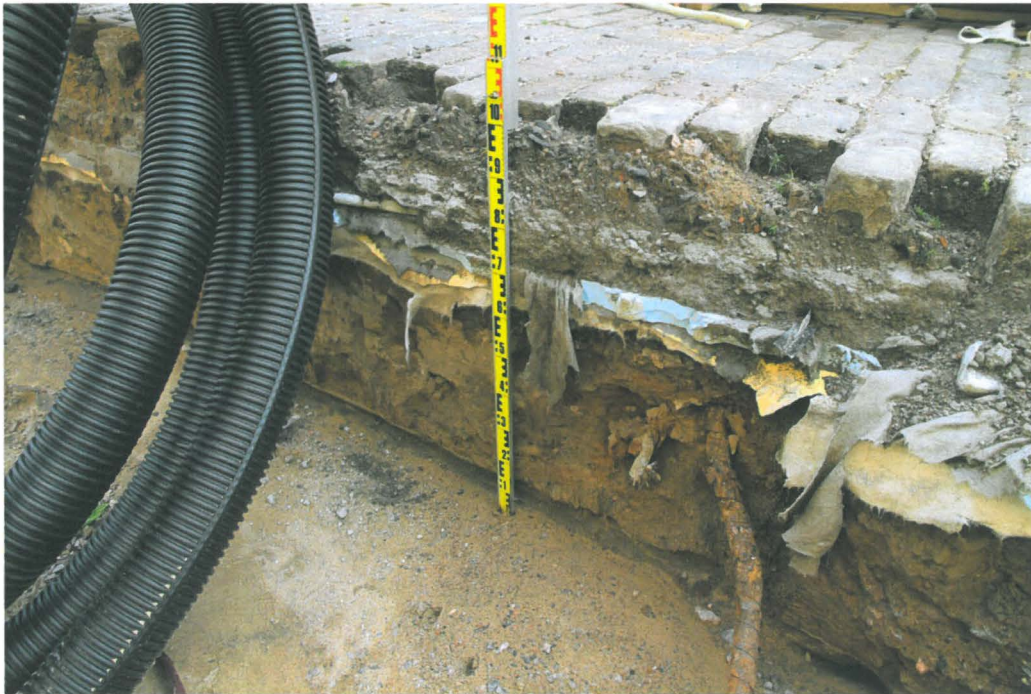
Kuva 205. Sunnin putkikaivanto. Kaivannon itäprofiilia. Kuvasuusuunta NE. 9.7.2010.
