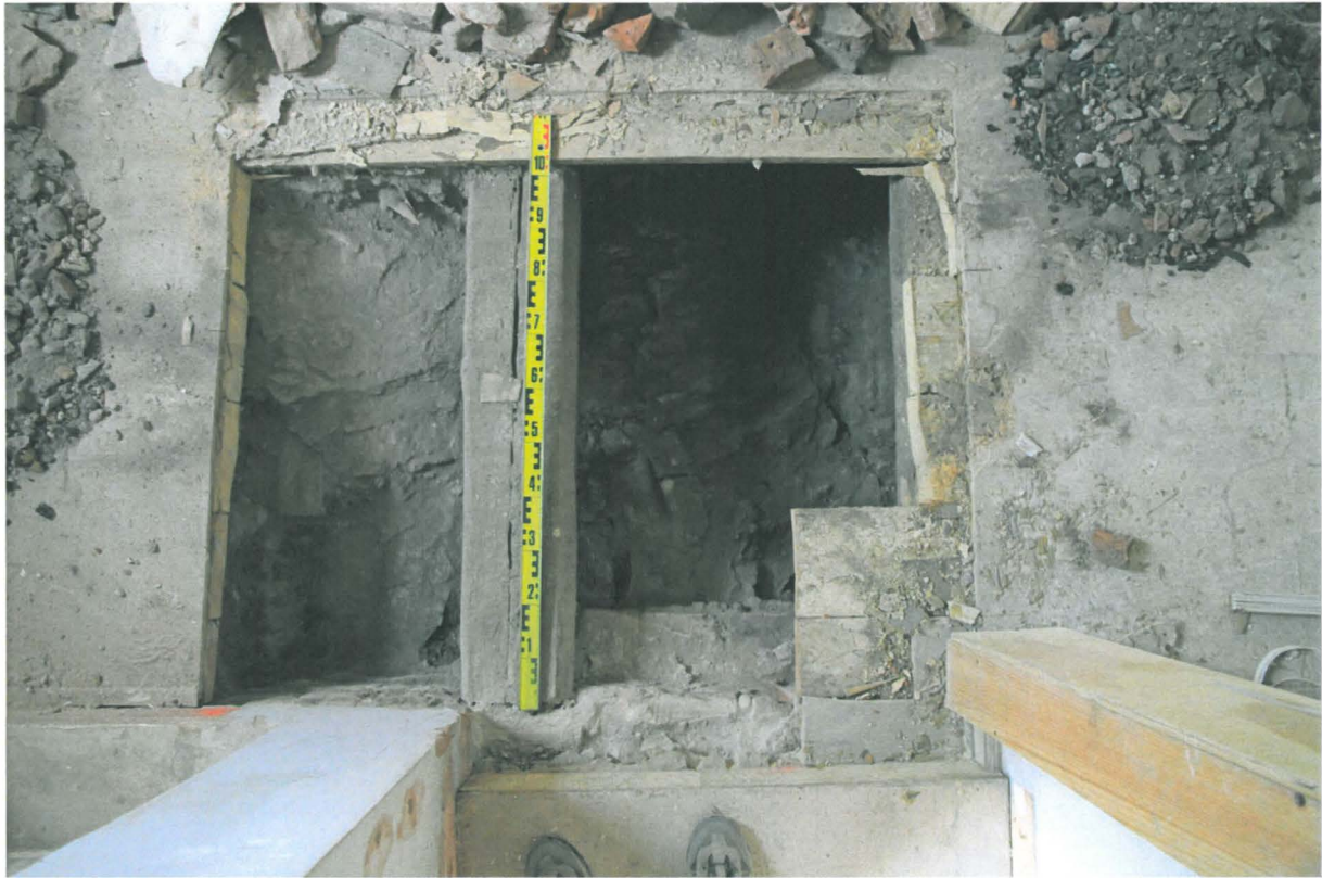
Kuva 138. Sunn S109. Koekuoppa 9. Puulattian alta täytehiekkojen eristämänä tuli esiin kellarin Sunn S014kellarin ja kallariaukon tiiliholvit. Kuvaussuunta E. 15.9.2010.
