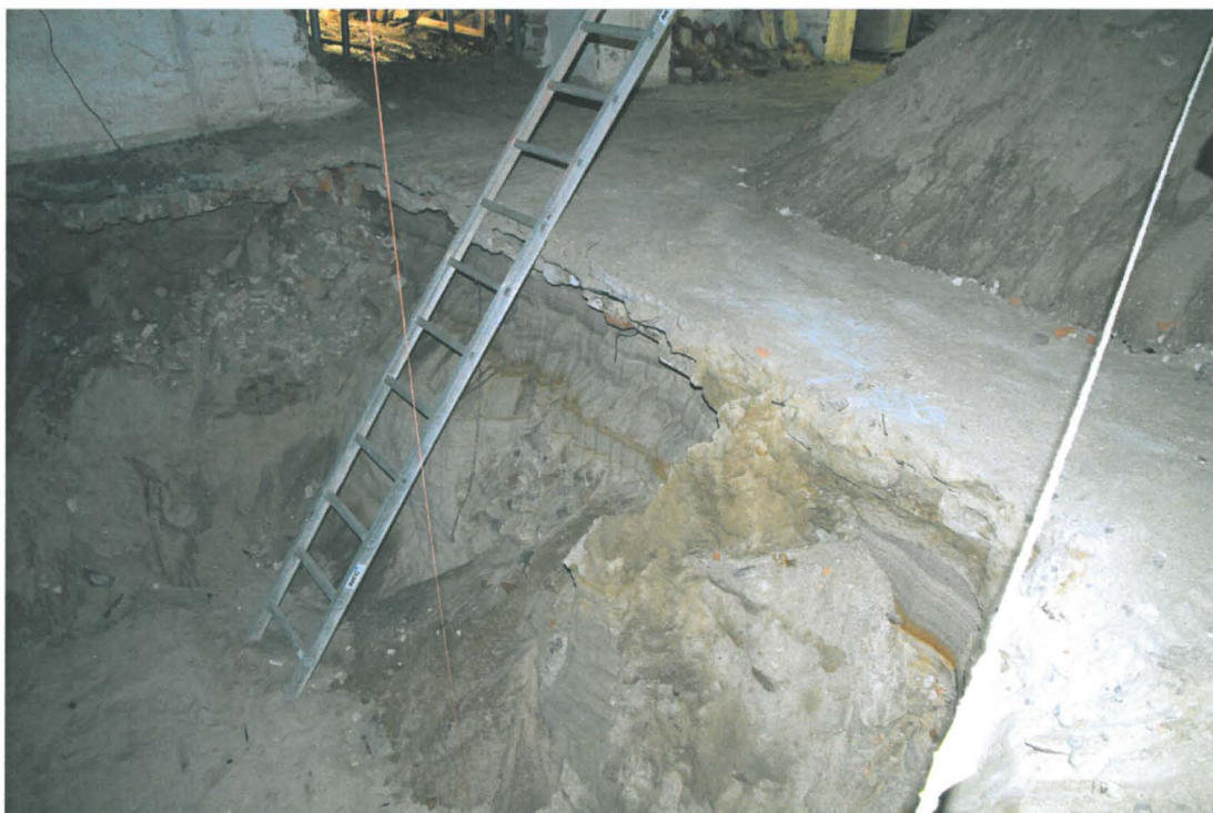
Kuva 111. Kiseleff K057. Hissikuilun kuopan eteläprofiili. Kuvaussuunta SE. 25.5.2010.
