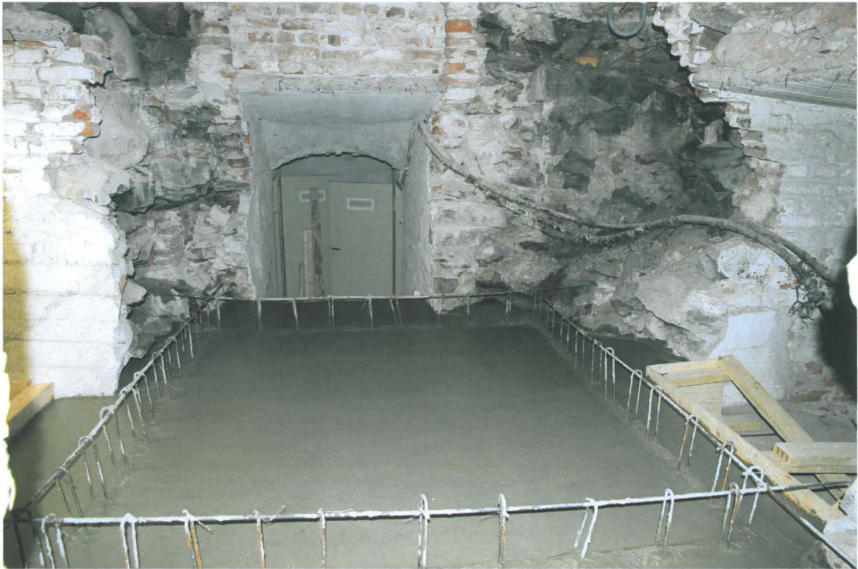
Kuva 64. Sunn S011. Käytävän eteläpään kohdalle ollaan valamassa hissikuilun pohjaa. Ovi johtaa tilaan S012. Oikealle sijaitsee S019 (uusi numero), jonka kautta tehtiin uusi käytävä pihalta S017:een kuvassa näkyvän kohdan mentyä umpeen hissin takia. Kuvaussuunta E.11.6.2010.
