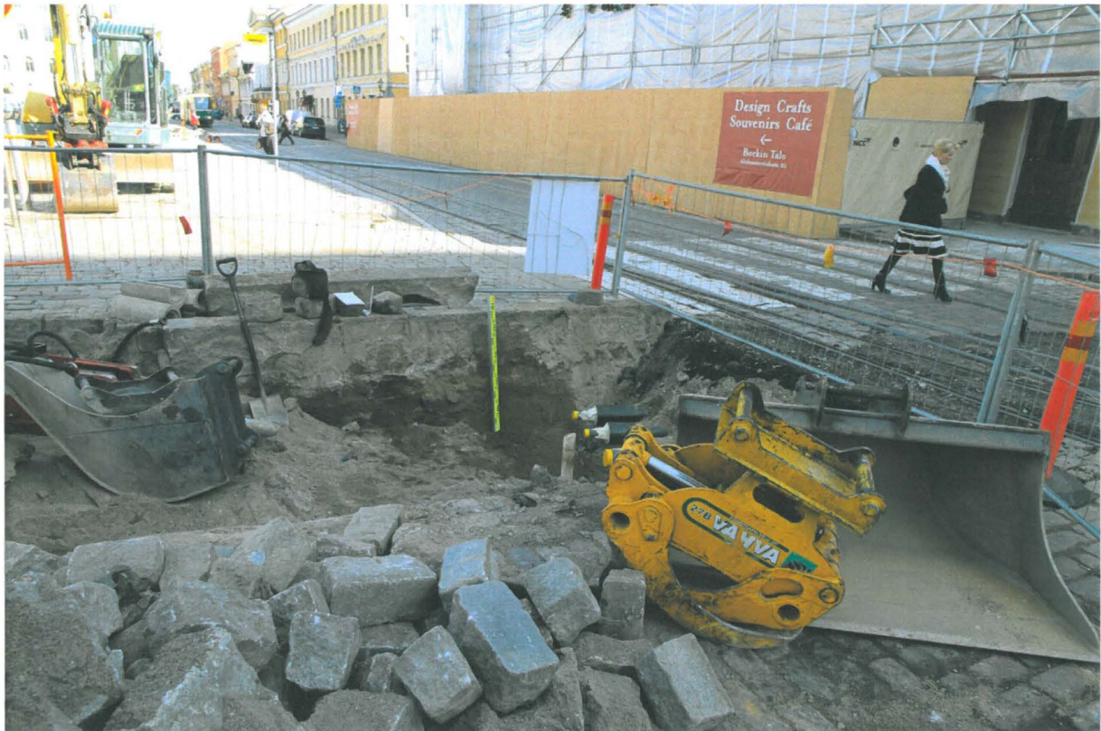
Kuva 171. Kiseleffin putkikaivanto. Kaivannon keskiosan itäprofiilia. Kuvaussuunta SEE. 31.8.2010.
