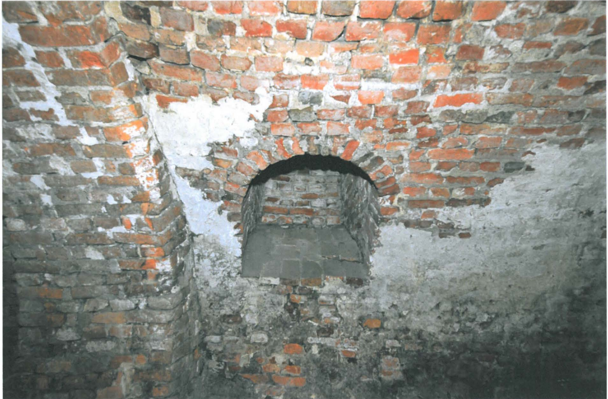
Kuva 35. Sunn S013-014. S014:n pohjoisseinän kellariaukko. Kuvaussuunta N. 22.9.2010.
