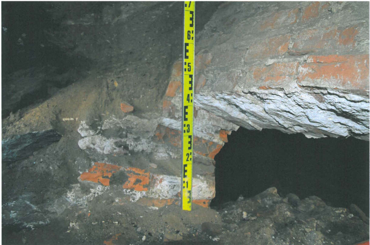
Kuva 187. Kiseleffin putkikaivanto. Aukon itäprofiili tiiliholvin kohdalla. Kuvaussuunta SE. 7.9.2010.
