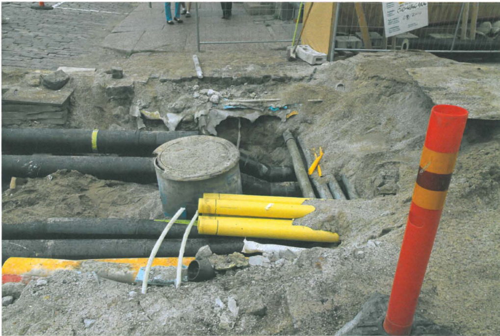
Kuva 199. Sunnin putkikaivanto. Edellinen kohta jalkakäytävän kohdalla. Kuvaussuunta E. 17.8.2010.
