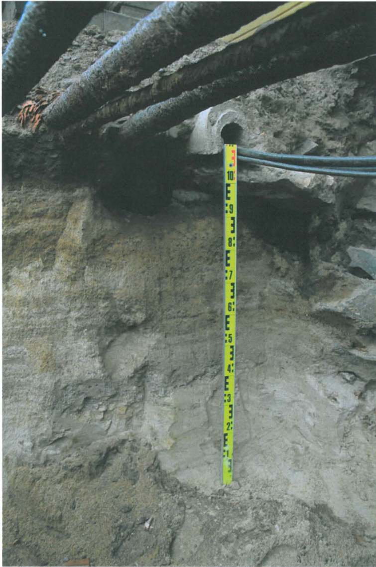
Kuva 181. Kiseleffin putkikaivanto. Kiseleffin jalkakäytävän kaivannon itäprofiili. Kuvaussuunta SEE. 3.9.2010.
