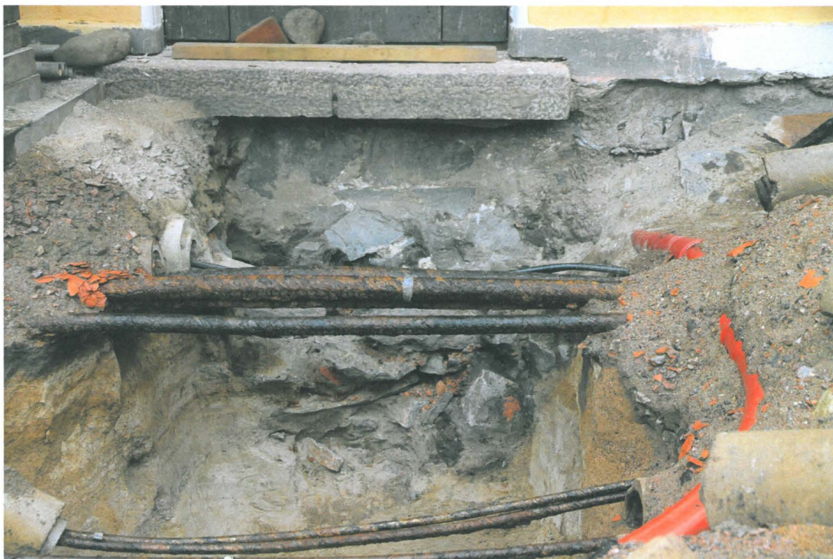
Kuva 177. Kiseleffin putkikaivanto. Kiseleffin pohjoisseinän perustus kaivannon eteläpäässä. Kuvaussuunta S. 3.9.2010.
