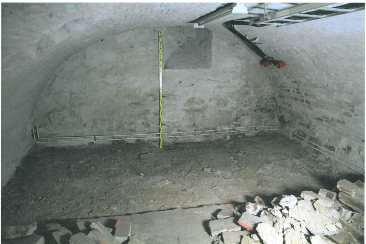
Kuva 2. Kiseleff K061. Kellarin läntisimmästä osasta oli poistettu lattian tiilet kohdalle tulevan kaivon takia. Kuvaussuunta W. 2.3.2010.
