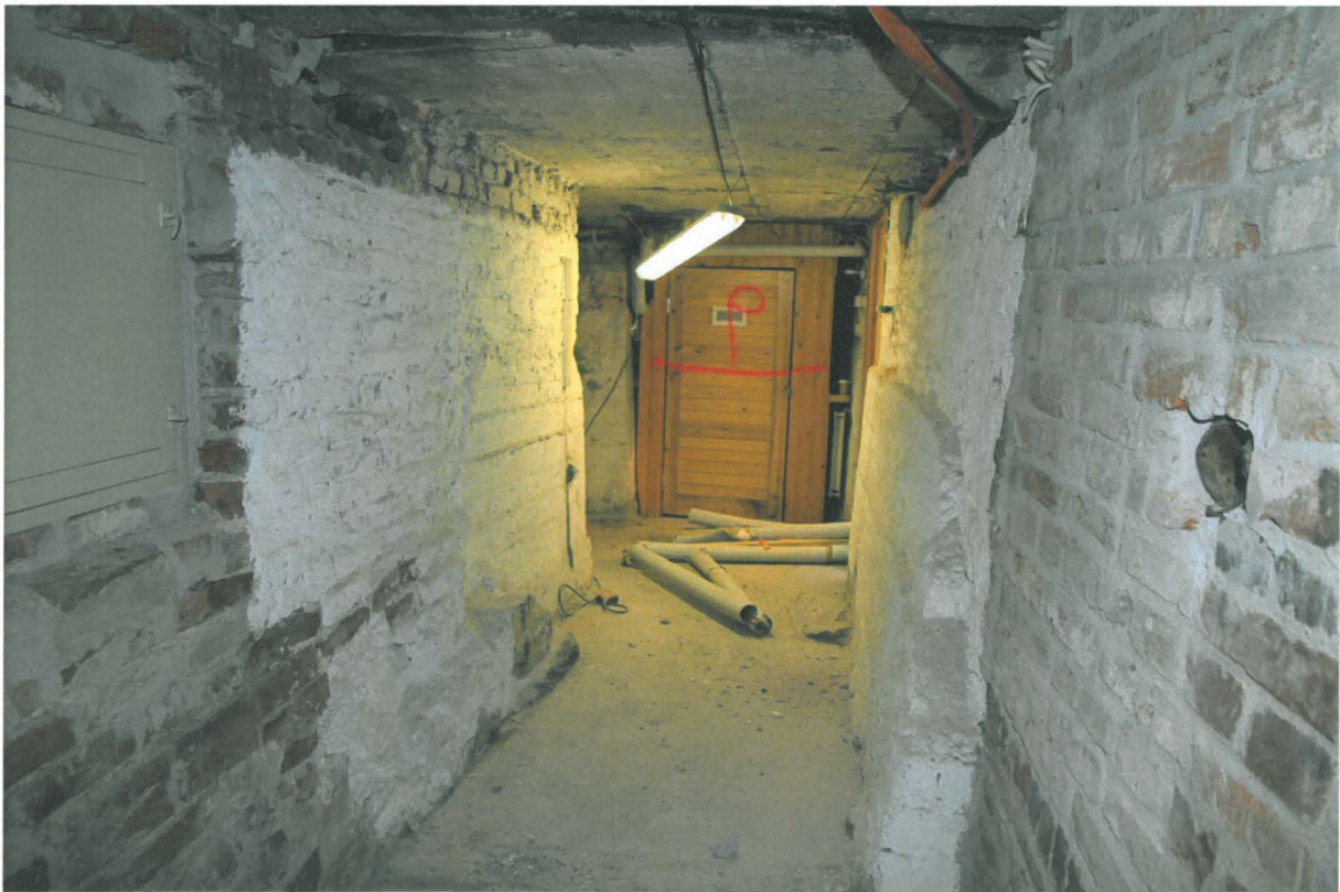
Kuva 63. Sunn S011. Kellarikäytävän eteläpää. Kuvaussuunta S. 25.5.2010.
