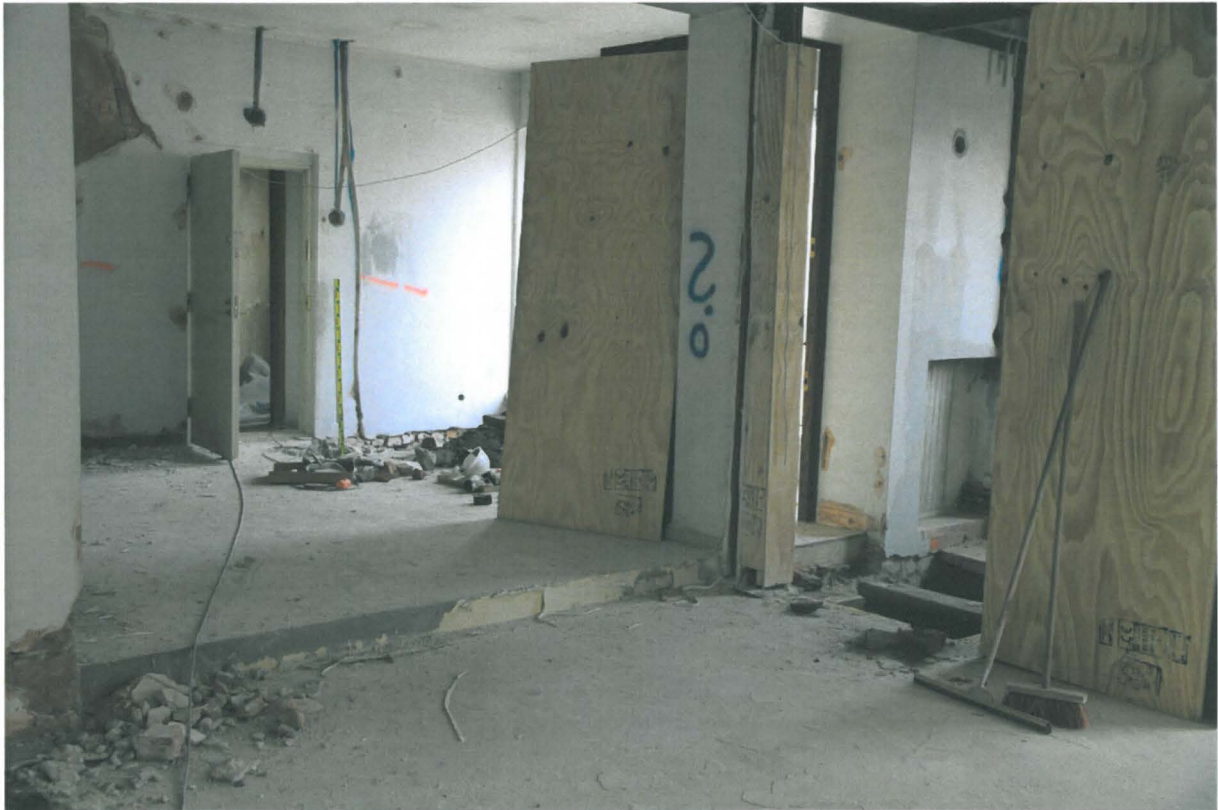
Kuva 130. Sunn S108 ja S109. Vasemmalla näkyy 1. kerroksen Aleksanterinkadun puoleisessa huoneessa S108 koekuoppa 8 ja oikealla tuulikaapissa S109 koekuoppa 9. Kuvaussuunta NW. 14.9.2010.
