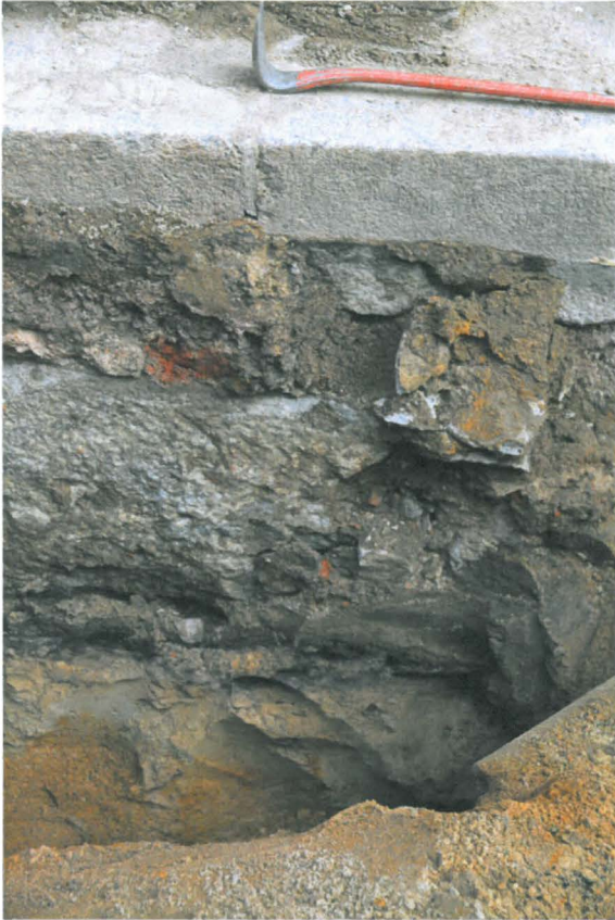
Kuva 240. Unioninkadun jalkakäytävä. Kiseleffin eteläisimmän portaikon alla portaikon perustukset, täytemaata ja tumma vyöhyke ennen puhdasta hiekkaa. Kuvaussuunta E. 20.9.2010.
