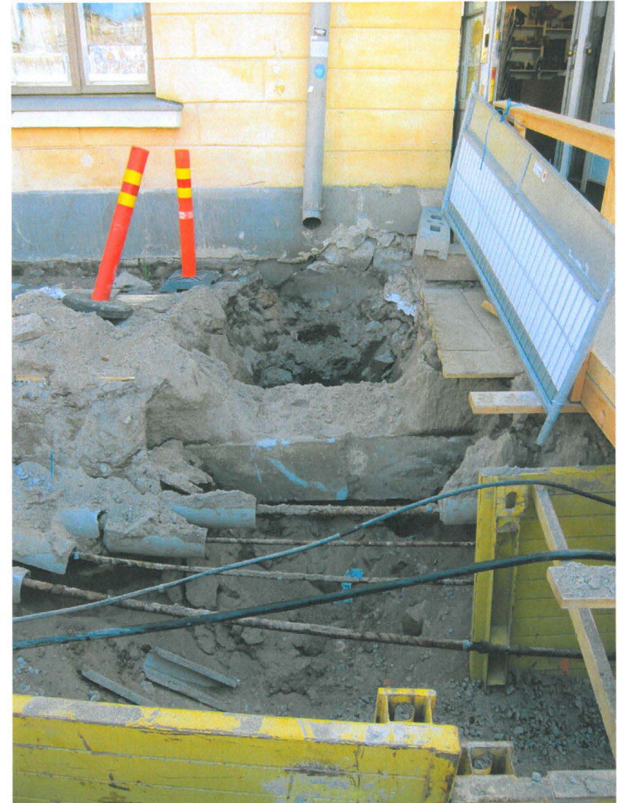
Kuva 231. Aleksanterinkadun jalkakäytävä. Helleniuksen talon länsiossa. Kaapeleiden takana näkyy seinän edessä betoninen suojakansi. Kuvaussuunta S. 7.6.2011.
