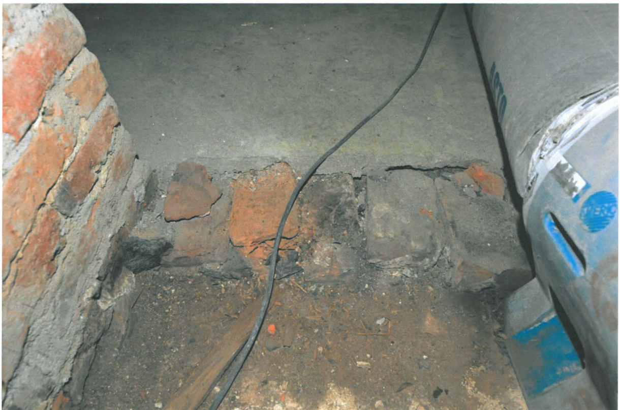
Kuva 30. Sunn S013-014. S013:n oviaukko, jossa näkyy kellarikäytävän betonilattia ja sen alla tiililattia. Kuvaussuunta S. 22.9.2010.
