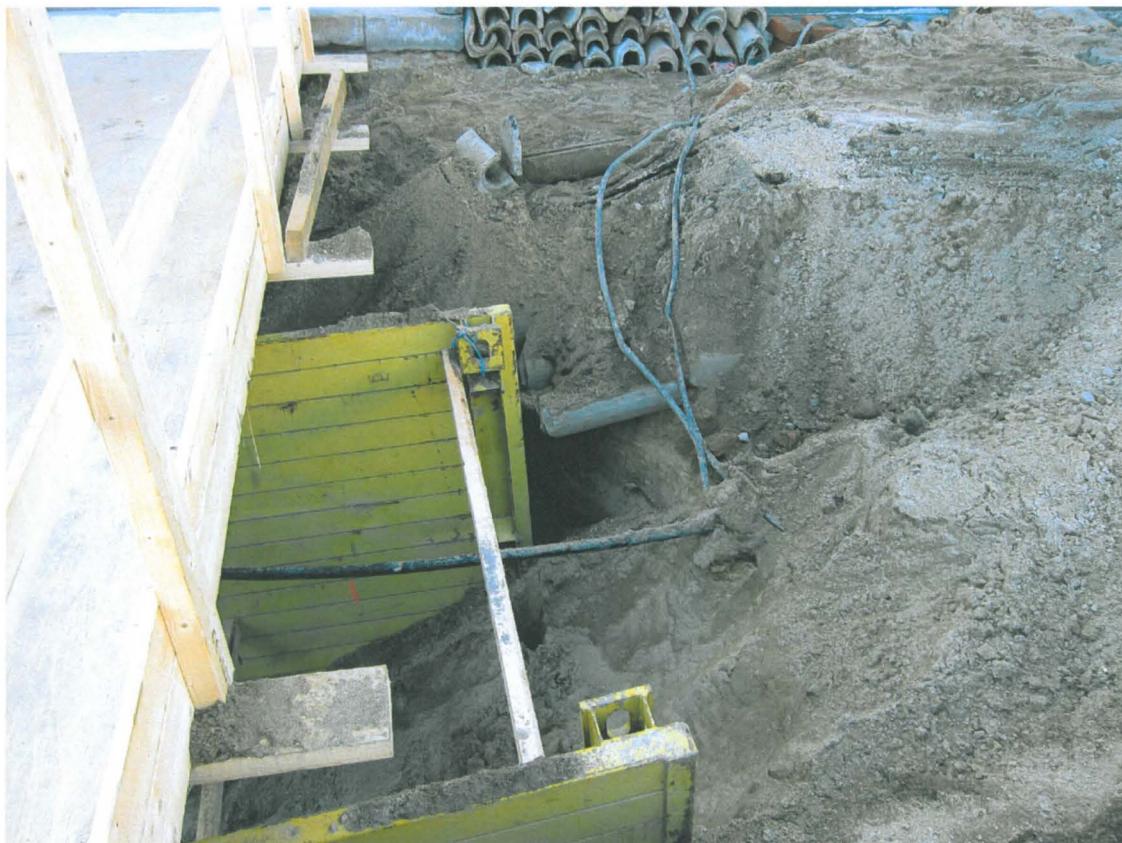
Kuva 218. Aleksanterinkadun jalkakäytävä. Edellisen kuvan sillan kohdalla tukiseinän länsipuolella puhdas hiekka näkyi kaapeleiden alla. Kuvaussuunta S. 20.5.2011.
