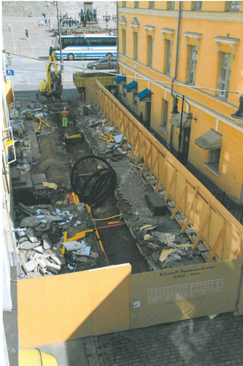
Kuva 201. Sunnin putkikaivanto. Kaivanto Sofiankadun kohdalla. Kuvaussuunta NNE. 9.7.2010.
