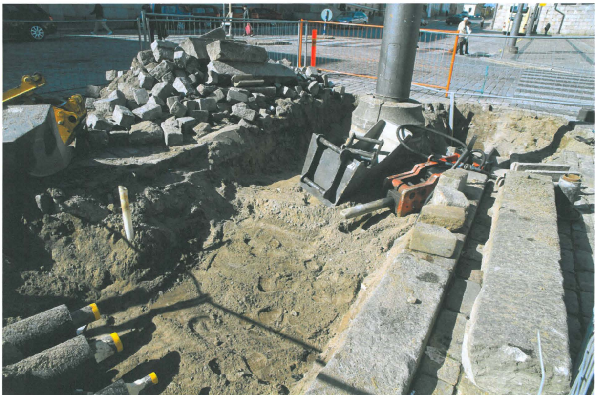
Kuva 168. Kiseleffin putkikaivanto. Lähikuva kaivannon pohjoispäästä. Uudet putket sijoitettiin melko lähelle pintaa. Ne painuivat syvemmälle etelään mentäessä vasta Kiseleffin jalkakäytävän kohdalla. Kuvaussuunta NNW. 31.8.2010.
