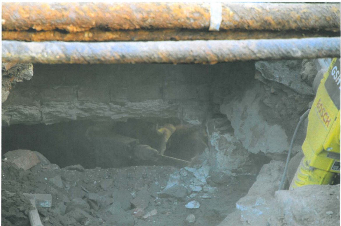
Kuva 184. Kiseleffin putkikaivanto. Seinää piikataan kellarin puolelta. Kuvaussuunta S. 7.9.2010.
