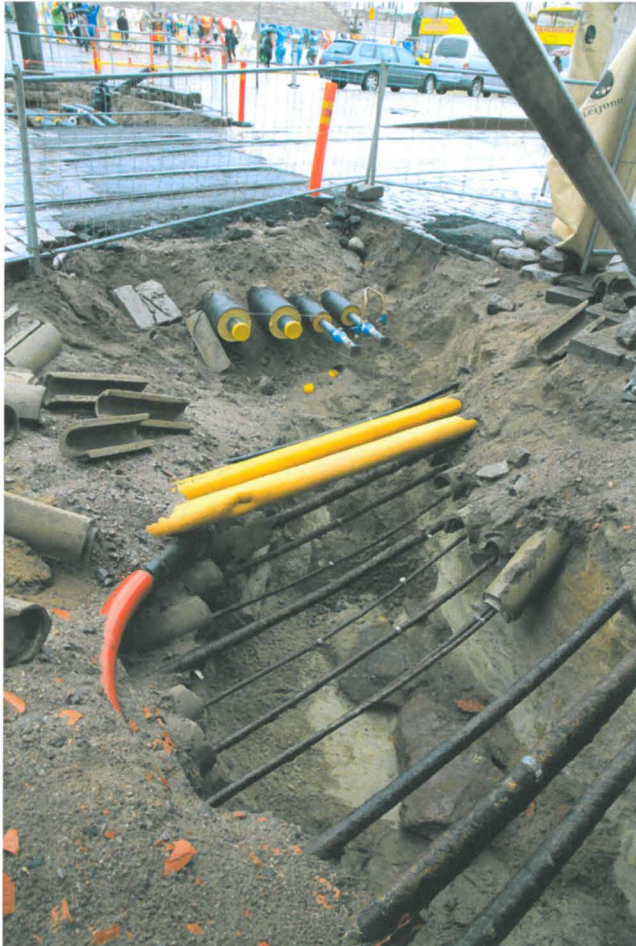
Kuva 180. Kiseleffin putkikaivanto. Edellinen tilanne. Kuvaussuunta NNE. 3.9.2010.
