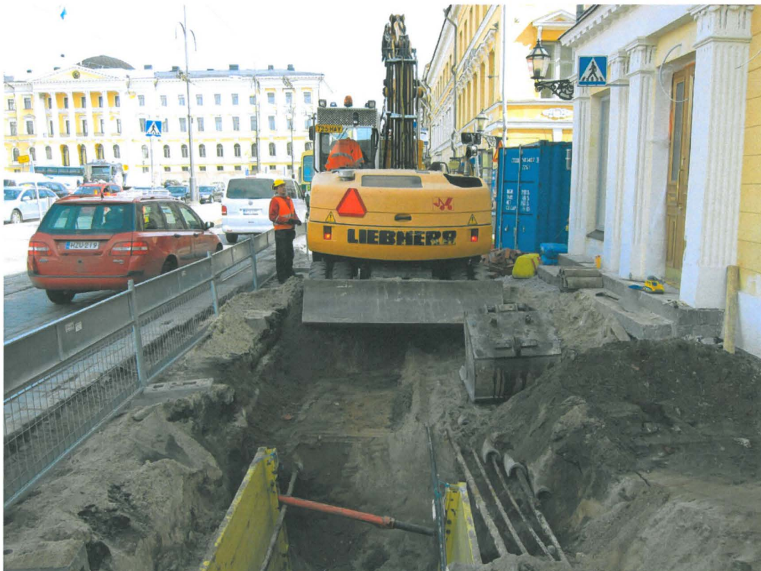
Kuva 212. Aleksanterinkadun jalkakäytävä. Sunnin koilliskulman edessä kaivetaan viemäriä varten syvemmälle. Tukiseinien edessä on maaleikkaus, jossa näkyy puhtaaseen hiekkaan kaivettu kaapelikaivanto tummana hiekkana. Kuvaussuunta E. 3.5.2011.
