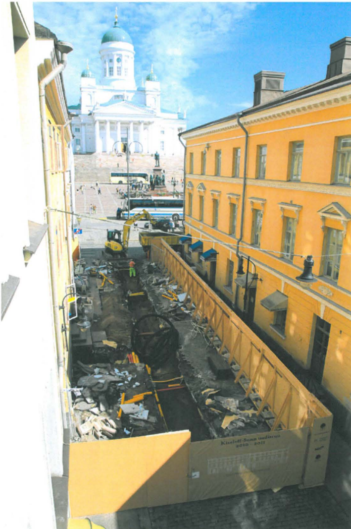
Kuva 200. Sunnin putkikaivanto. Kaivanto Sofiankadun kohdalla. Kuvaussuunta NNE. 9.7.2010.
