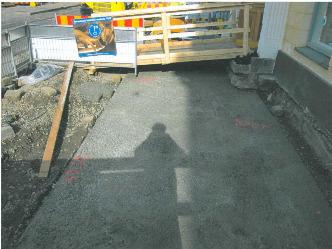
Kuva 224. Aleksanterinkadun jalkakäytävä. Sunnin jalkakäytävän kivilaattojen perustukseksi valettiin betonilaatta. Kuvaussuunta E. 31.5.2011.
