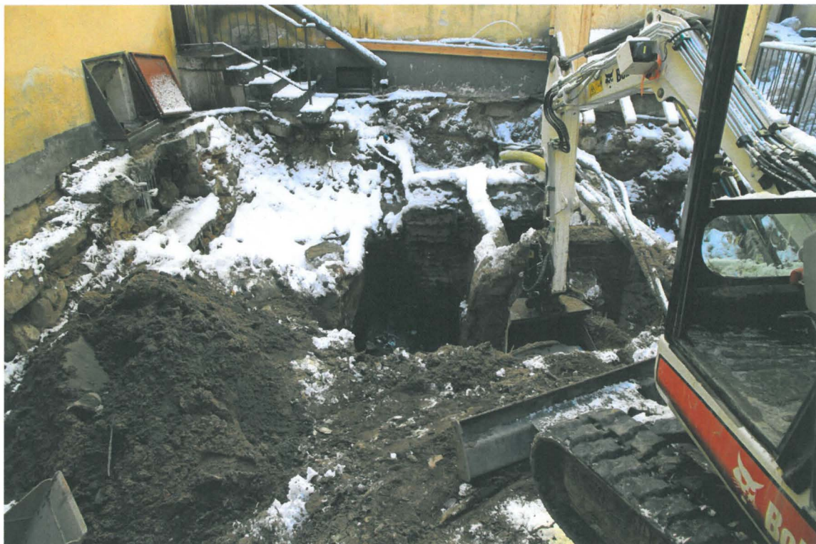
Kuva 151. Sunnin piha. Sunnin pihan pohjoisosasta paljastui konekaivussa tiili- ja betonirakenteita ja porraskäytävä Sunnin kellariin käyttämättömään tilaan (uusi Sunn S020). Kuvasuusuunta N. 22.3.2010.
