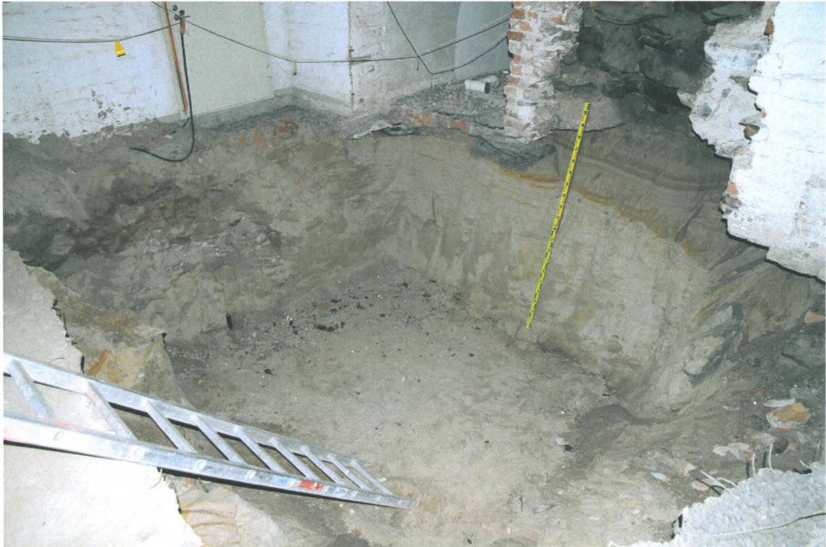
Kuva 102. Kiseleff K057. Etupäässä Kiseleff K057:ään kaivettiin kuoppa hissikuilua varten. Kuvaussuunta NW. 25.5.2010.
