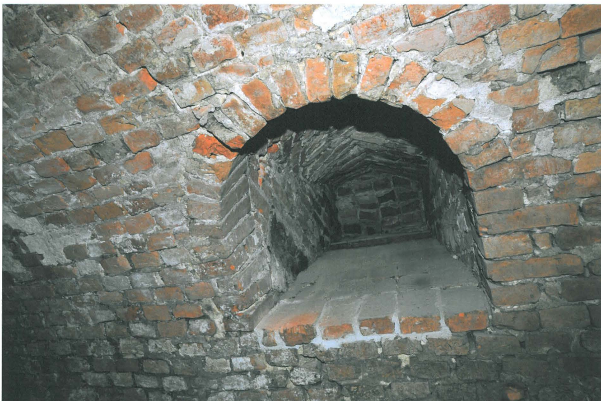
Kuva 34. Sunn S013-014. S013:n pohjoisseinän kellariaukko. Kuvaussuunta N. 22.9.2010.
