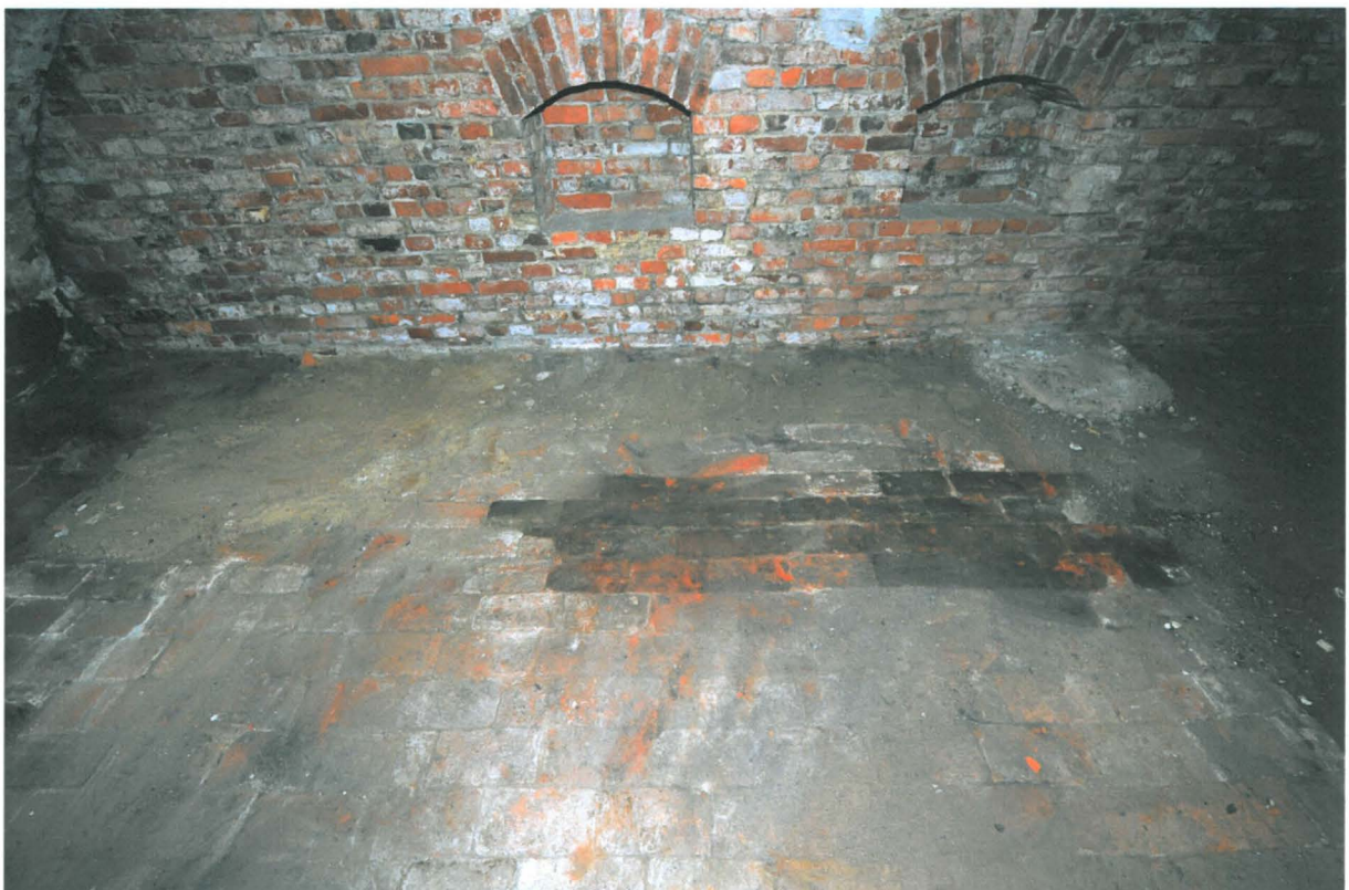
Kuva 26. Sunn S013-014. S014:n koilliskulma ja itäpäädyn komerot. Seinustan vierestä puuttui tiililattia. Kuvaussuunta E. 22.9.2010.
