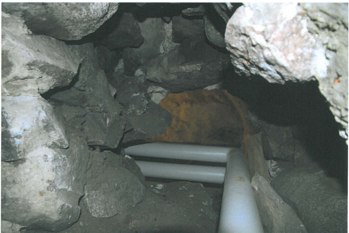
Kuva 54. Sunn S013-014. Lähikuva seinän läpi tehdystä aukosta. Kuvaussuunta W. 8.11.2010.
