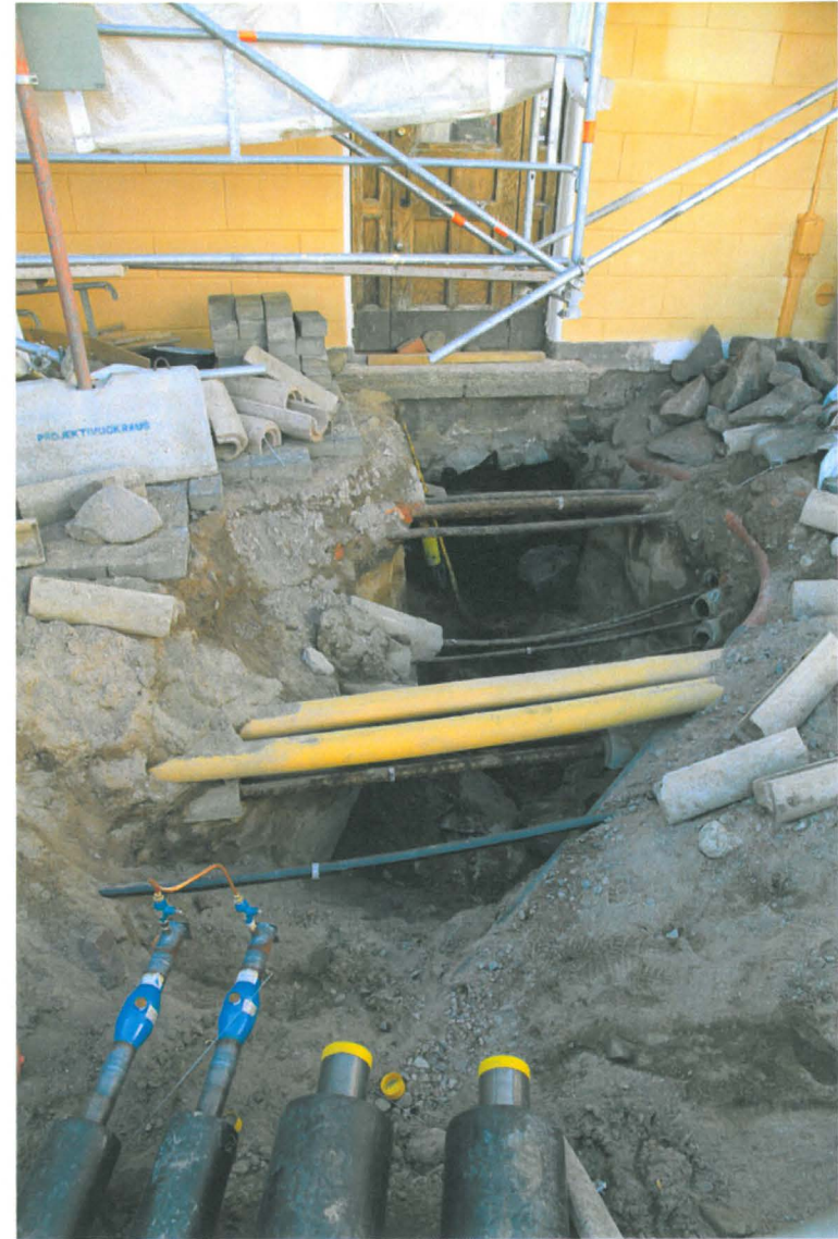
Kuva 182. Kiseleffin putkikaivanto. Kiseleffin kellarin pohjoisseinään tehdään putkien läpiviemistä varten aukkoa. Kuvaussuunta SSW. 7.9.2010.
