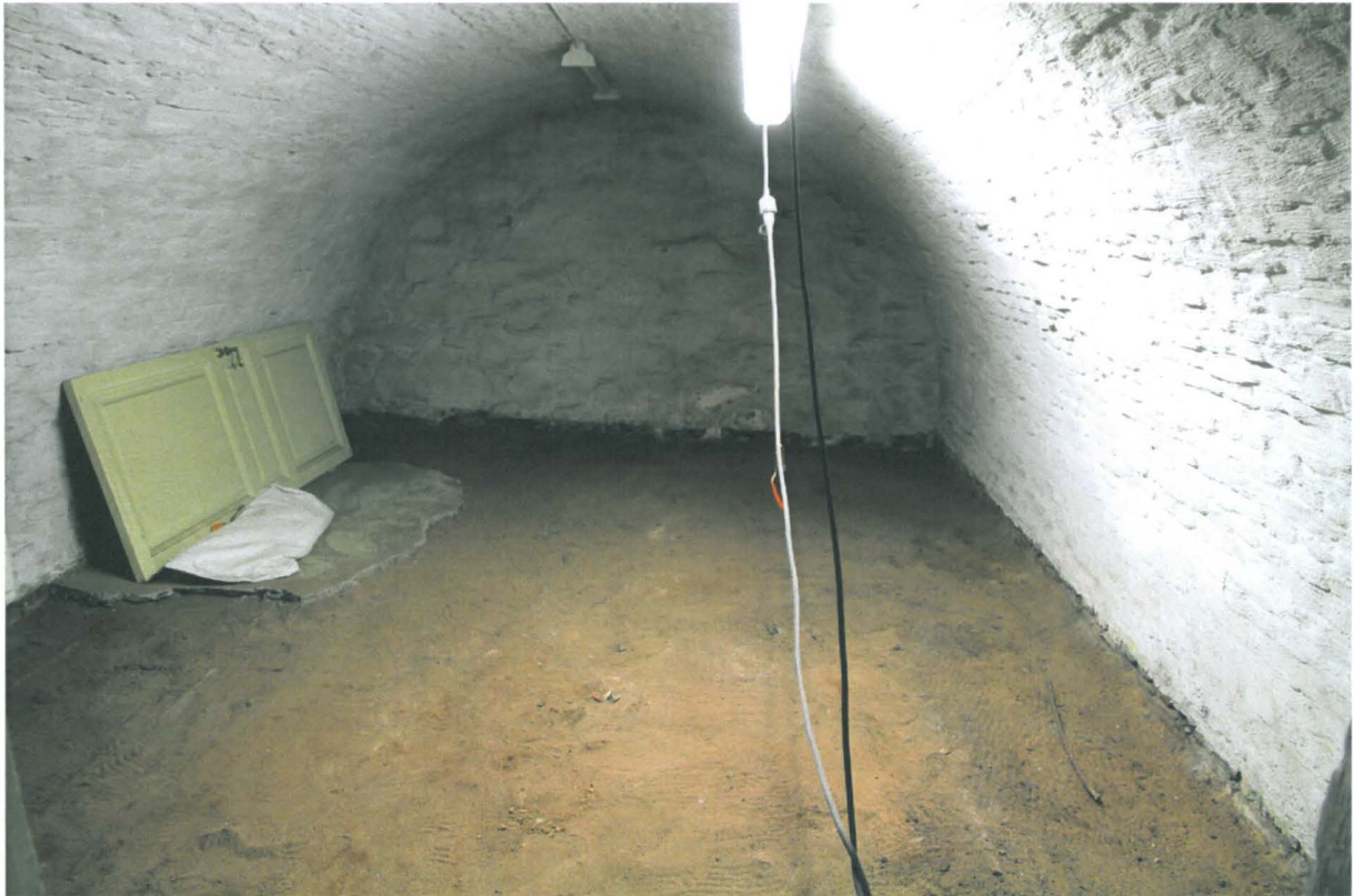
Kuva 68. Sunn S017. Betonilattia on poistettu suurimmaksi osaksi. Itäseinän viereen jätetyn betonilattian alla ei näy tiililattiaa vaan betonilattia on ollut suoraan hiekan päällä. Kuvaussuunta S. 8.3.2010.
