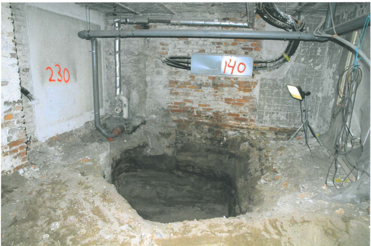
Kuva 119. Kiseleff K016. Huonetilaan kaivettiin kaivoa varten iso kuoppa. Kuvaussuunta W. 22.4.2010.
