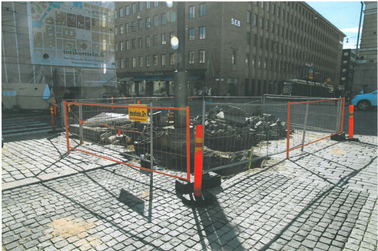
Kuva 165. Kiseleffin putkikaivanto. Kiseleffin kellarista K061 kaivettiin kaukolämmitys- ja kaukojäähdytysputkien kaivannot Aleksanterinkadun poikki. Kaukolämpöputket yhdistettiin vanhoihin kaukolämmitysputkiin Aleksanterinkadun pohjoisen ajoradan eteläreunassa kuvan keskellä. Kaukojäähdytysputket yhdistettiin talvella 2011 Aleksanterinkadun pohjoisen ajoradan pohjoisreunaan kaivettuihin kaukojäähdytysputkiin. Kuvaussuunta SW. 31.8.2010.
