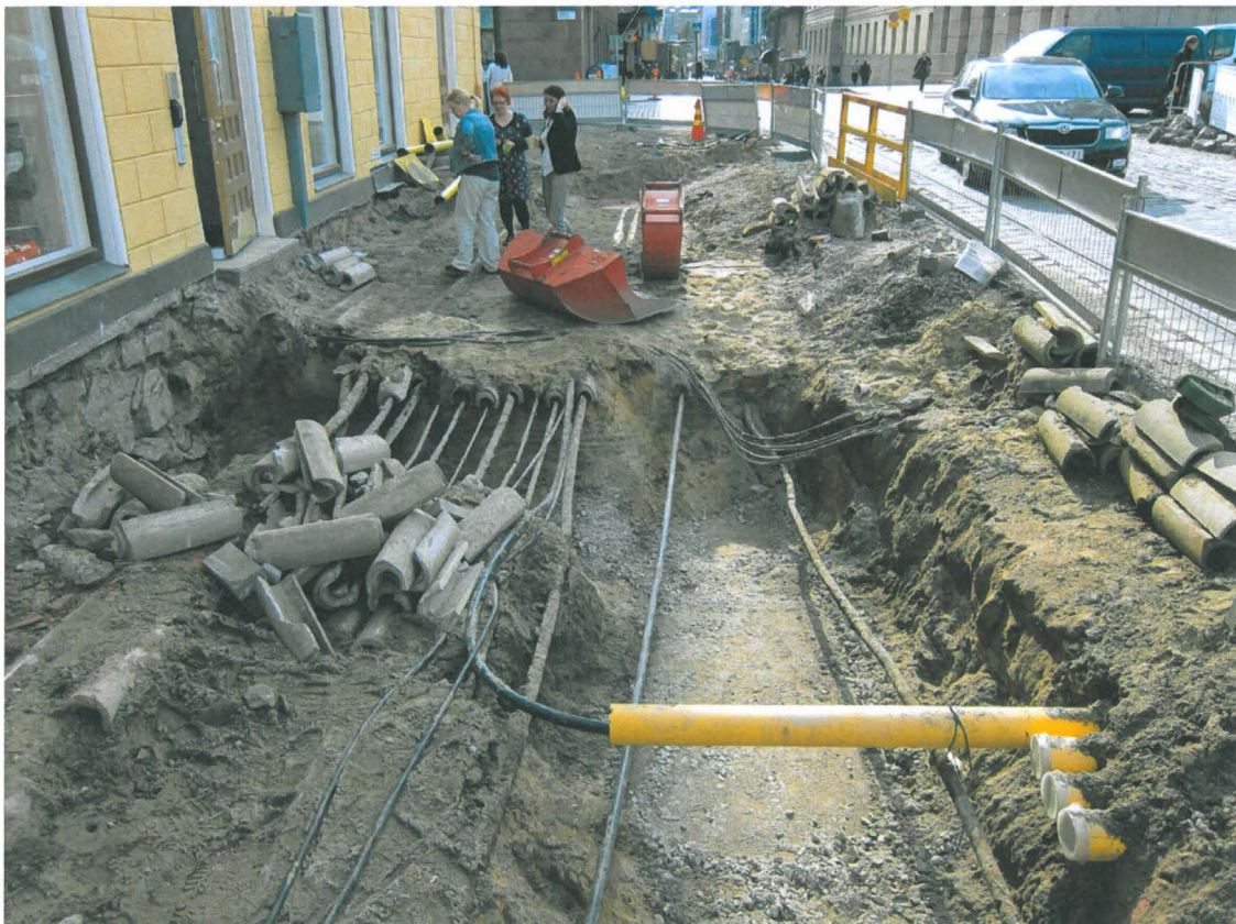
Kuva 220. Aleksanterinkadun jalkakäytävä. Viemärikaivanto Kiseleffin talon pääoven edessä. Kuvaussuunta W. 24.5.2011.
