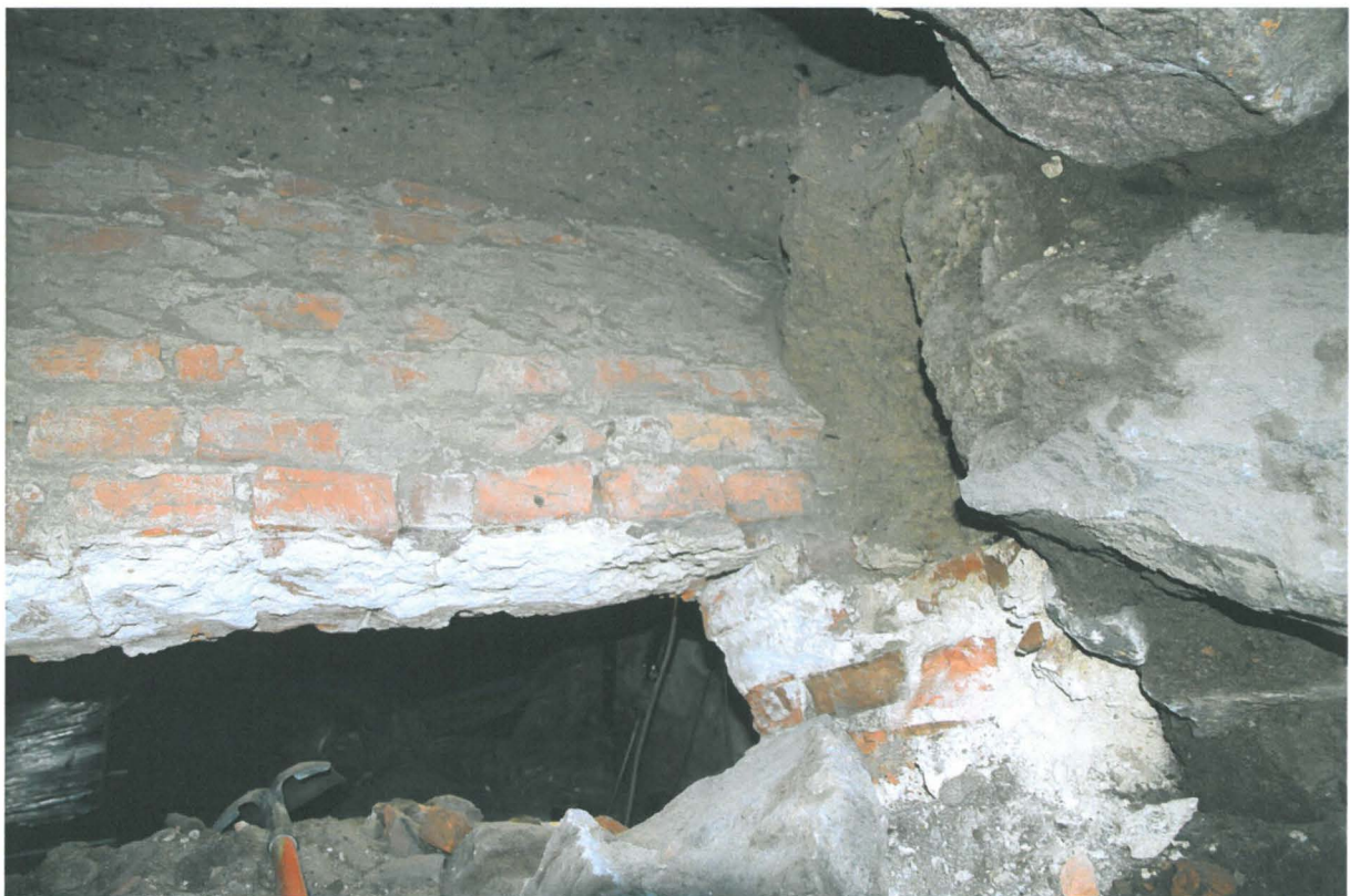
Kuva 186. Kiseleffin putkikaivanto. Aukon länsiprofili kellarin tiiliholvin kohdalla. Kuvaussuunta SW. 7.9.2010.
