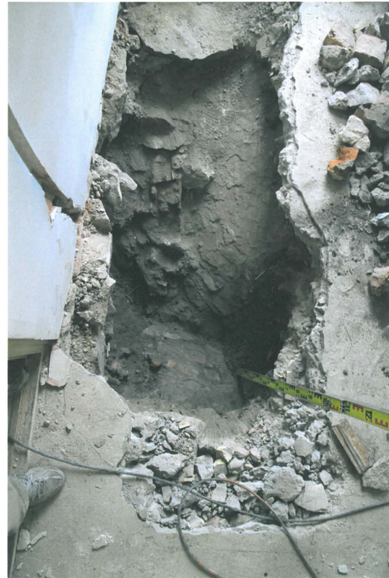
Kuva 133. Sunn S108. Lähikuva koekuopasta 8. Pohjalla näkyy Sunnin kellarin S013 kellarin ja kellariaukon tiiliholvit. Kuvaussuunta N. 14.9.2010.
