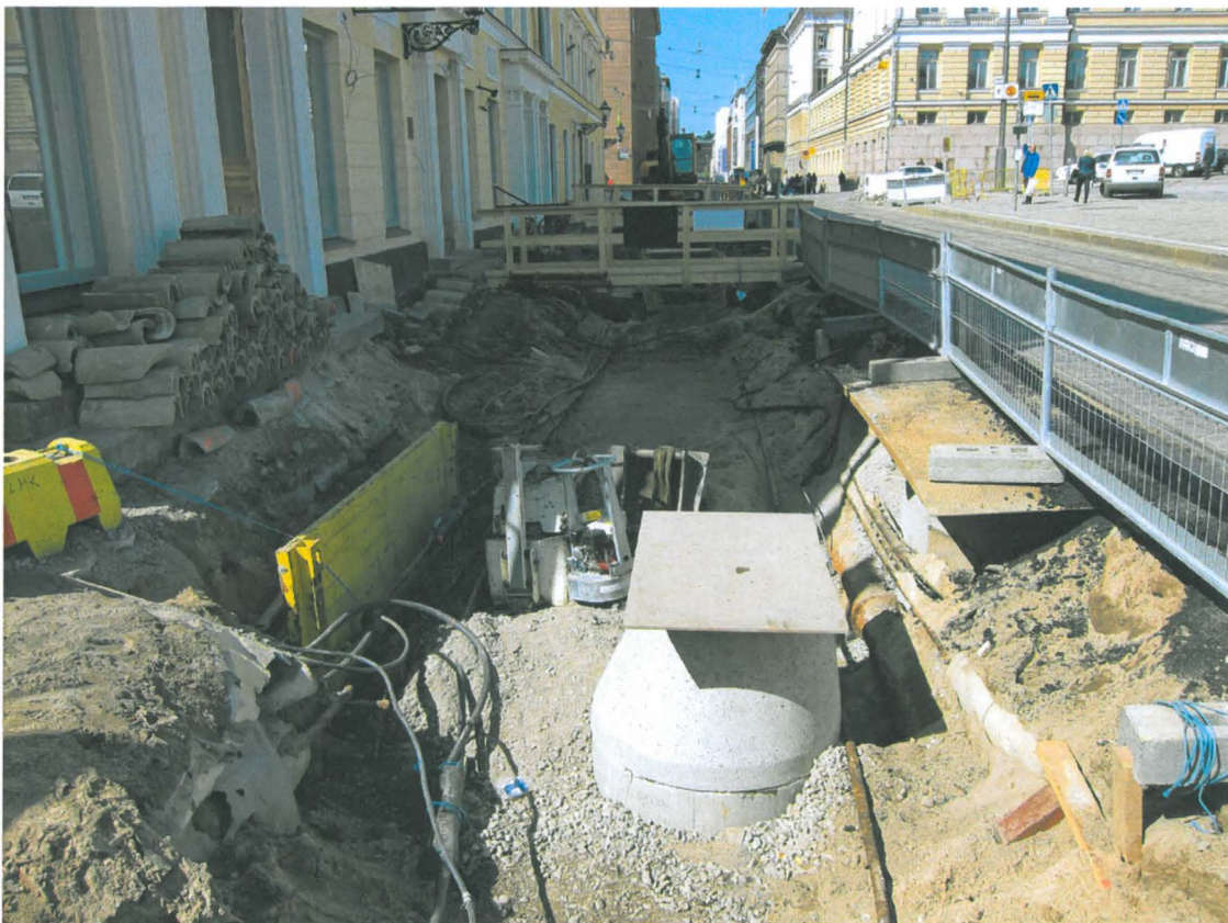
Kuva 214. Aleksanterinkadun jalkakäytävä. Edellinen kohta, kun putki on peitetty soralla. Kuvaussuunta W. 20.5.2011.
