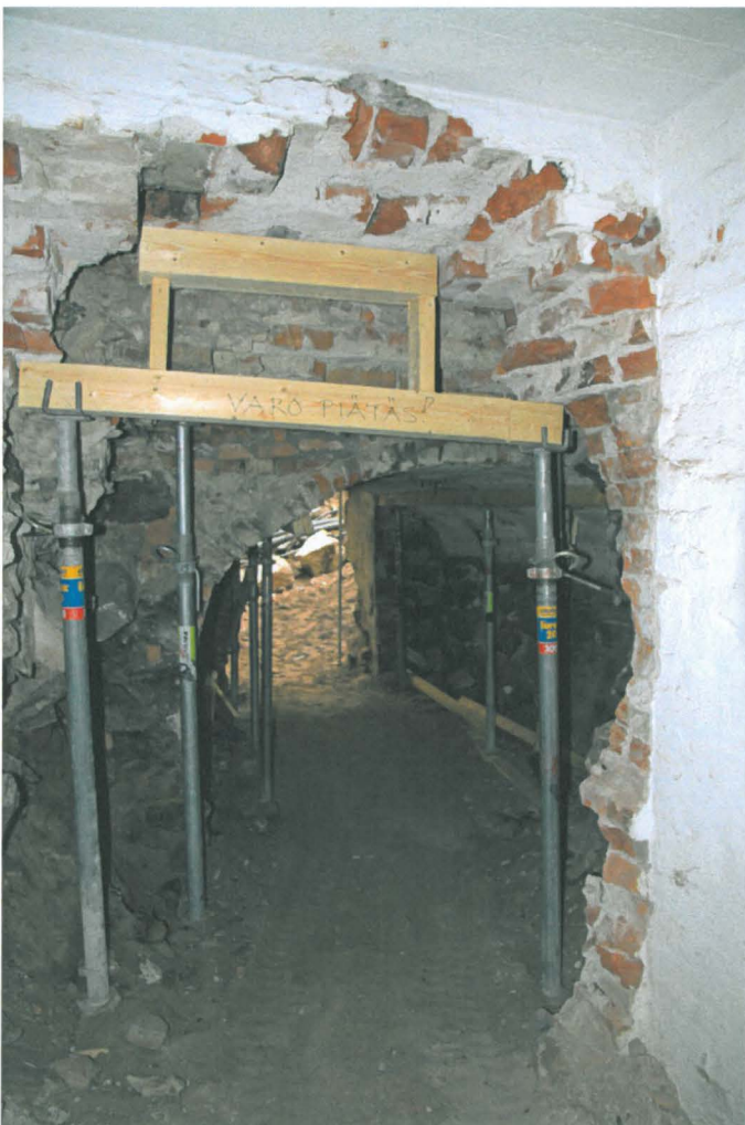
Kuva 99. Sunn S020. Kellaritila kuvattuna Kiseleffin puolelta. Kuvaussuunta SEE. 31.3.2010.
