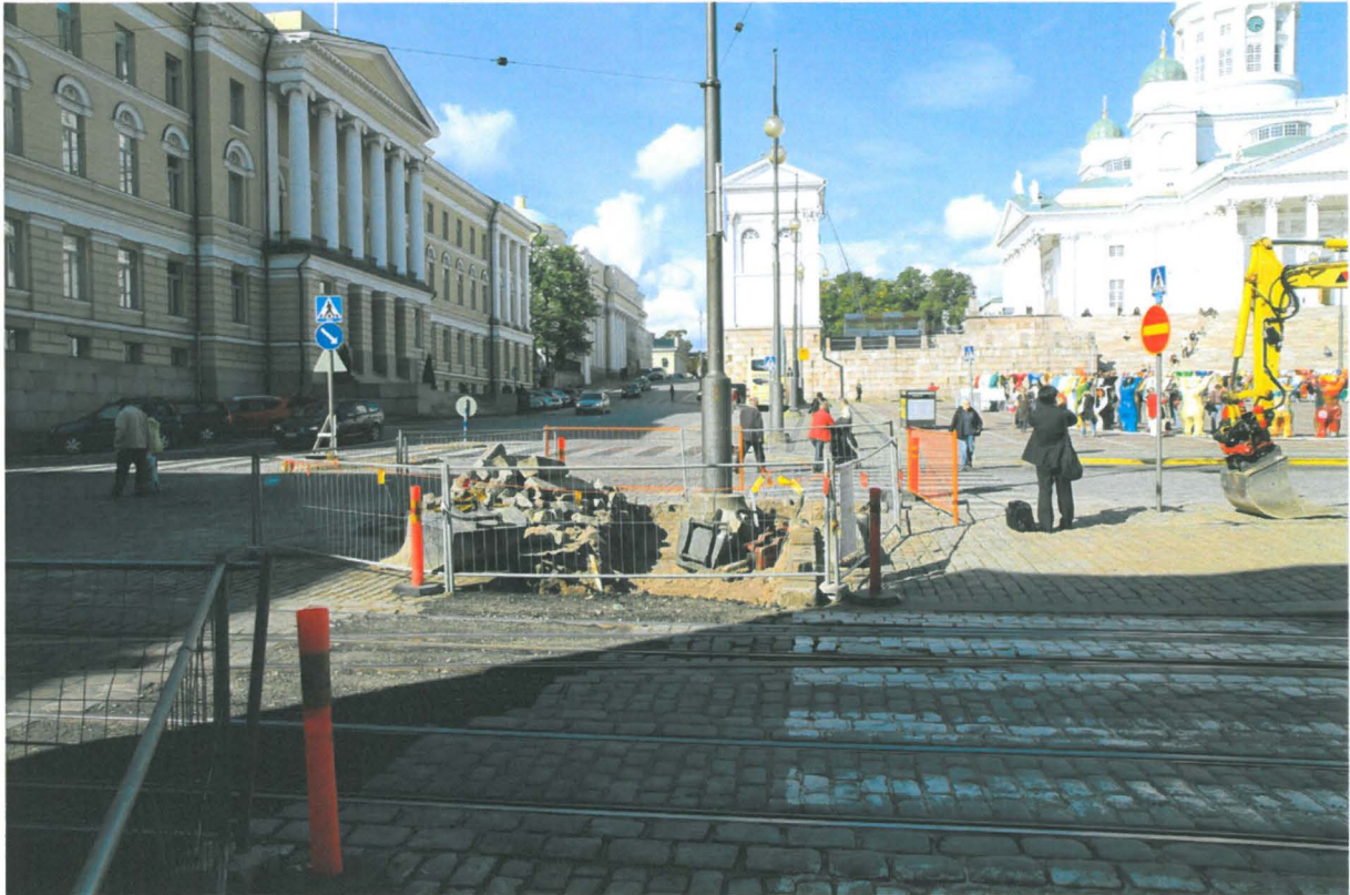
Kuva 167. Kiseleffin putkikaivanto. Edellinen tilanne. Kuvaussuunta NNW. 31.8.2010.
