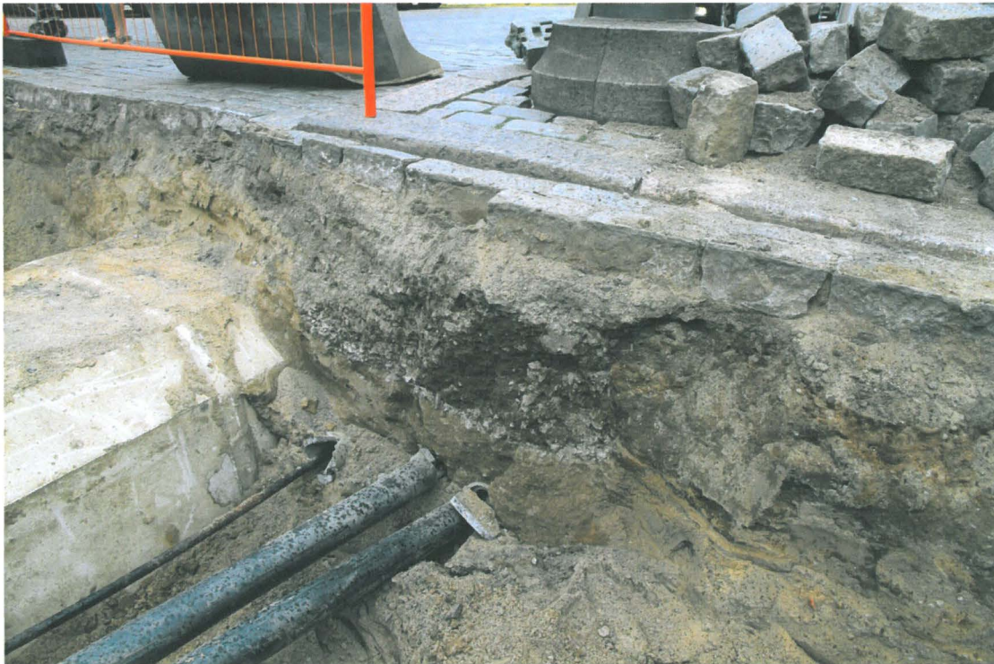
Kuva 193. Sunnin putkikaivanto. Lähikuva kaivannon itäprofiilista vanhan kaukolämpökanavan eteläpuolelta. Kuvaussuunta NE. 17.8.2010.
