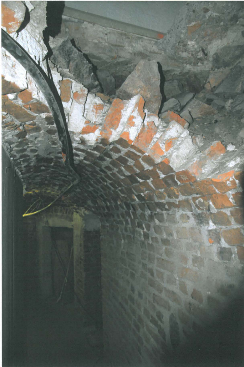
Kuva 60. Sunn S010. Kellarikäytävän itäosa kuvattuna länteen päin rikutusta kohdasta käsin. Vasemmalla näkyy nyt tehty betoninen tukirakenne. Kuvaussuunta W. 8.11.2010.
