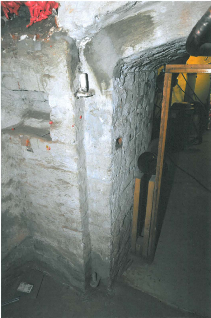
Kuva 21. Kiseleff. Saranatapit poistetun oven kohdalla. 22.9.2010.
