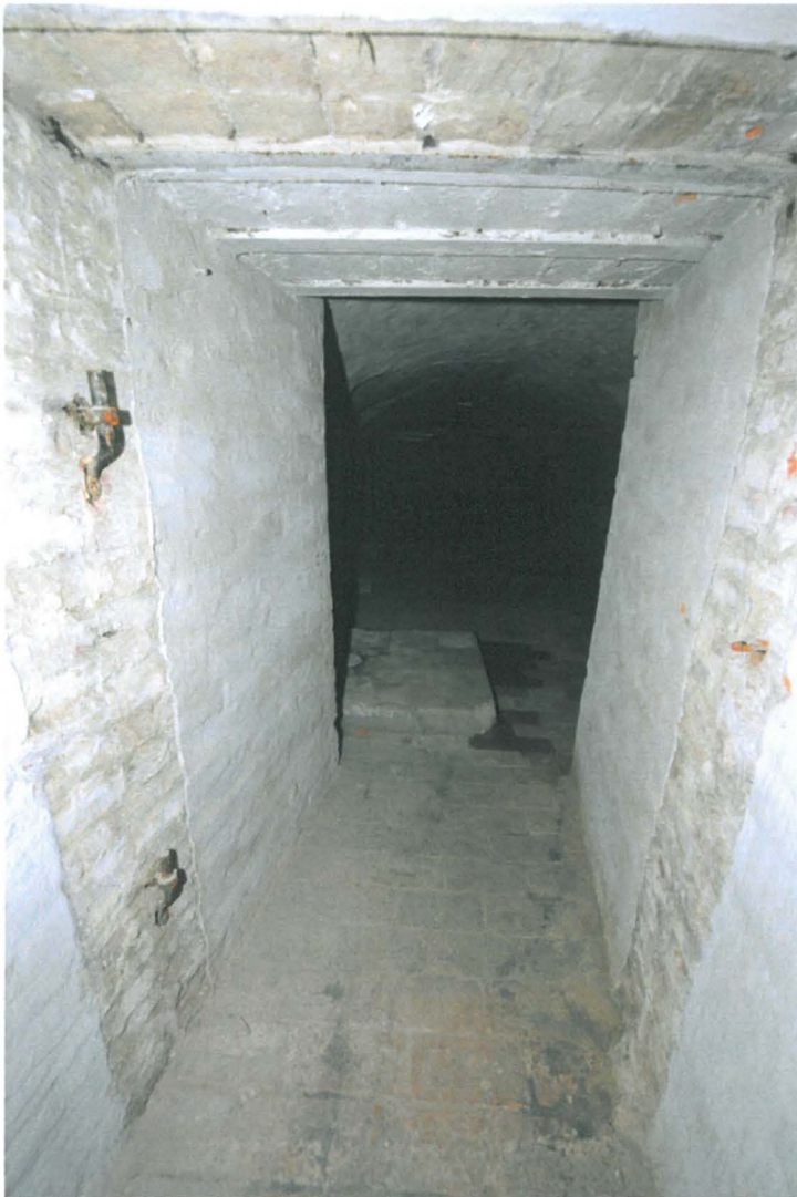
Kuva 13. Kiseleff K064 ja Sunn S003. Kiseleffin ja Sunnin kellarien välinen käytävä. Kuvaussuunta W. 22.9.2010.
