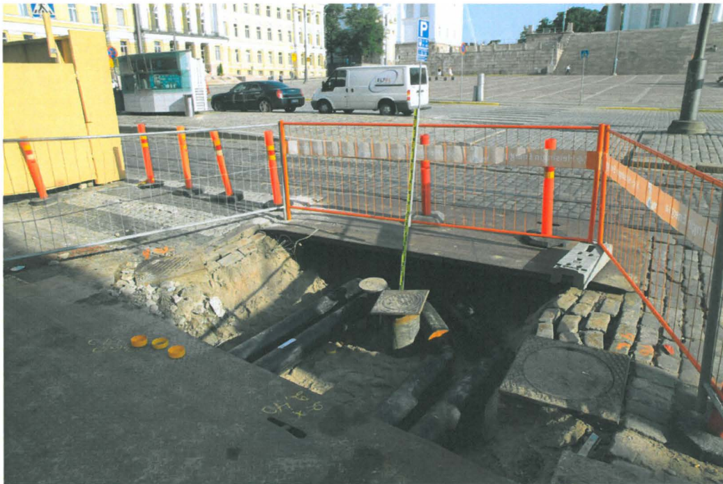
Kuva 197. Sunnin putkikaivanto. Putket oli asennettu kaivantoon Aleksanterinkadun eteläreunassa jo ennen edellisten kuvien ottamista. Kuvaussuunta NW. 28.7.2010.
