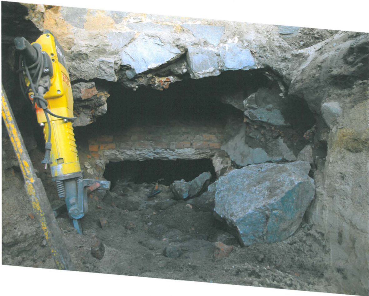
Kuva 183. Kiseleffin putkikaivanto. Kiviseen perustusmuurin ja kellarin tiiliholvaukseen on tehty aukko putkia varten. Kuvaussuunta S. 7.9.2010.
