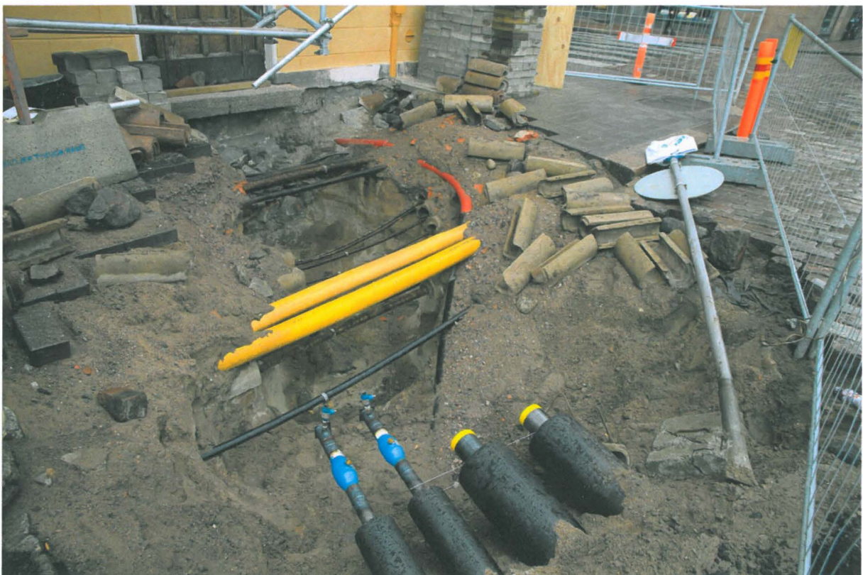
Kuva 176. Kiseleffin putkikaivanto. Kaivanto on syvennetty jalkakäytävän kohdalla putkien viemiseksi Kiseleffin kellarin K061, jonne tuli lämmönjakelukeskus. Kuvaussuunta SW. 3.9.2010.
