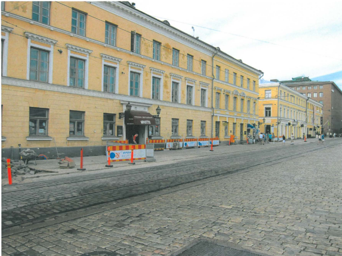
Kuva 236. Aleksanterinkadun jalkakäytävä. Jalkakäytävä alkaa valmistua Leijonakorttelin alueella. Kuvaussuunta SW. 27.7.2011.
