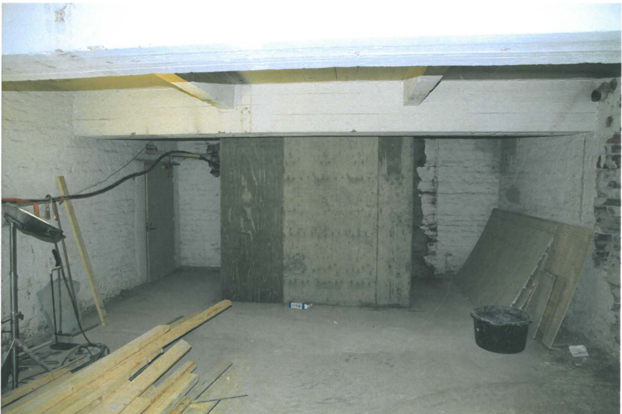
Kuva 117. Kiseleff K057. Hissikuilu on valettu. Kuvaussuunta N. 29.6.2010.
