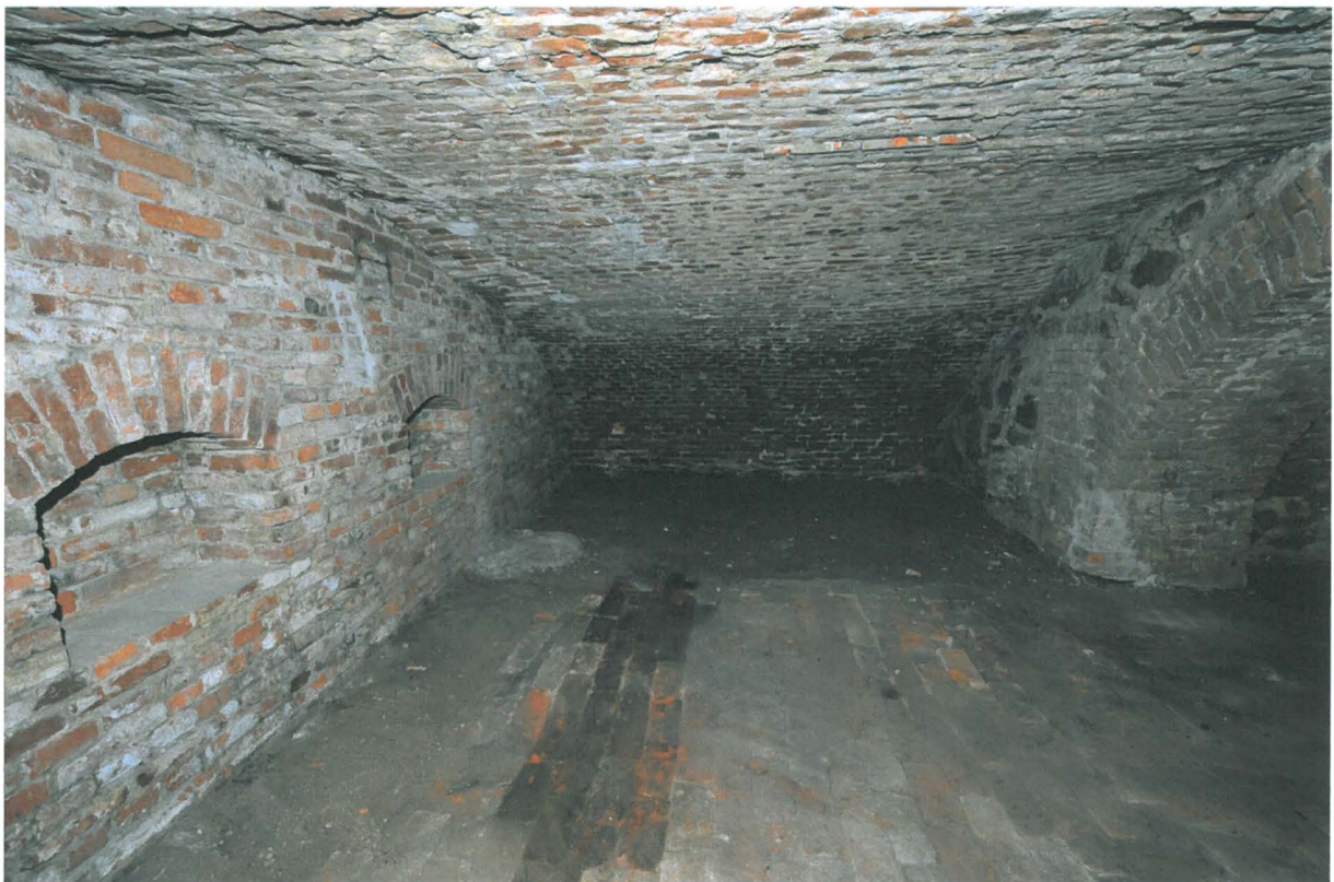
Kuva 24. Sunn S013-014. Kellaritilojen itäosa S014:n kohdalla. Kuvaussuunta S. 22.9.2010.
