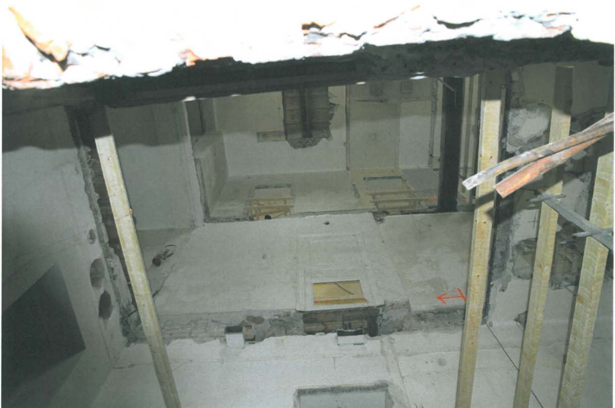
Kuva 65. Sunn S011. Hissikuilun kohdalta poistettiin lattiat koko rakennuksen korkeudelta. Kuvaussuunta E. 11.6.2010.
