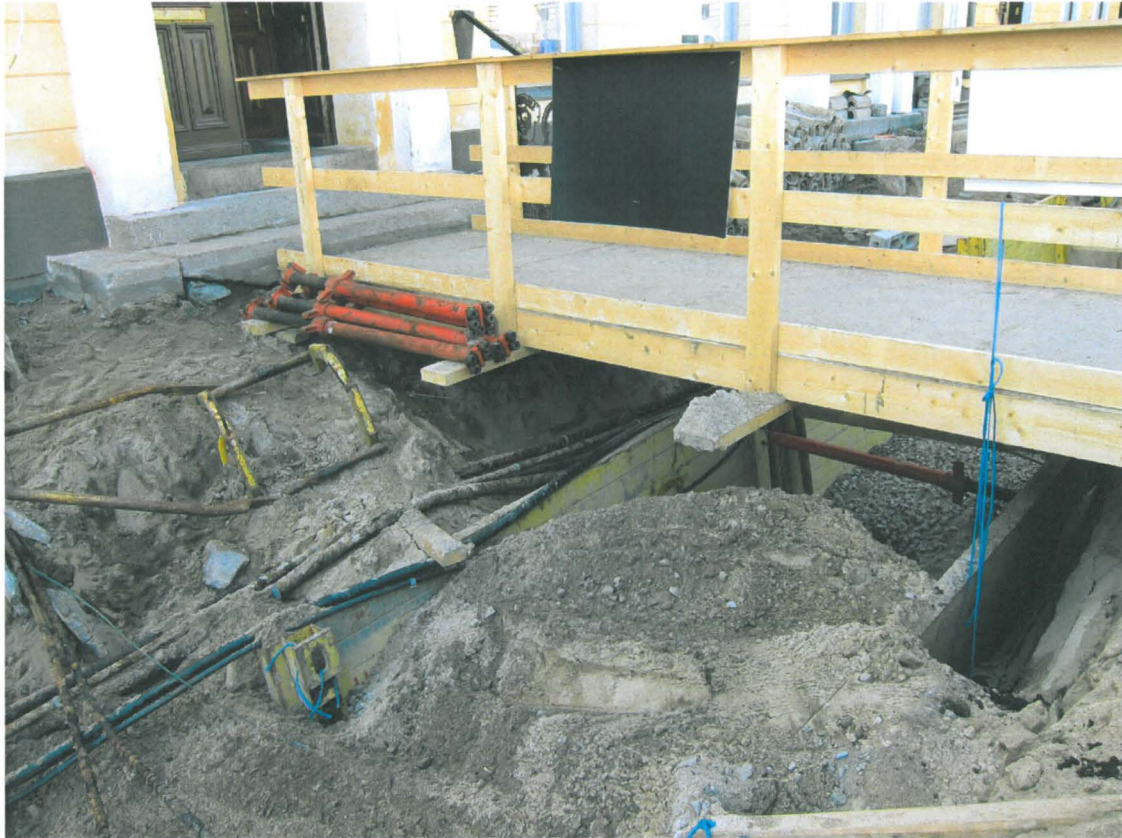
Kuva 215. Aleksanterinkadun jalkakäytävä. Cafe Engelin oven kohdalla kävelysillan alla eteläprofiilissa näkyy puhdas pohjahiekka. Kuvaussuunta SW. 20.5.2011.
