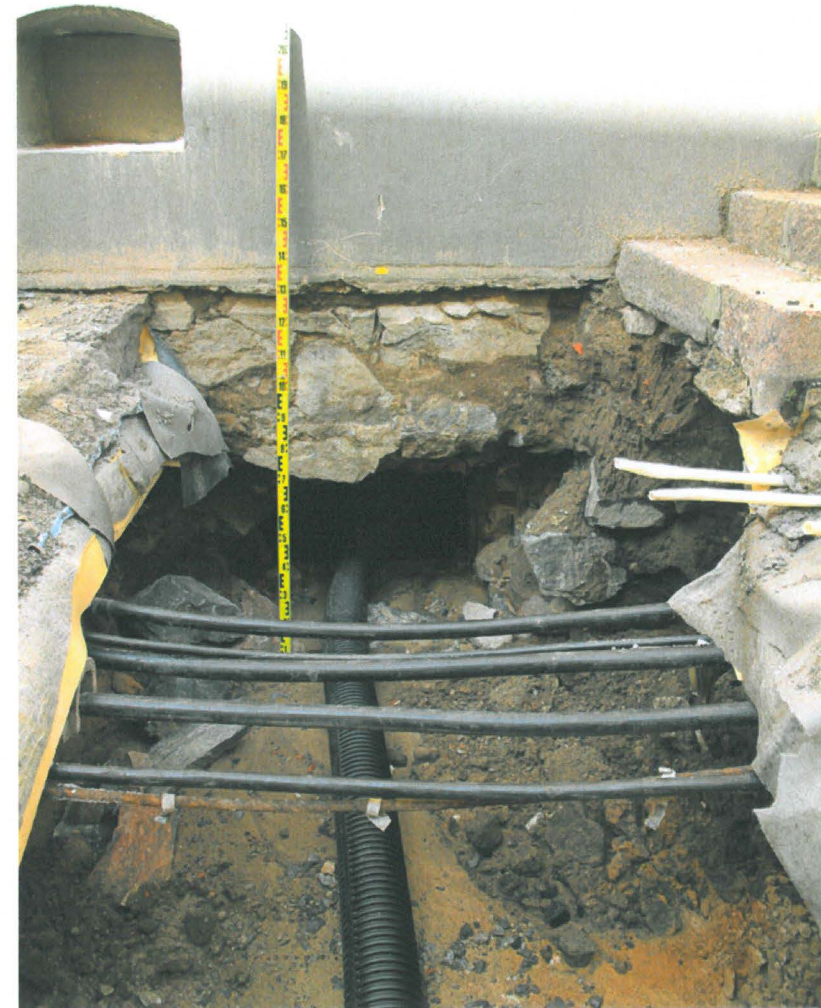
Kuva 202. Sunnin putkikaivanto. Kaivanto meni eteläisimmän portaikon eteläpuolitse Sunnin kellarin S017, jonne tehtiin uusi lämmönjakohuone. Kuvaussuunta W. 9.7.2010.
