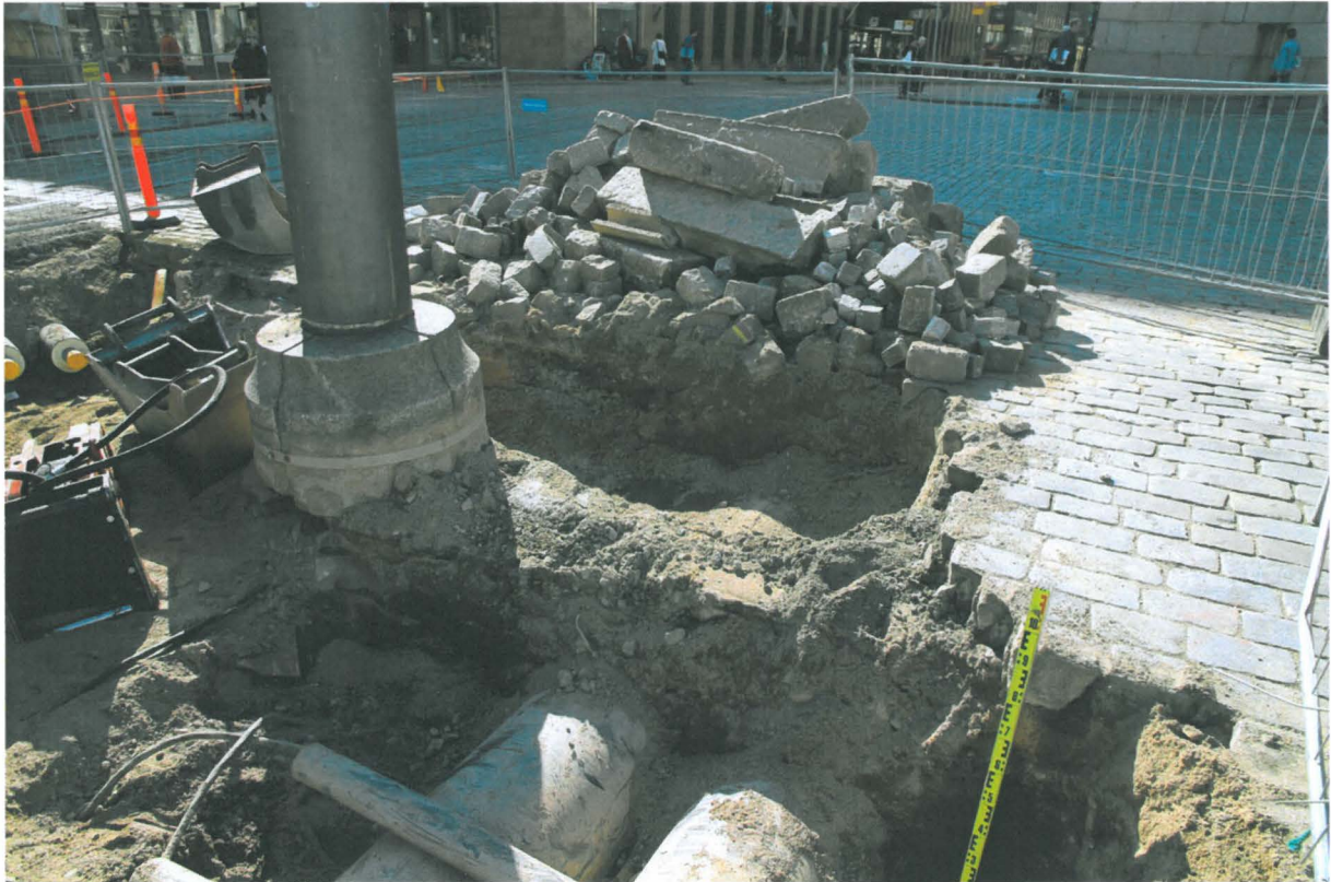
Kuva 169. Kiseleffin putkikaivanto. Kaivannon pohjoispää. Kuvassa näkyy vanhat itä-länsi -suuntaiset kaukolämpöputket. Kuvaussuunta SW. 31.8.2010.
