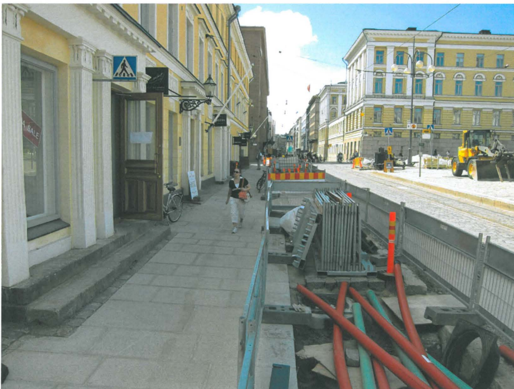
Kuva 226. Aleksanterinkadun jalkakäytävä. Sunnin ja Kiseleffin jalkakäytävän laattakiveys on valmistunut. Kuvaussuunta W. 27.6.2011.
