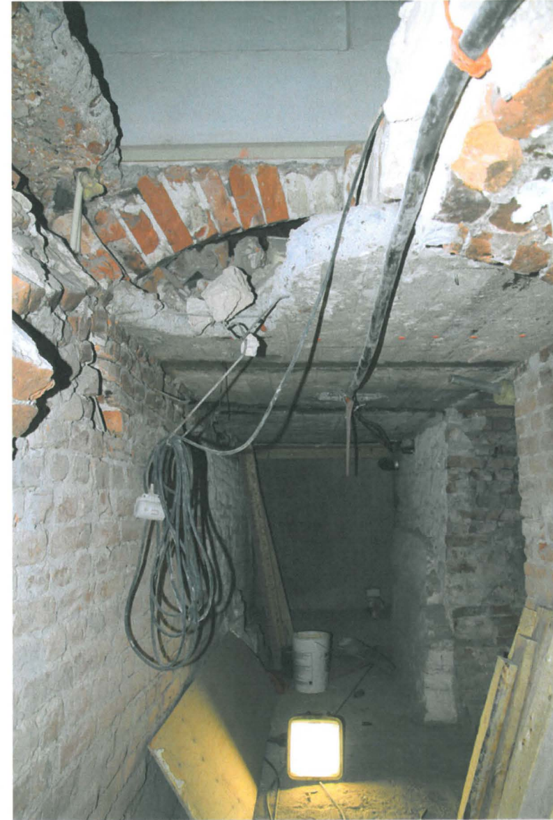
Kuva 61. Sunn S011. Kuva edellisen kohdan rikutusta kohdasta käsin etelään. Holvin alla on "uusi" betonikatto. Taustalla näkyy uuden hissikuilun betoniseinä. Kuvaussuunta S. 8.11.2010.
