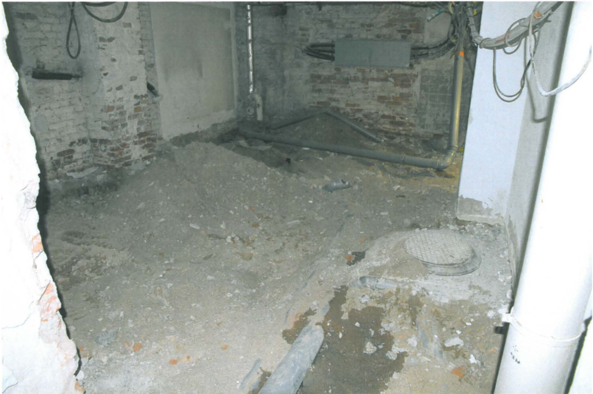
Kuva 118. Kiseleff K016. K016 sijaitsee kuvassa olevan tilan takaosassa. Tilasta on purettu seiniä ja lattia. Kuvaussuunta SWW. 7.4.2010.
