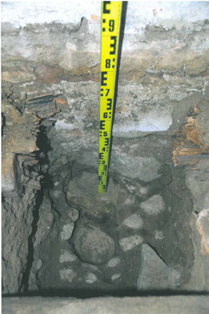
Kuva 90. Sunn S017. Koekuoppa 6. Koekuoppaan kellaritilan länsiseinän viereen on kaivettu koepisto seinän alapinnan toteamiseksi. Kuvaussuunta W. 8.3.2010.
