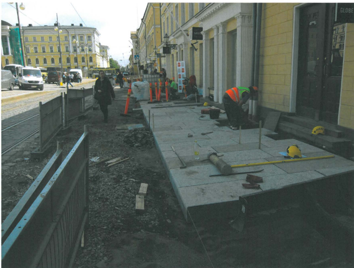
Kuva 225. Aleksanterinkadun jalkakäytävä. Sunnin ja Kiseleffin jalkakäytävälle on asennettu uudet isot laattakivet. Jalkakäytävän levennysosa on vielä tekemättä. Kuvaussuunta E. 20.6.2011.
