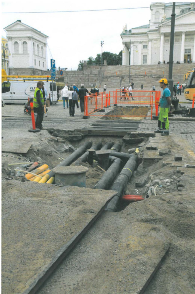
Kuva 198. Sunnin putkikaivanto. Edellinen kohta. Kaivantoa on kaivettu raitiokiskojen alitse ja edelleen pohjoiseen. Kuvaussuunta NNW. 17.8.2010.
