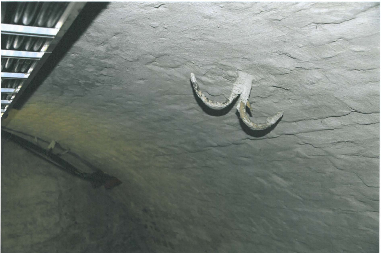
Kuva 8. Kiseleff K061. Kellarin katossa oli rautakoukut vielä paikoillaan. Kuvaussuunta NW. 2.3.2010.
