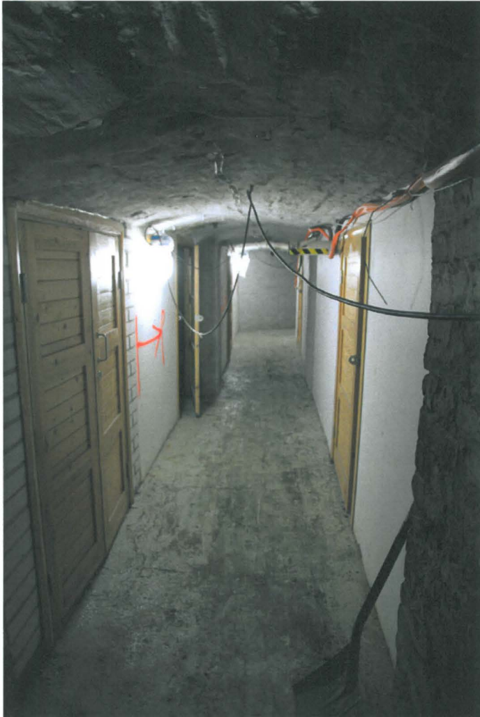
Kuva 19. Sunn S010. Sunnin eteläosan itä-länsisuuntainen kellarikäytävä. Kuvaussuunta W. 25.5.2010.
