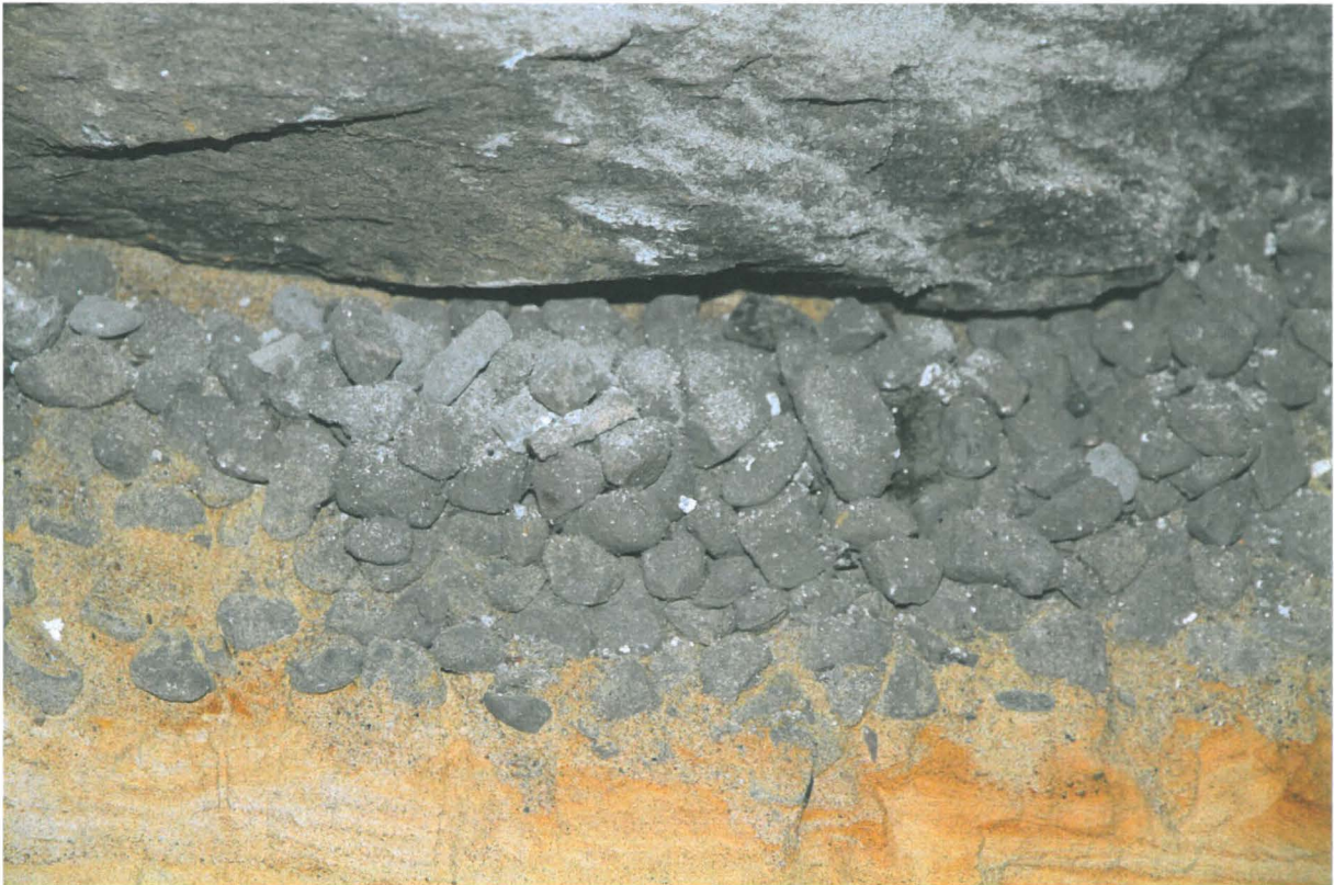
Kuva 106. Kiseleff K057. Lähikuva käytävän itäisen alimman kiven alla olleesta materialista. Kuvaussuunta N. 25.5.2010.
