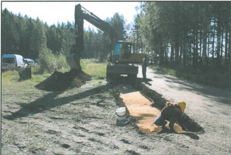
DG1450:563 Surnuintien pohjoispuolen koeojaa avataan kaivinkoneella kuvattu länsiluoteesta kuvaaja Esa Mikkola
