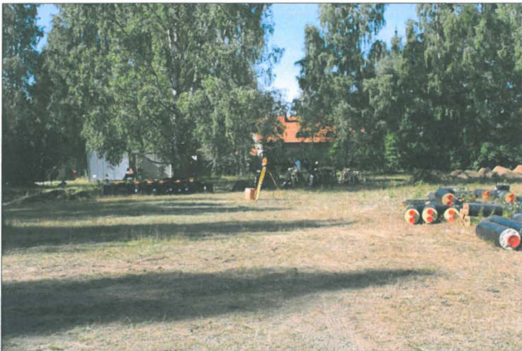
DG1450:5 Yleiskuva koeojan sijainnista Tuukkalan kentän länsireunassa kuvattu idästä kuvaaja Esa Mikkola
