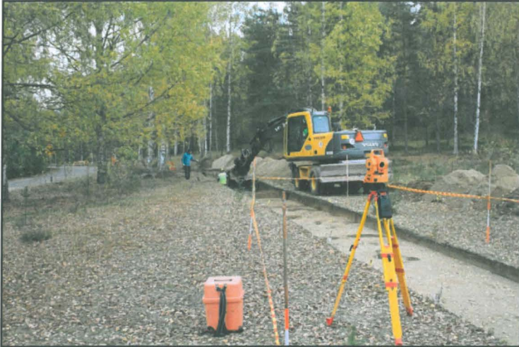
DG1450:561 Etelä-Savon Energian kaukolämpöputkilinjaa syvennetään kuvattu lounaasta kuvaaja Esa Mikkola
