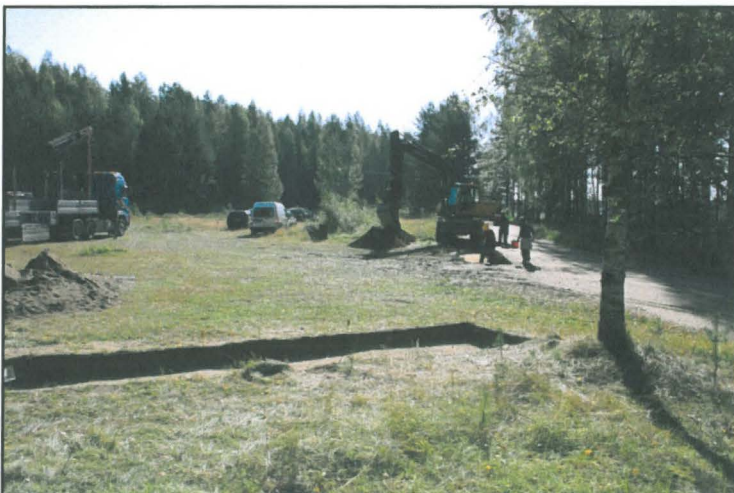
DG1450:564 Surnuintien pohjoispuolen koeojaa avataan kaivinkoneella kuvattu länsiluoteesta kuvaaja Esa Mikkola
