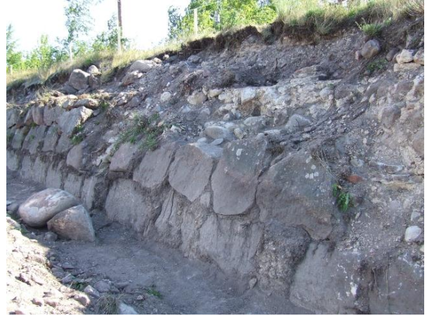
AKDG 3693:12. Profiili A säilyneen tiilirakenteen kohdalla. Tiilirakenne näkyy kuvan oikeassa yläkumassa, kuvattu lounaasta.
