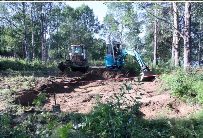
AKDG 3644:116. Aluetta 4 ava- taan koneella. Pohjoisesta. Ku- vaaja: Petro Pesonen.
