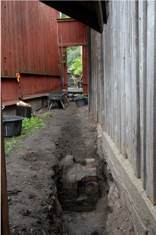
AKDG. 3614:1 Tutkimusalue rakennusten välissä, etualalla tiilirakenne ja oikealla rakennus B2., kuvattu lännestä.
