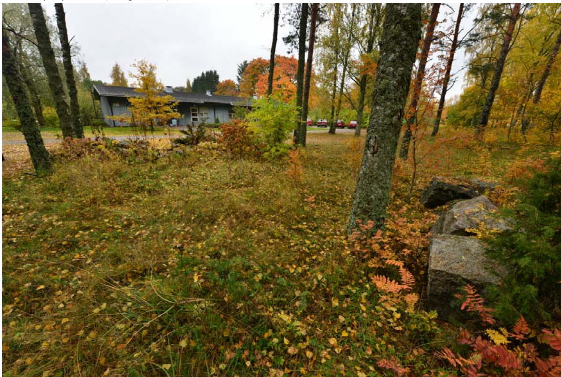
Sandö. Osa kivijalan kivistä on siirretty paikaltaan ja rakennuksen paikalle on tehty kukkapenkki. Kuvattu lounaasta. (AKDG3623:3)
