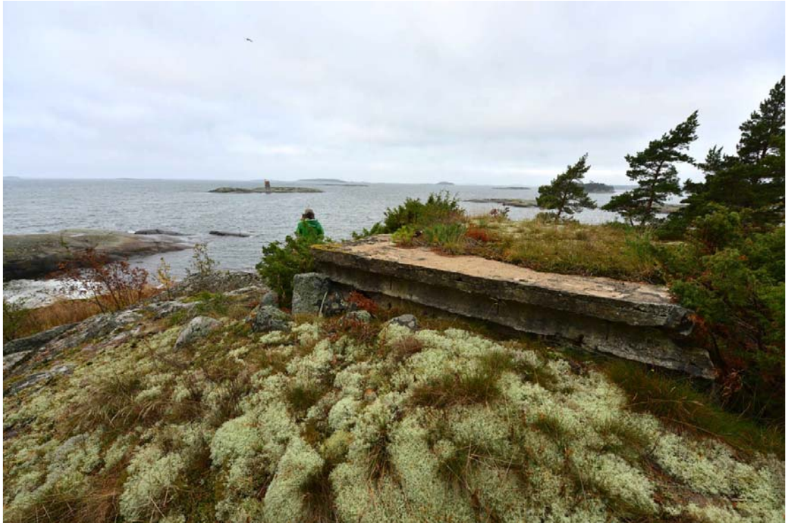
Västertorskaren. Sementillä vahvistettu konekivääriasema rantakallion päällä. Kuvassa Johanna Seppä. Kuvattu koillisesta. (AKDG3635:1)
