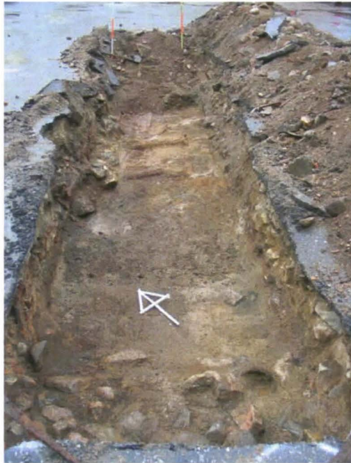
Digitaalinen kuva nro 45. Koeoja D, taso 1, yleiskuva. Etualalla kivi- ja tiilirakenne (DSY11). Kuvattu koilliseen. Kuvaaja: Tiia Ikonen, MV/RHO.
