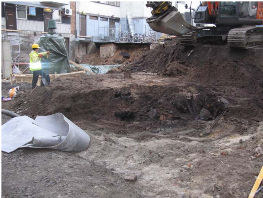
Kuva 9. Digikuva 125979:29 Työkuva. Koeojan 2 päädyn täytön SY 22 ja SY 1 sekoittuneen maan poisto. Suunta 280, kuvaaja T.Tanska. 10.11.2009.
