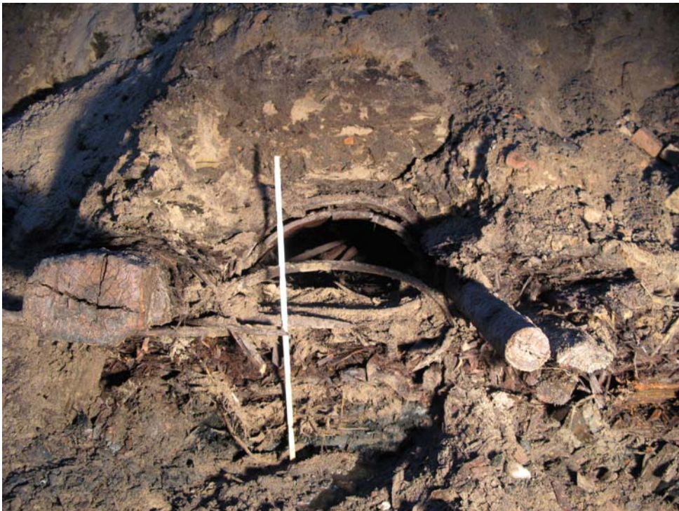
Kuva 18. Digikuva 125979:154. Lähikuva rakenteesta DR1. Suunta n. 300. T. Taipaleenmäki 23.11.2009.
