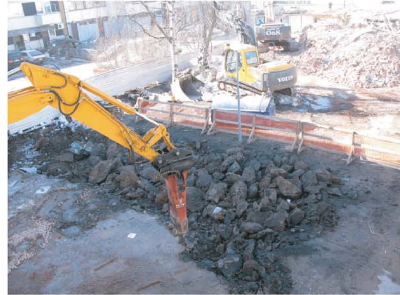
Kuva 15. Kaivausalue B, routaisen pintamaan poistoa. Kuvaussuunta 250°.
