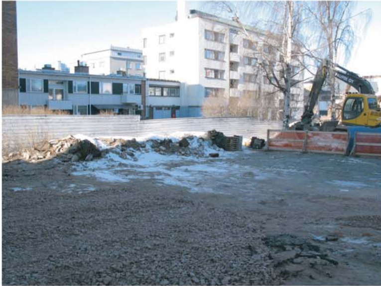
Kuva 7. Kaivausalue B, ennen maanpoistoa, lounaislaita. Kuvaussuunta 260°.
