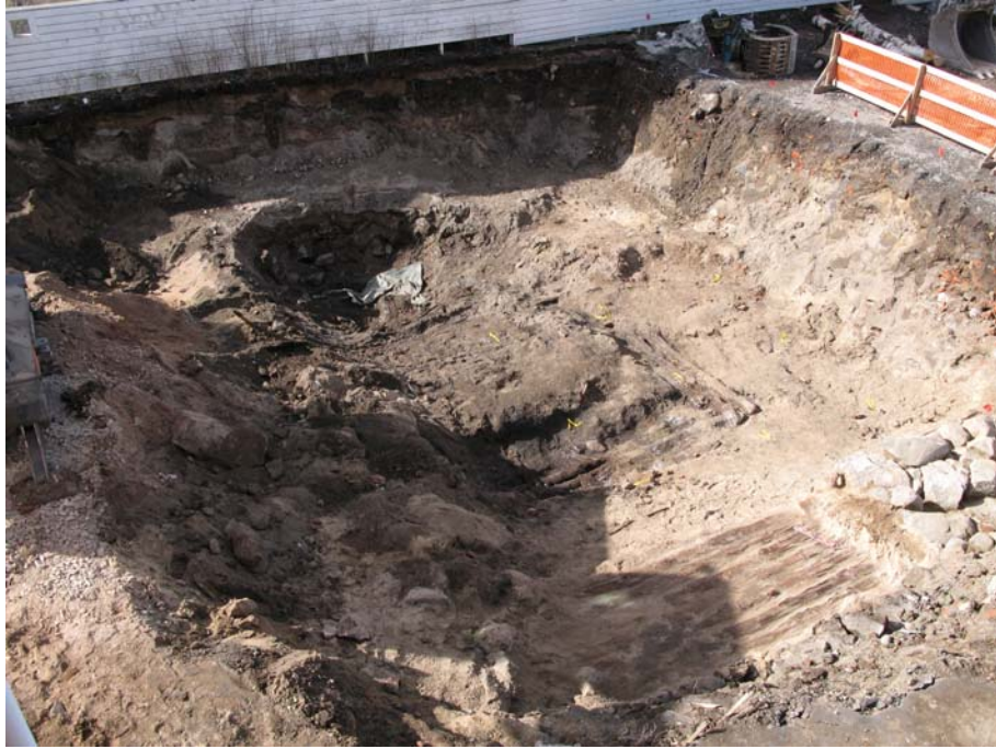
Kuva 7. Kaivausalue B osin puhdistettuna, näkyvissä alaosassa ovat osittain rakenteet kivijalka BPR3 ja puuarina BPR5. Itäosa kaivausalueesta on vielä ilman alustavaa maanpoistoa. Digitaalikuva MV/RHO.
