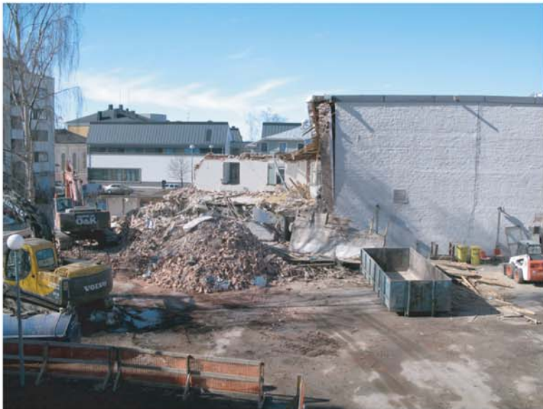
Kuva 17. Tiilirakennuksen purku alueen luoteisrajalla, alue C:n länsipuolella. Kuvaussuunta 270°.
