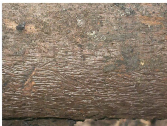
Digitaalinen kuva nro 60. R19, seinämä 4, hirsi nro 23, yks. kohta. – neulasten painaumia puussa. Kuvattu etelään. Kuvaaja: Marika Hyttinen, MV/RHO.
