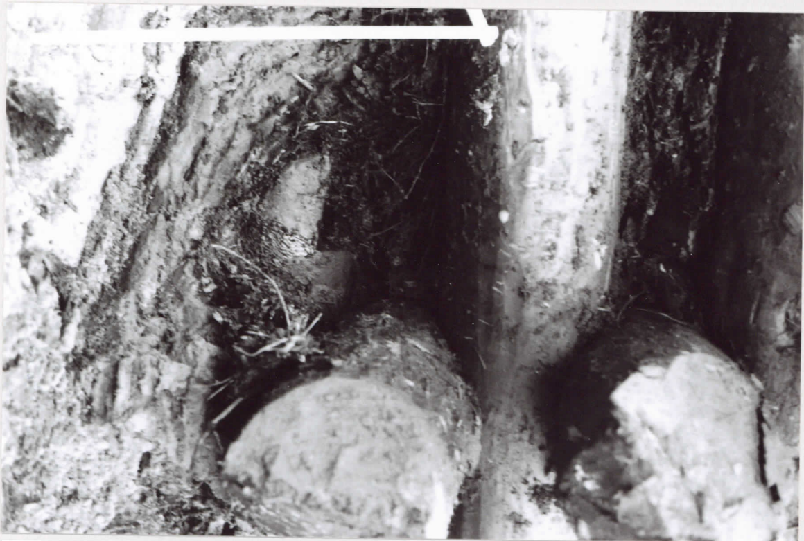
125746:69 20 Oulu Virastotalo R19, yksityiskohta länsireunalta, veistetty hirren pää
