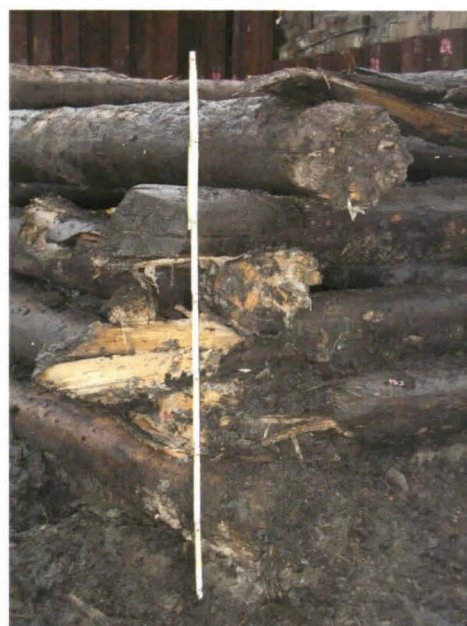
Digitaalinen kuva nro 71. R19, seinämä 2, nurkka e – rikkonaiset hirsien päät (kuvassa 1,4 m mitta). Kuvattu luoteeseen. Kuvaaja: Terhi Taipaleenmäki, MV/RHO.
