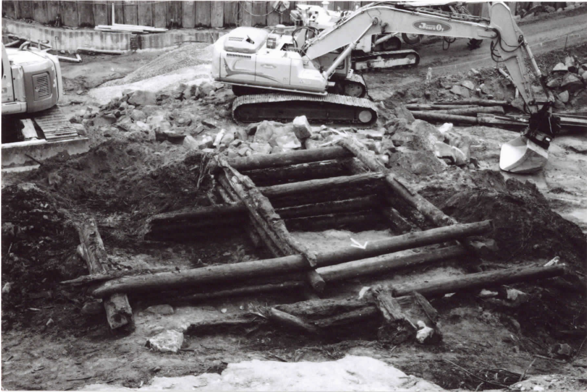
ID 125746 : 25 R19, YLEISKUVA + TYÖMAA, T. TAIPALEENMÄKI
