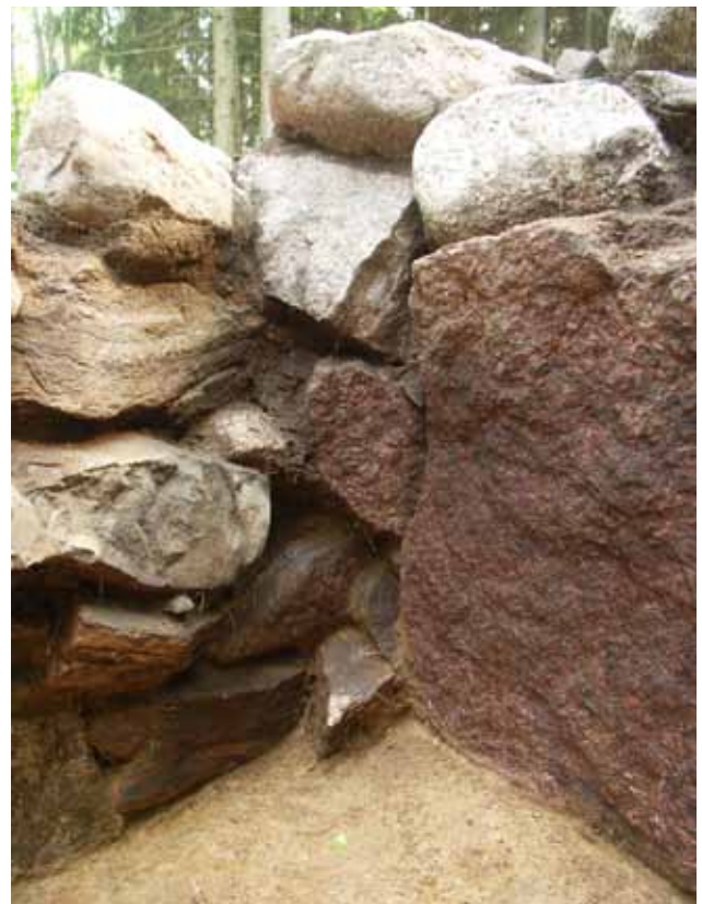
167. Alue 17. R17-67, R17-69. Rakennuksen 25 kaakkoiskulma. 27.6.2013. A-MS.
