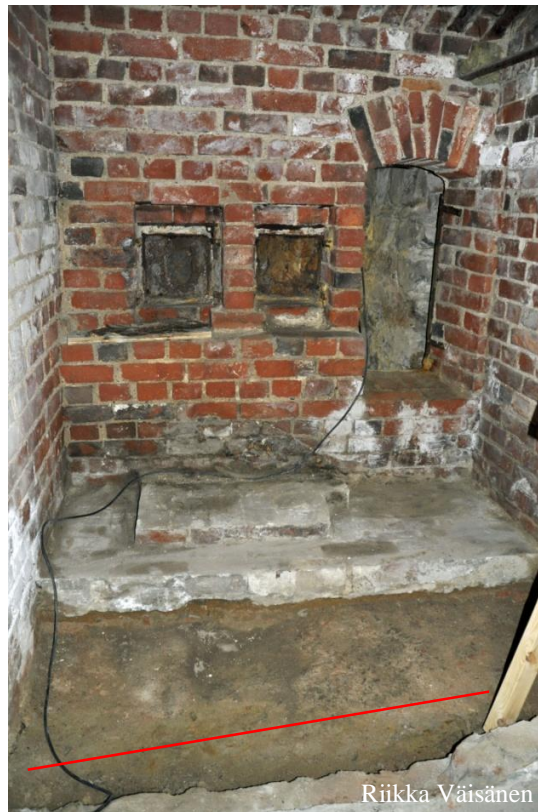
Kuva 10. Kuvan etualalla puretun seinän alta esille tullut alue, josta tutkimusten aikana kaivettiin ohut purkukerros. Tämän alta esille tuli kuvassa oleva kova laastikerros, jonka etureunassa on kapea ja noin 15 cm syvä oja (merkitty punaisella viivalla). Taustalla erottuu tiilinen väliseinä oviaukkoineen, jonka takana tutkittu huonetila sijaitsi. Kuva otettu länteen.
