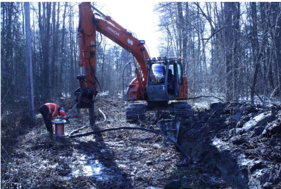
AKDG 3701:4. Kuparimaakaapelia asennetaan, pohjoisesta. Kuvaaja: Petro Pesonen.
