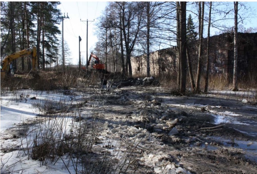
AKDG 3701:20. Bastionin edessä tehty kaivanto mahdolliseen vallihautaan täytettynä, pohjoisesta. Kuvaaja: Petro Pesonen.
