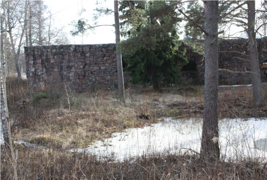
AKDG 3701:12. Bastioni Rosen mahdollisen vallihaudan takana, pohjoisesta. Kuvaaja: Petro Pesonen.
