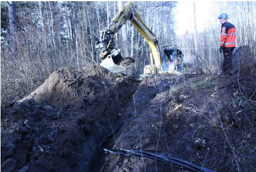
AKDG 3701:10. Vallin rintasuojan kaivantoa täytetään, etelästä. Kuvaaja: Petro Pesonen.
