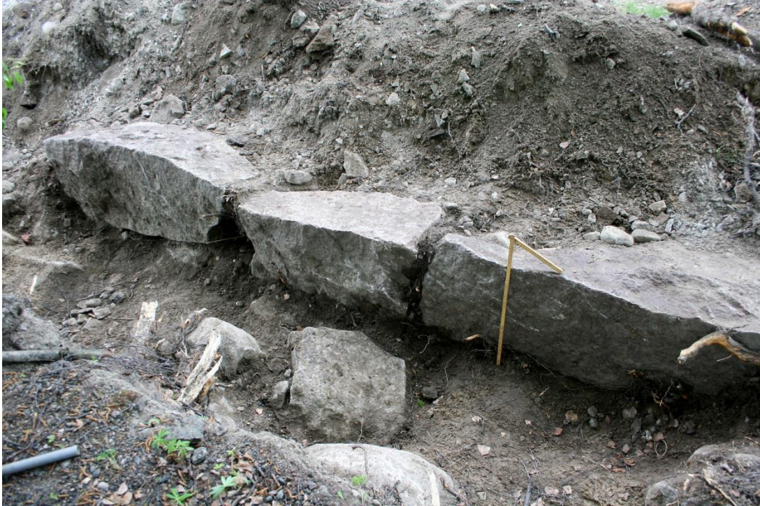
Kuva 13. Koeojan 1 luoteispään perustuskiveystä kuvattuna pohjoiseen. Kuva: Satu Koivisto/ARKE (AKDG 3726:25).
