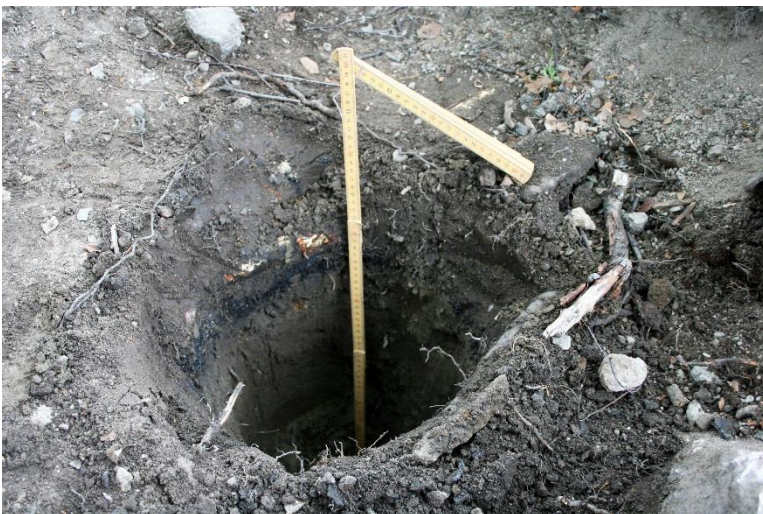
Kuva 12. Koeajan 2 keskiosaan kaivettu tarkastuskuoppa ulottui noin 45 cm syvyyteen dokumentointitasosta. Kuopan seinämässä erottui musta kreosoottikerros; myrkyllinen ja karsinogeenipitoinen eristekerros, joka liittyy tontin teollisuuskäyttöön. Kuva: Satu Koivisto/ARKE (AKDG 3726:34).
