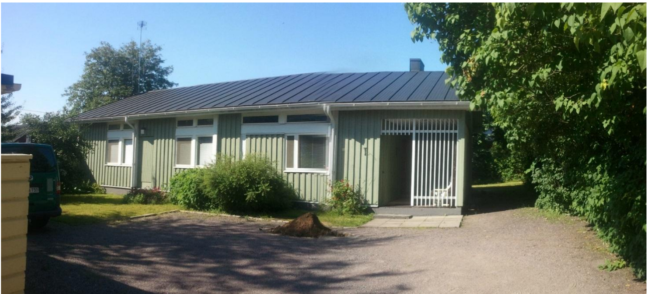
AKDG. 3709:2 Tutkimusalue, Kirkkokatu 10:n pihamaa. Lounaaseen.
