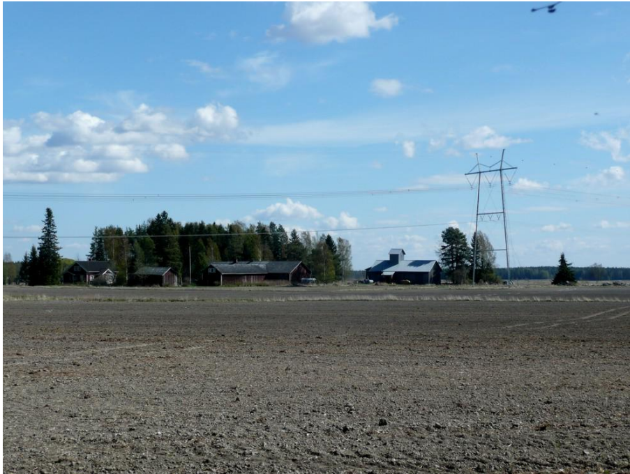
Kuva 35. Voimajohtolinjaus Saarelan eteläpuolella itäkaakkoon.
