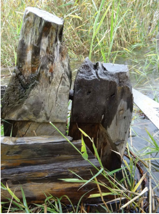
Kuva 9. Rangan pää ennen näytteenottoa.
