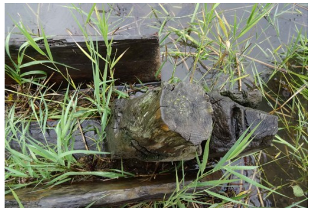
Kuva 2. Kylkilankun pää näytteenoton jälkeen.
