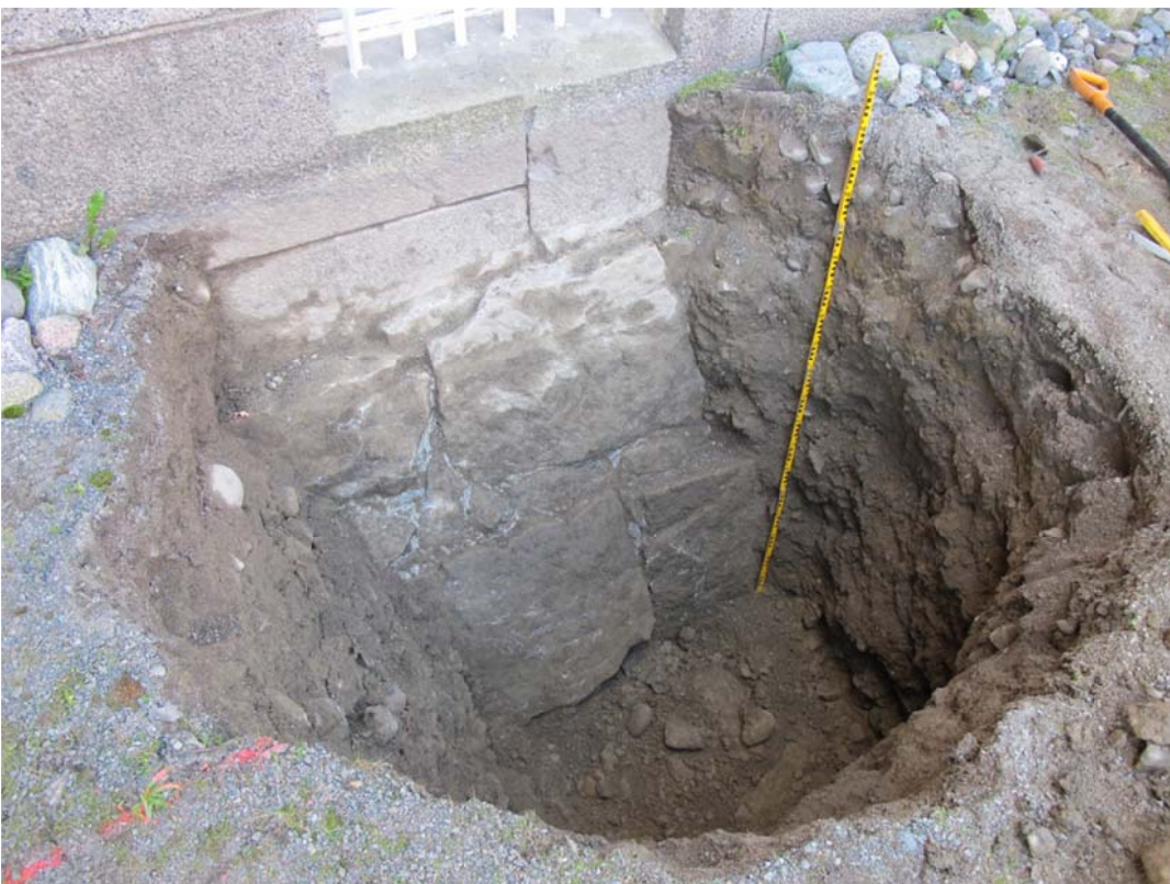
Koillisseinän kiviperustusta paljastettiin 1,35 metriä. AKDG3922:12–13, Janne Hymylä, Museovirasto.
