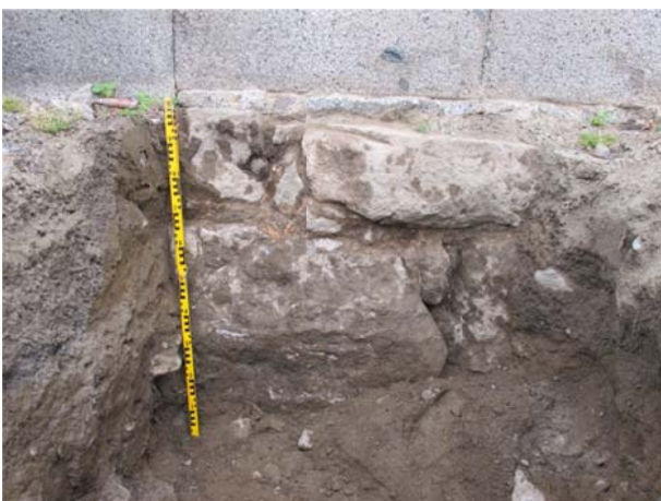
Kiviperustuksen ensimmäisen ja toisen kivikerran välinen saumalaasti on värjäytynyt punaiseksi laastin sisältämän tiilimurskan vuoksi. AKDG3922:4, Päivi Hakanpää, Museovirasto.
