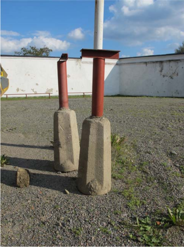
Vankilamuseon kaakkoispään puupenkien betoniperustukset ja metallijalustat. AKDG3922:7 Janne Hymylä, Museovirasto.
