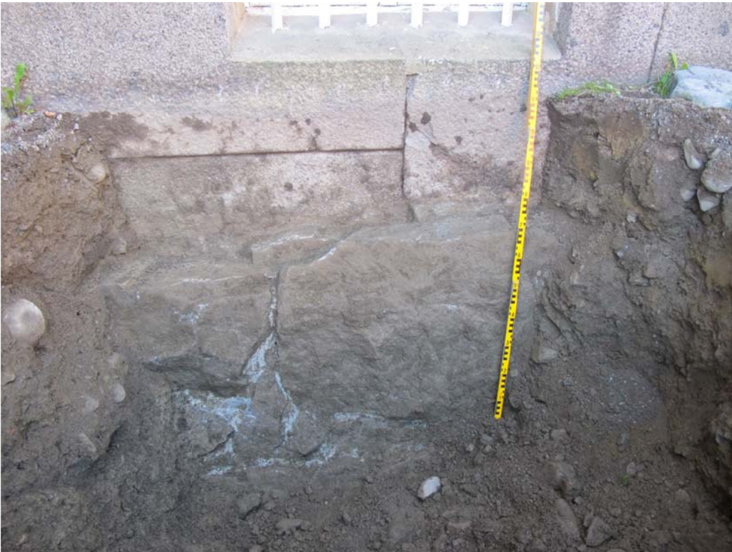
Vankilamuseon koillisseinän kiviperustuksen päälle oli kertynyt lähes puoli metriä maata. AKDG3922:12, Päivi Hakanpää, Museovirasto
