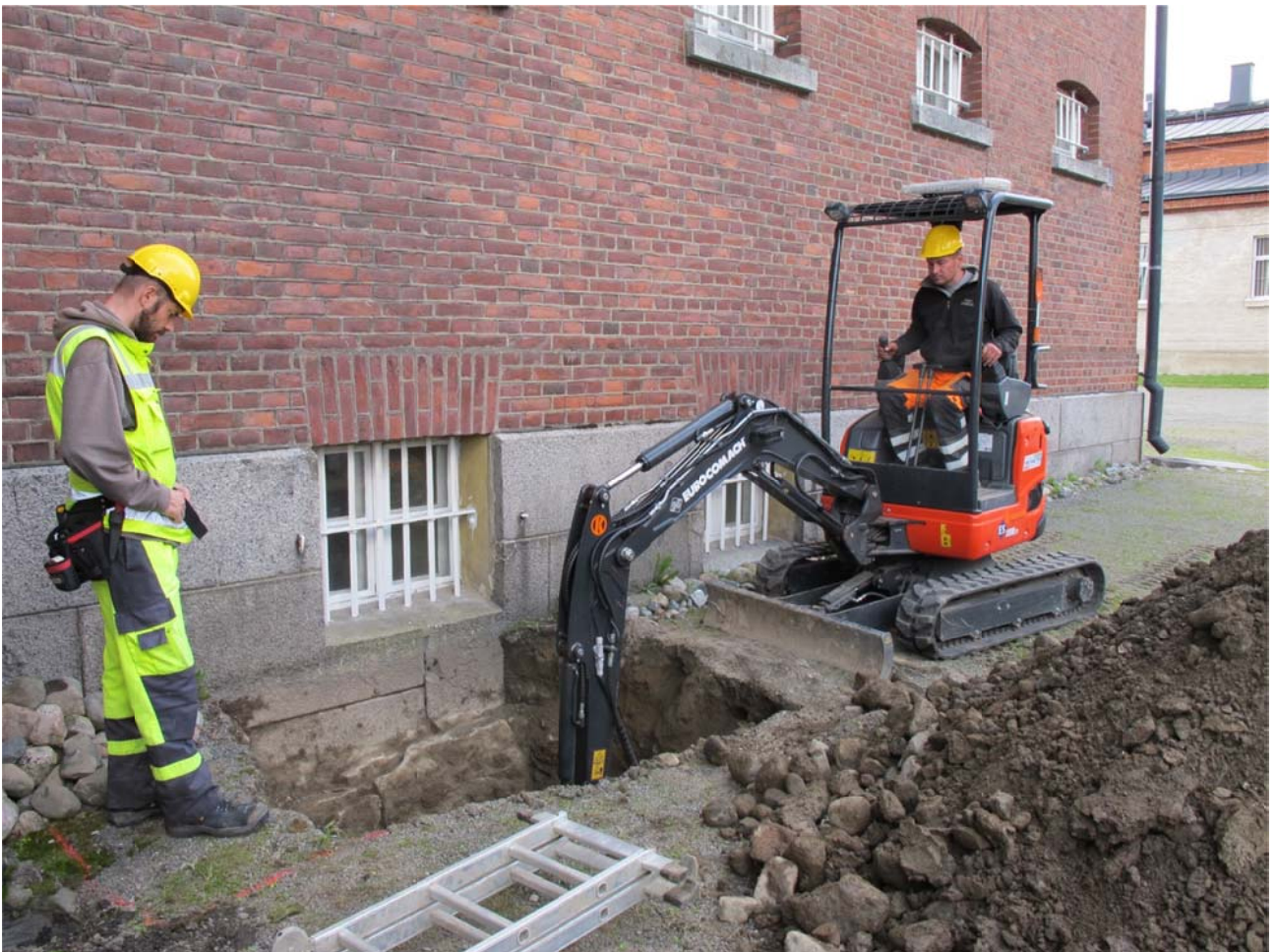
Koekuoppaa n:o 2 kaivamassa Jari Kaseva ja kaivamista valvomassa Janne Hymylä. AKDG3922:1, Päivi Hakanpää, Museovirasto.
