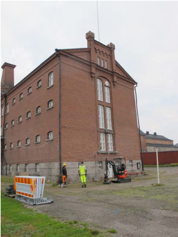
Vankilamuseon kaakkoispääty ennen koekuopan kaivamista. AKDG3922:2, Päivi Hakanpää, Museovirasto.
