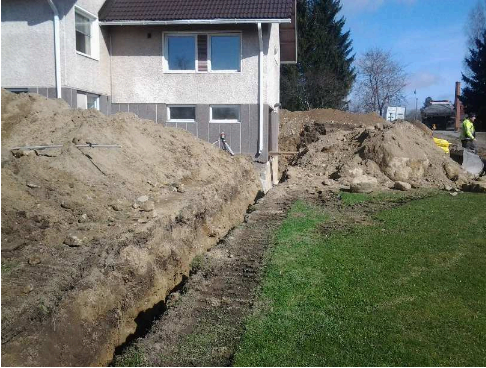
Kuva 4. Valmis kaivanto kuvattu kaakosta. AKDG 4241:4
