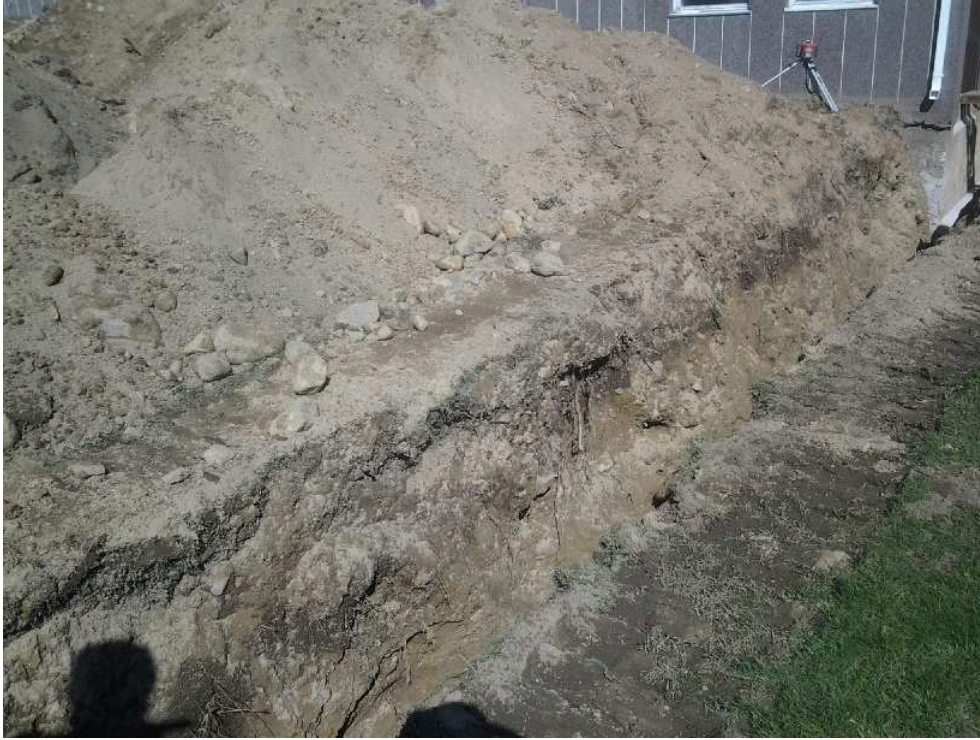
Kuva 6. Putkikaivantoa kuvattu kaakosta. AKDG 4241:6
