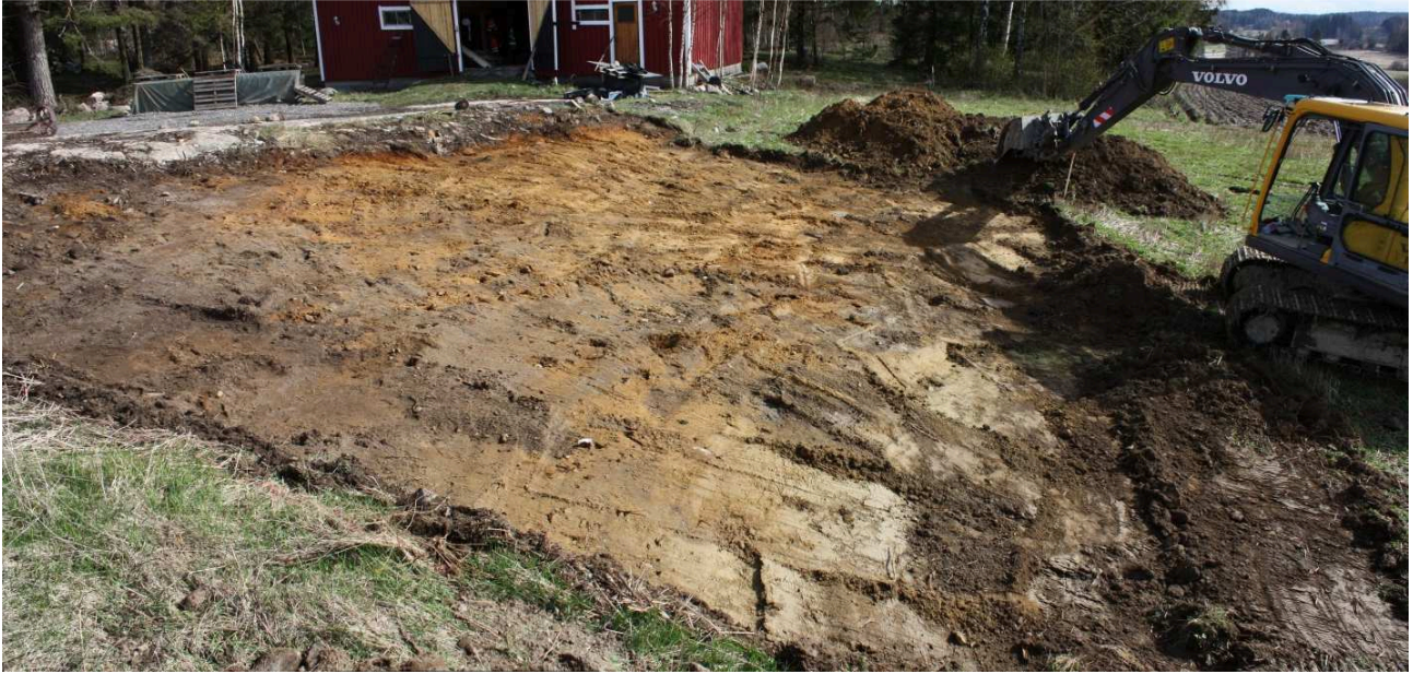
Kuva 9. Rakennuspaikka pintamaan poiston jälkeen, kuvattu lounaasta. AKDG 4254:8
