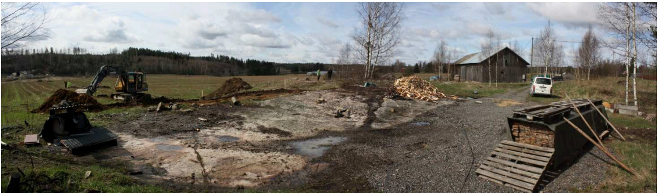
Kuva 4. Näkymä kohti tulevaa rakennuspaikkaa, kuvattu koillisesta. AKDG 4254:4
