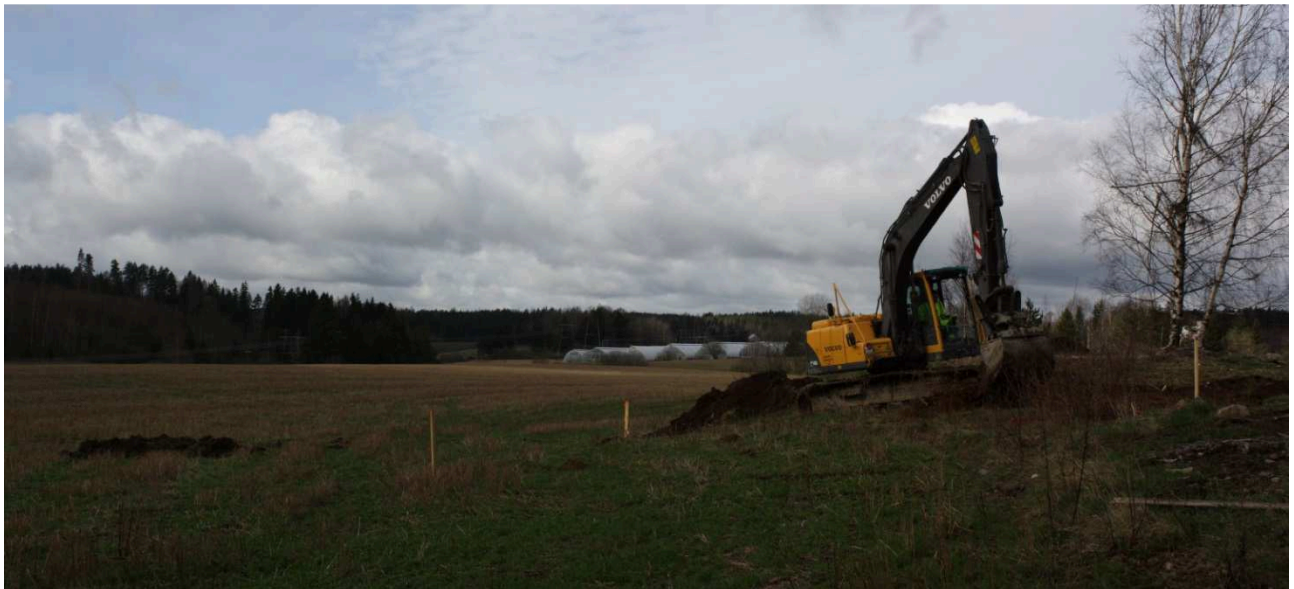
Kuva 7. Kaivinkone poistamassa pintamaat tulevan asuinrakennuksen kohdalla, kuvattu koillisesta. AKDG 4254:6
