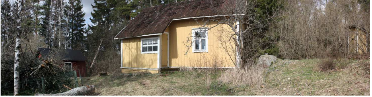
Kuva 3. Tutkimusalueella oleva pihapiiri ja purettava vanha asuinrakennus ja vaja. Kuvattu etelästä. AKDG 4267:3
