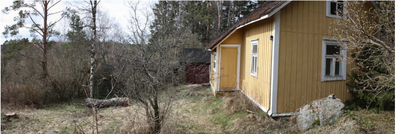
Kuva 4. Tutkimusalueella oleva pihapiiri ja purettava vanha asuinrakennus, sauna ja vaja. Kuvattu itäkaakosta. AKDG 4267:4
