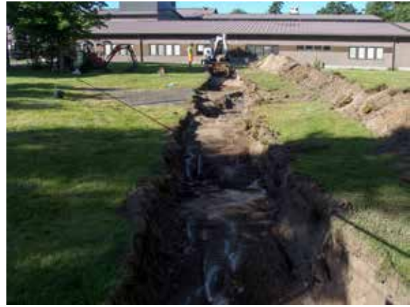
Alueen 1 ensimmäistä koeojaa kaivetaan. Kalliopaljastuma ja louhittu alue näkyvät kuvan keskellä.
