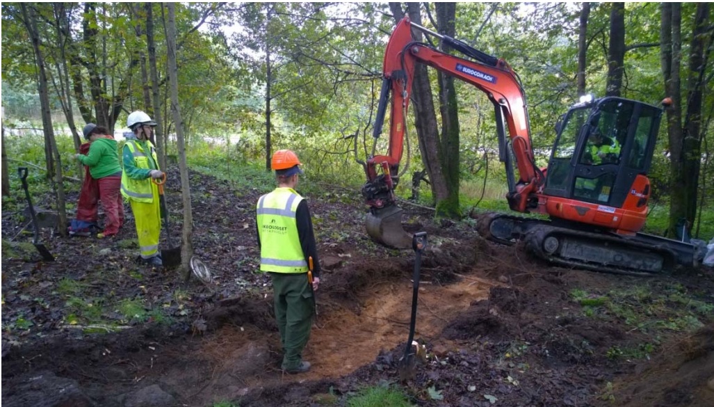
AKDG 4340:13. Koeojaa 1 kaivetaan, itään. Kuvaaja: P. Pesonen.
