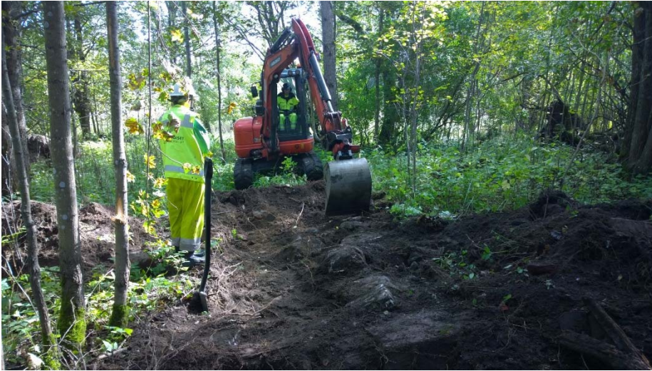
AKDG 4340:35. Koeoja 5 kaivetaan, kaakkoon. Ku- vaaja: P. Pesonen.
