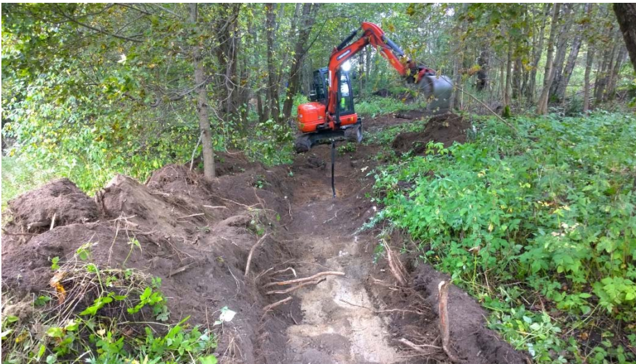
AKDG 4340:76. Koeojaa 12 kaivetaan, luoteeseen. Kuvaaja: P. Pesonen.
