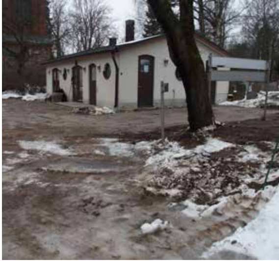
Putkikaivannon pohjoisosasta oli havaittu muutamia suuria kiviä kuvan keskellä olevan sosiaalirakennuksen kulman edestä. Kuvattu idästä.
