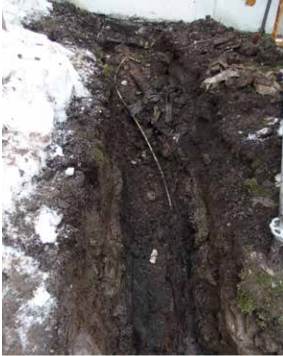
Vanhat vesiputket nousivat ojan suuntaisesti kohti sakastia. Kuvattu koillisesta.
