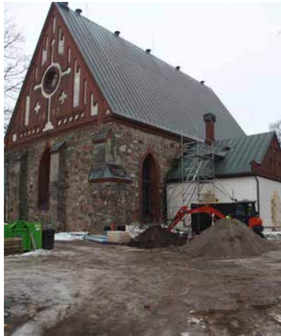
Putkikaivanto sijaitsi 1820-luvulla rakennetun sakastin itäpuolella. Kaivannon pääty on kuvassa näkyvän rakennustelineen takana, sakastin seinän vieressä. Kuvattu koillisesta.
