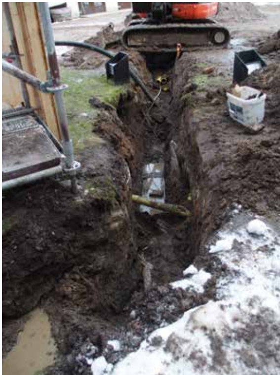
Kaivannon pohjoisosassa risteili runsaasti erilaisia kaapeleita ja putkia. Kuvattu lounaasta.
