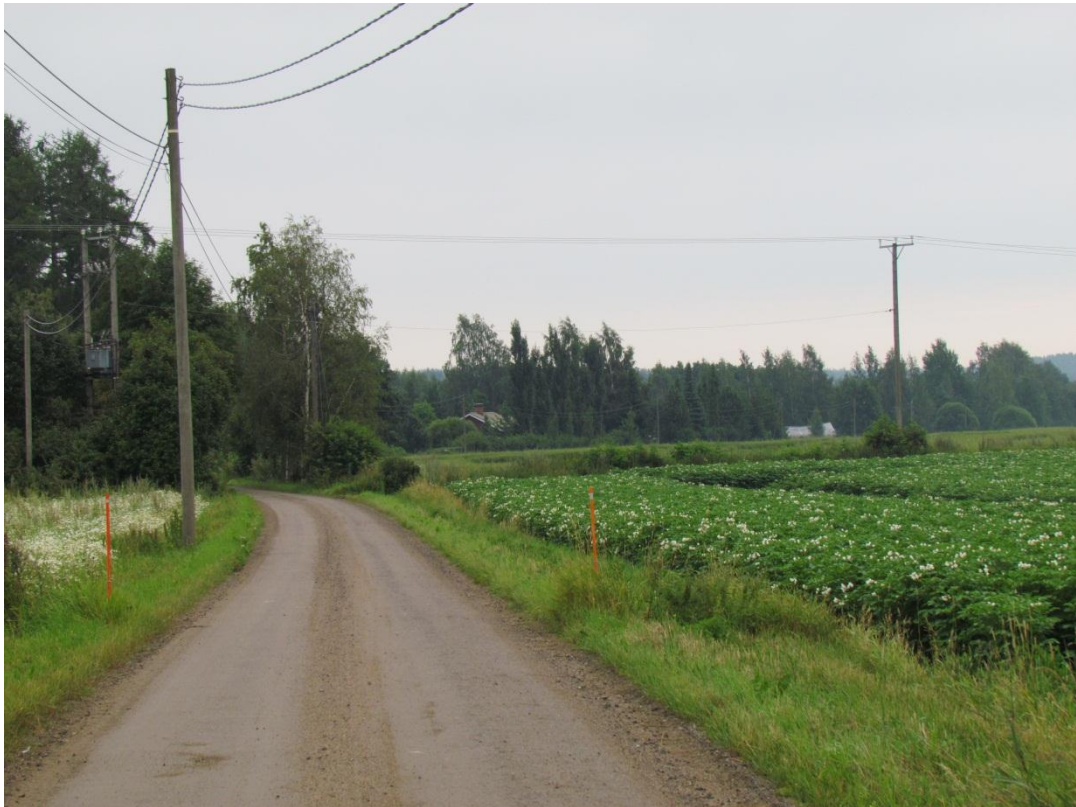
kuva 3. Valvottu maakaapelilinja kulki muuntamonpaikalta tie yli sähkölinjan ilmajohtoa seuraille. Kuvattu luoteesta. (Pälkäne Tiililä, maakaapelointityön arkeologinen valvonta 2012:2)
