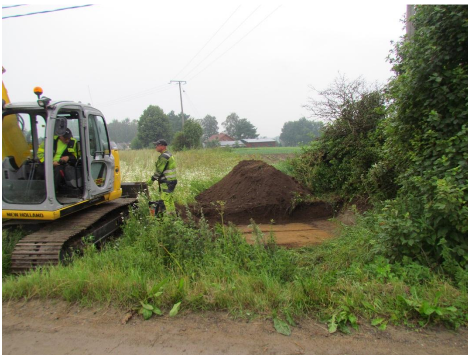
kuva 5. Muuntamonpaikka loppusyvyydessään. Kuvattu etelästä. (Pälkäne Tiililä, maakaapelointityön arkeologinen valvonta 2012:4)
