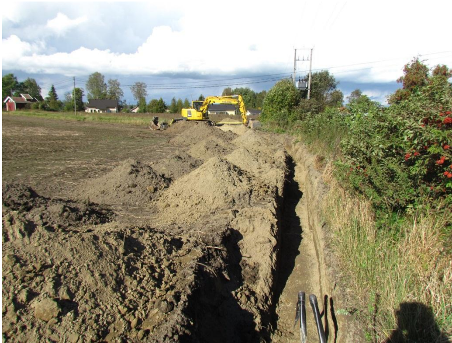
kuva 4. Valvotun kaapelikaivannon eteläpää. Kuvan etualalla näkyvät valvontaa vaatineen alueen rajalle jo aiemmin vedettyjen maakaapeleita suojaavien putkien päät. Kuvattu eteläkaakosta. (Pälkäne Tiililä, maakaapelointityön arkeologinen valvonta 2012:3)
