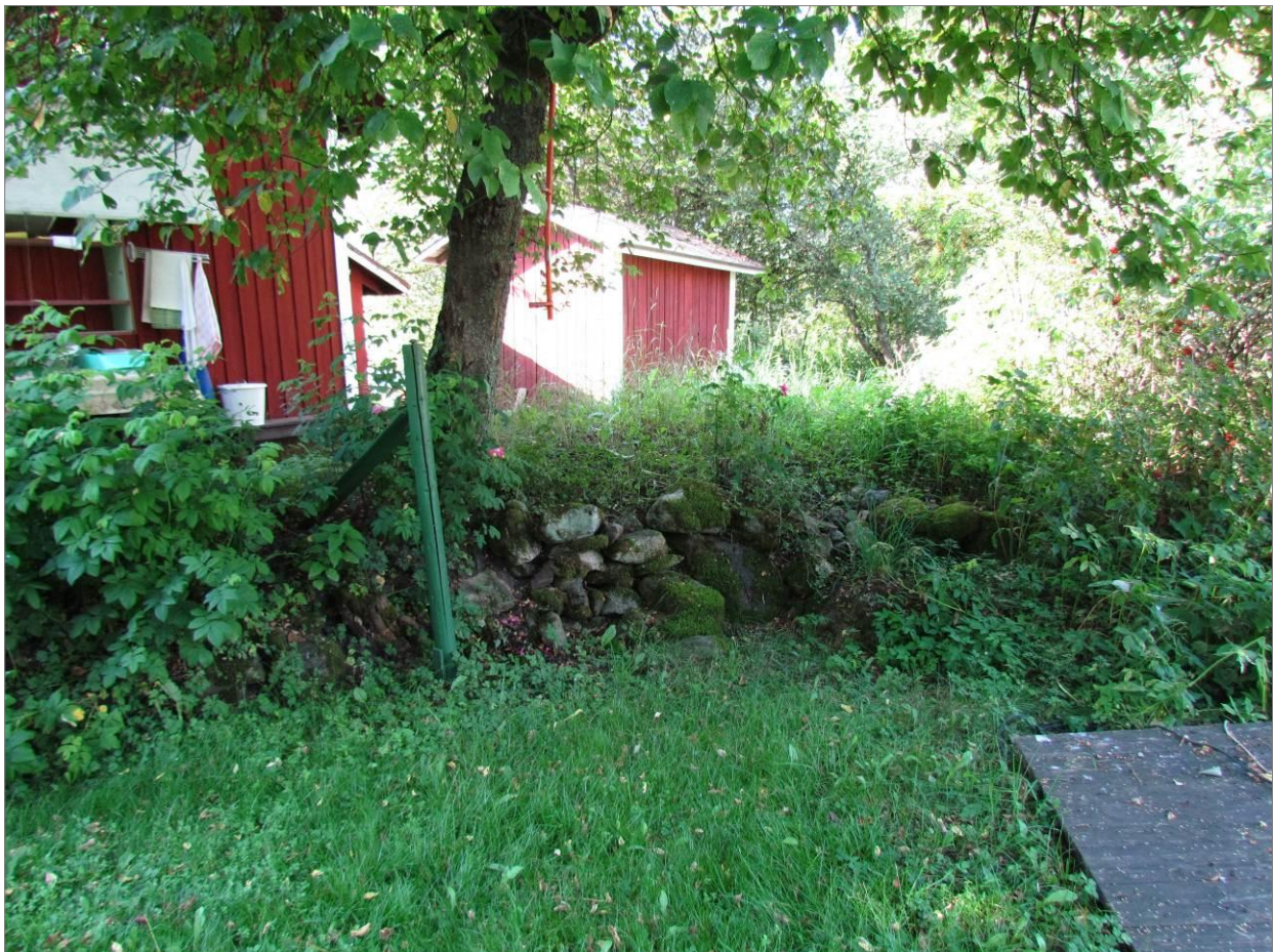
Kuva 22. Piukun kivilatomus kuvattuna luoteesta. (Kuva: Sastamalan Jokipohjantien ja Vatajantien maakaapelointityön suunnittelualueen arkeologinen inventointi 2012: 11) 20
