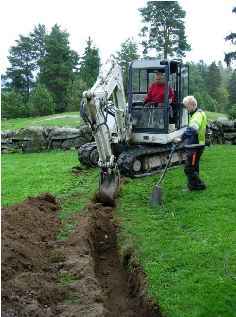
kuva 2. Kaivinkone kaivoi leveydeltään 40 cm olevan kaapelikaivannon noin 40 cm syvyyteen. Kuvassa vanha, kaivannossa ollut kaapeli maassa oikealla. Vanha kaapeli nostettiin kaivu-uomasta sitä mukaa, kun se tuli esille. Kuvattu lännestä. (Sastamala Tyrvään vanha kirkko arkeologinen valvonta 2012:2)
