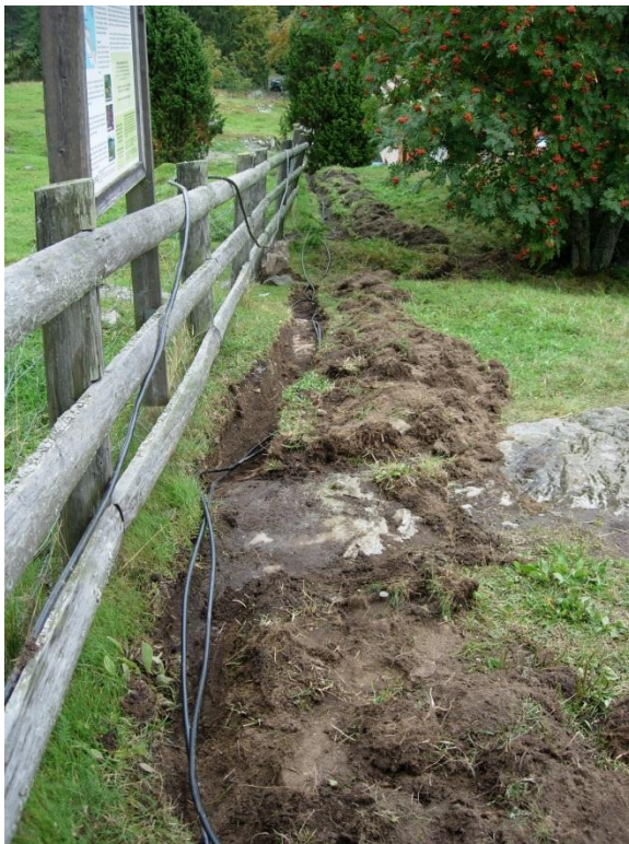
kuva 12. Kuvassa vanha kaapeli aidalla ja uudet kaapelit (2 kpl) valmiissa kaivannossa. Kaapeliuran vieressä kasoissa turvetta ja kaivettua maata. Kuvattu länsiluoteesta. (Sastamala Tyrvään vanha kirkko arkeologinen valvonta 2012:12)
