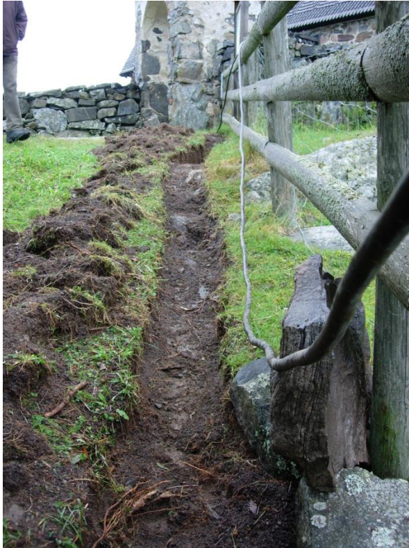
kuva 11. Kirkkotarhan ulkopuolella kaapelikaivanto kulki niin ikään olemassa olevassa kaapelikaivannossa. Kuvassa vanha kaapeli nostettuna kaivannosta ja ripustettuna aidalle. Kuvattu itäkaakosta. (Sastamala Tyrvään vanha kirkko arkeologinen valvonta 2012:11)
