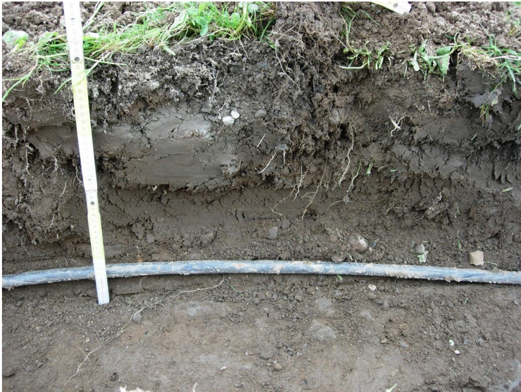
kuva 7. Tyypillinen maannos kirkkotarhan alueen kaapelikaivannon profiilissa: seitsemän senttimetriä paksun turvekerroksen alla oli maannos sekaantunutta hiekkaa aina uuden kaapelikaivannon pohjasyvyyteen (40 cm maanpinnasta) saakka. Kuvassa vanha kaapeli kaivetun uran pohjalla. (Sastamala Tyrvään vanha kirkko arkeologinen valvonta 2012:7)
