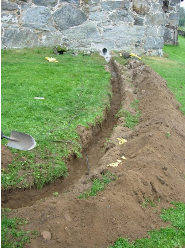
kuva 4. Kaapelikaivannon alkupäätä kirkon itäpuolella. Kuvattu idästä. (Sastamala Tyrvään vanha kirkko arkeologinen valvonta 2012:4)
