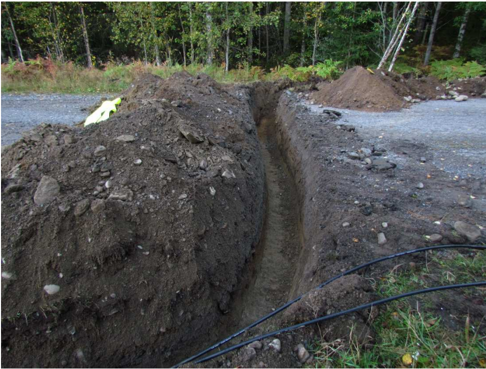
kuva 8. Tien ylittävä kaapelikaivanto linjanosa B:llä. Kuvattu idästä. (Tampere, Lintukalliontien arkeologinen valvonta 2012:4)
