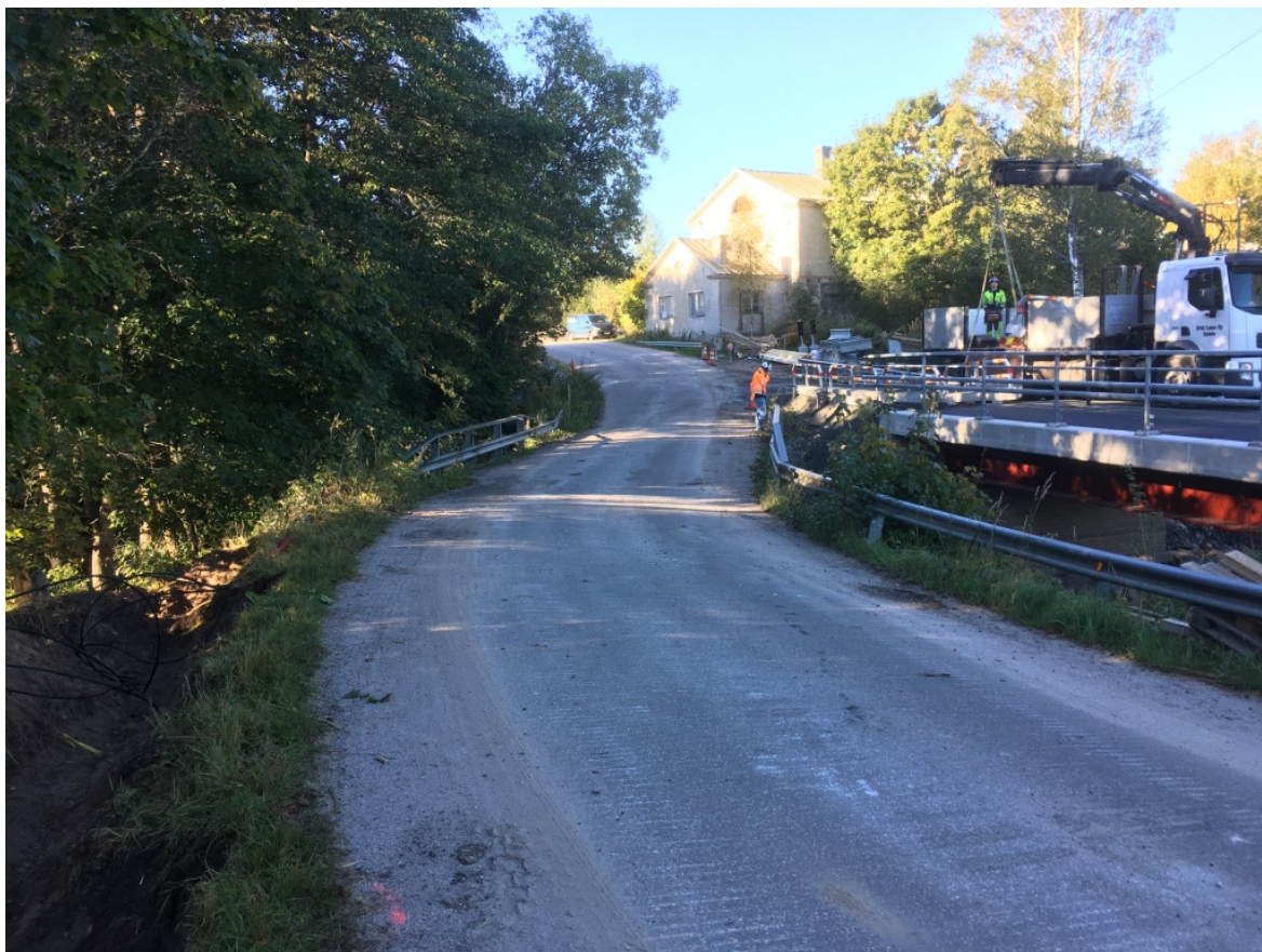
IMG_4525.JPG. Vanha ja uusi silta 13.9.2016. Pohjoisesta.
