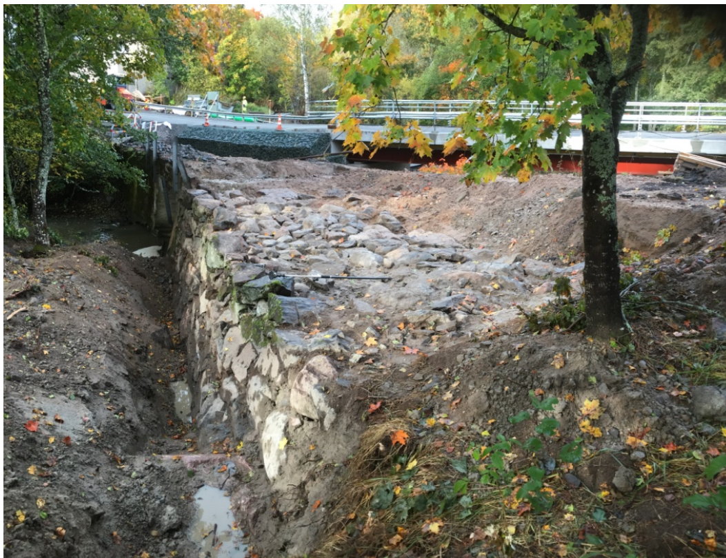
IMG_4777.JPG. Pohjoisrannan patomuuri kokonaan paljastettuna. Koillisesta. 29.9.2016.
