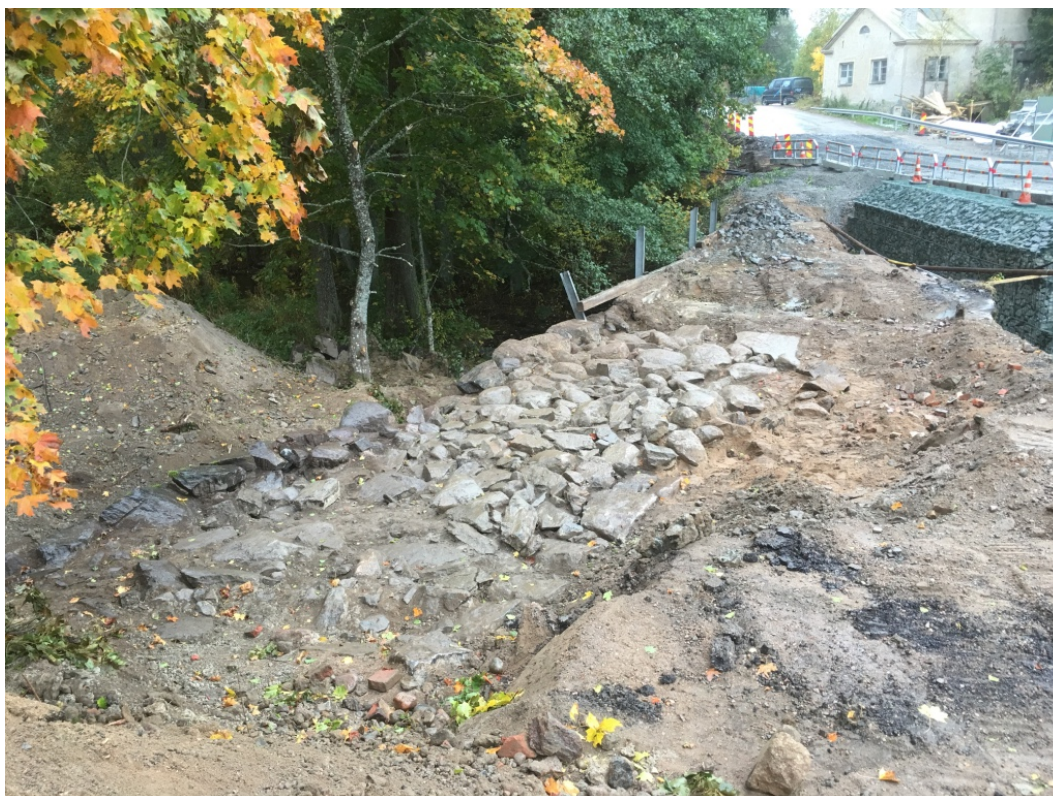
IMG_4765.JPG. Pohjoisrannan patomuuri kokonaan paljastettuna. Pohjoisesta. 28.9.2016.
