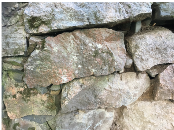
IMG_4651.JPG. Porausjälkiä kivissä. Kaakosta.
