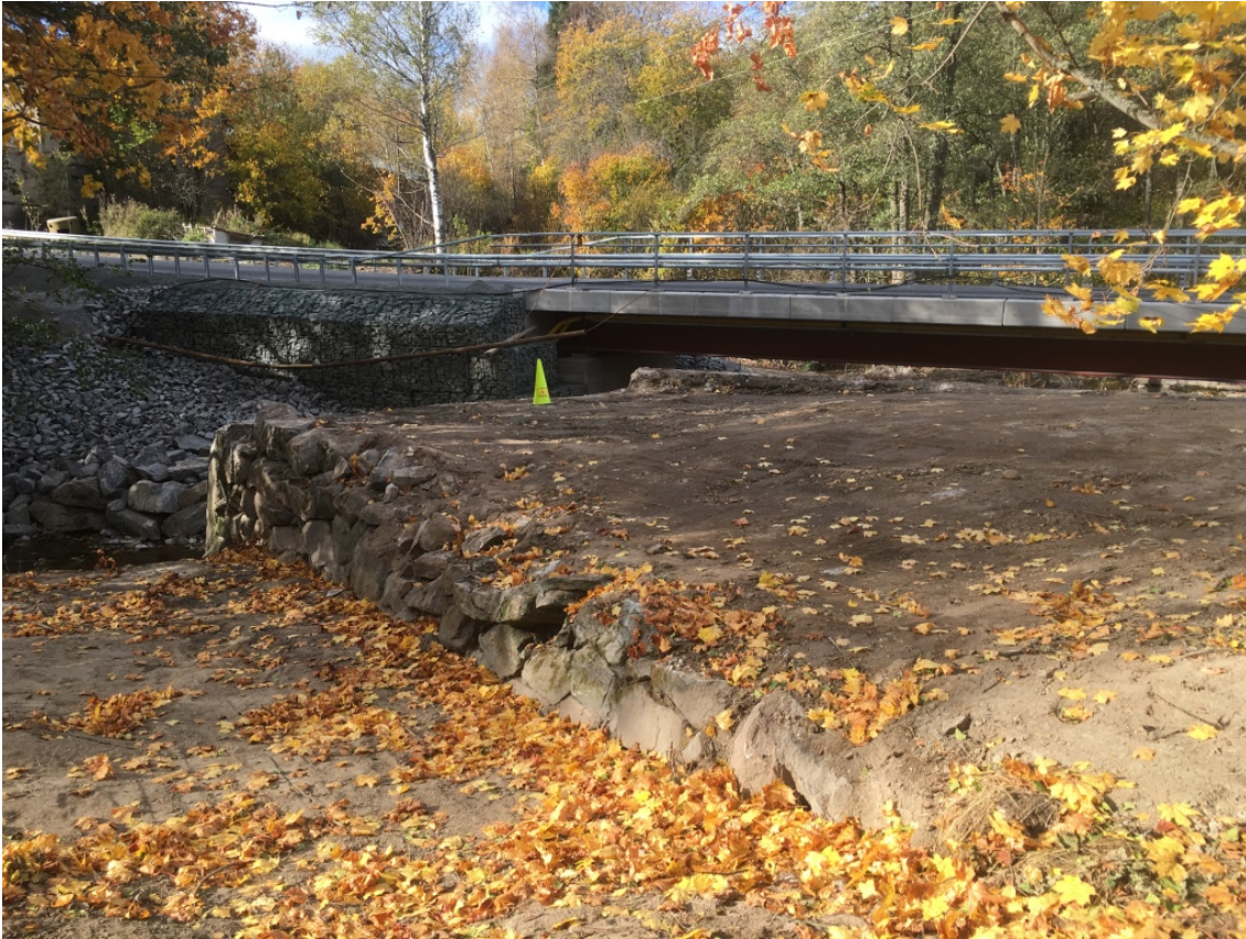
IMG_4896.JPG Patomuuri peitettyä. Taustalla uusi silta. Idästä. 8.10.2016.
