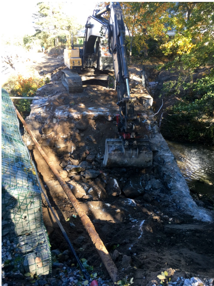
IMG_4811.JPG. Etelärannan patomuurin alkuperäiset perustuskivet paljastuvat pohjalta. Lounaasta. 30.9.2016.
