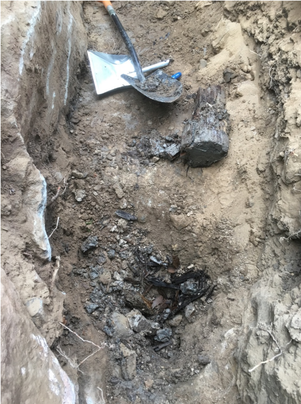
IMG_4681.JPG. Paalu esiin kaivettuna. Paalunsija etualalla. Lounaasta. 22.9.2016.
