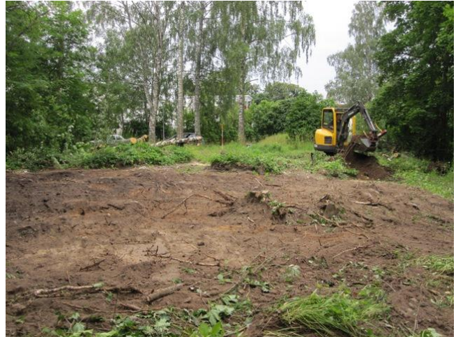
DG2707:4 Kaivausalueelta poistetaan kaivinkoneella pintamaata. Kuva Katja Vuoristo.
