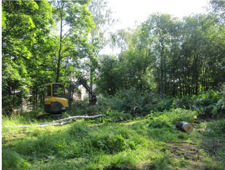
DG2707:3 Kaivausalue on raivattu puustosta, alueen ympäristö on lähes luonnontilassa. SW-NE. Kuva Katja Vuoristo.
