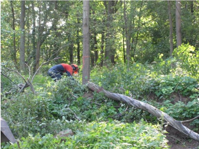
DG2707:1 Perkkäänpuistosta raivataan puita ennen kaivausalueen kuorintaa. Kuva Katja Vuoristo.
