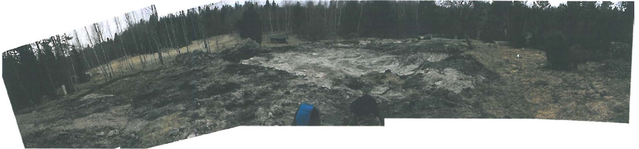
Kuva 2: Kohde pohjoisesta. Kuorittu alue näkyy kahden tulevan rakennuksen paikan välissä, kuvassa vasemmalla. (H Jansson)
