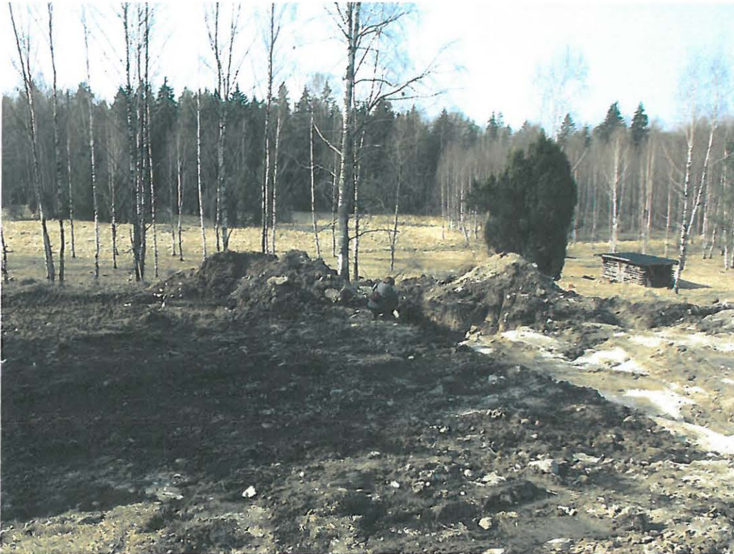
Alue pintamaan kuorinnan jälkeen toukokuussa
