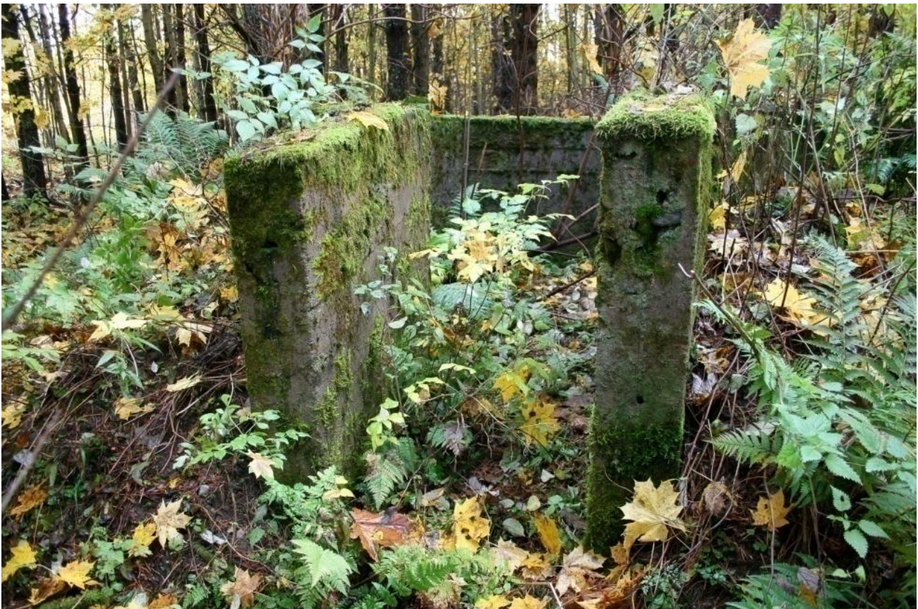
Kuva 7. Betoninen ampuma-asema junaradan läheisyydessä. Kuvattu lännestä. Kuva: Satu Koivisto/MV (AKDG2876:2).
